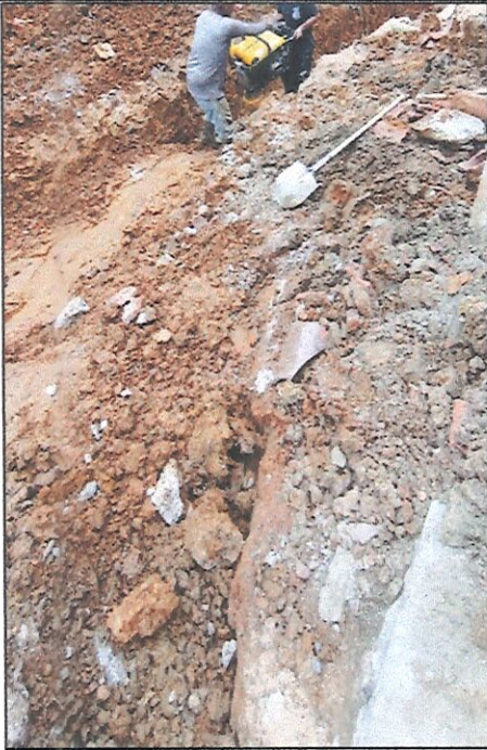
ITEM 3.8 Relleno y compactación con material seleccionado
