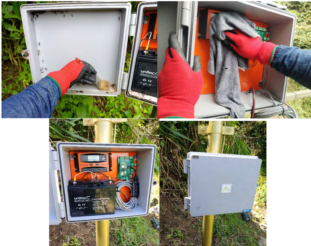
Ilustración 5: Limpieza de gabinete y retiro de componentes obsoletos.
