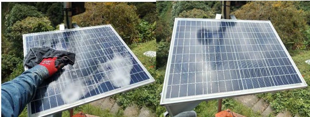
Ilustración 117: Limpieza de paneles solares.
