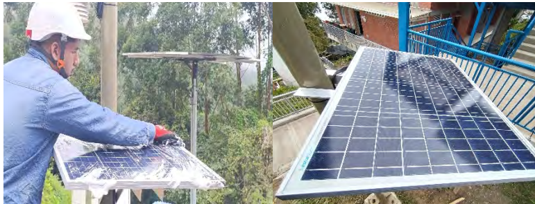
Ilustración 158: Limpieza de paneles solares.
