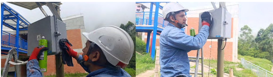
Ilustración 19: Limpieza de gabinete y retiro de componentes obsoletos.
