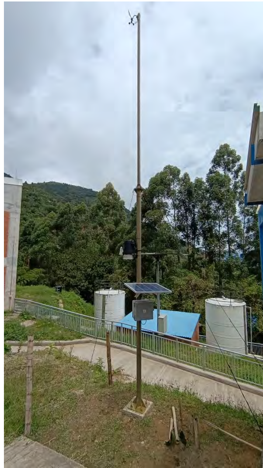
Ilustración 23: Estación de alarma estado final y operativa.
