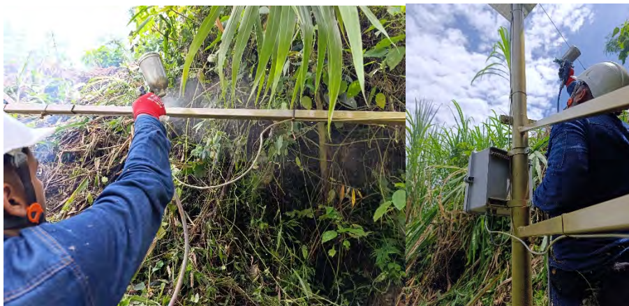
Ilustración 3: Aplique de pintura anticorrosiva.
