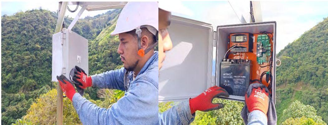
Ilustración 10: Limpieza de gabinete de estación.
