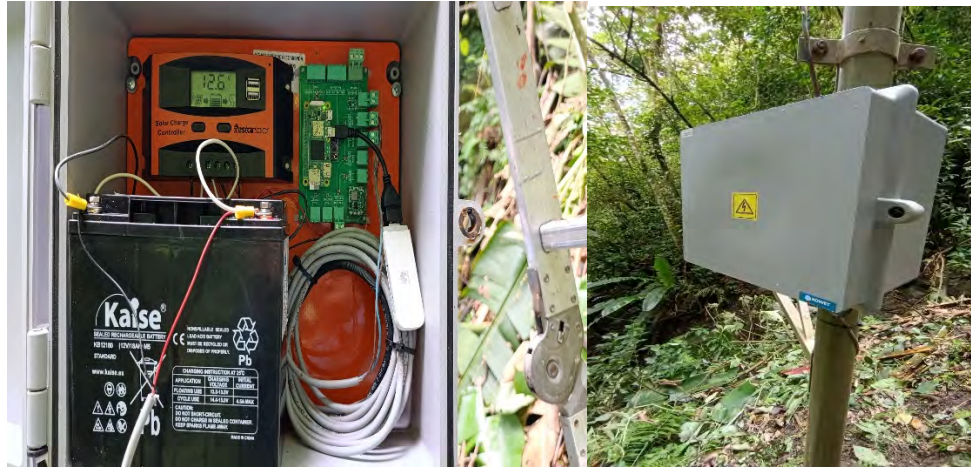
Ilustración 10: Limpieza de gabinete y retiro de componentes obsoletos.
