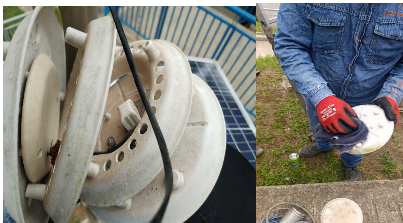
Ilustración 17: Limpieza de sensor de temperatura y humedad.
