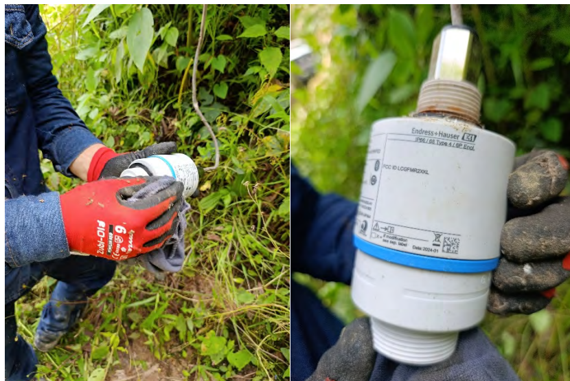
Ilustración 4: Limpieza de sensor de nivel.
