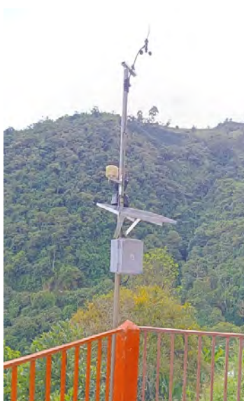
Ilustración 15: Estación de alarma estado final y operativa.
