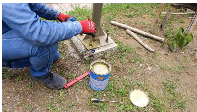
Ilustración 21: Aplicación de pintura.
