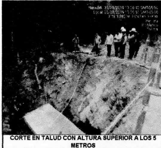
CORTE EN TALUD CON ALTURA SUPERIOR A LOS 5 METROS
