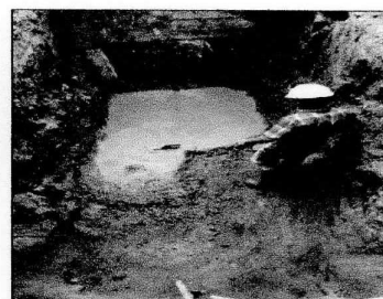
FUNDIDA SOLADO EN PR 5+840
