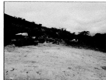
EXTENDIDO Y COMPACTACION DE MATERIAL PRODUCTO DE LA EXCAVACION ZODME PR 1+550
