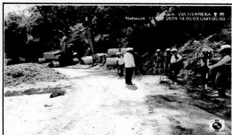
VERIFICACION ALINEAMIENTO DE LAS ALCANTARILLAS PR3+414
