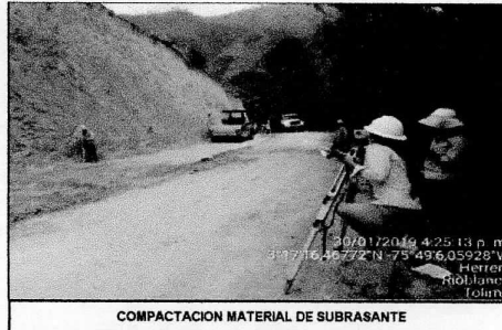
COMPACTACION MATERIAL DE SUBRASANTE
