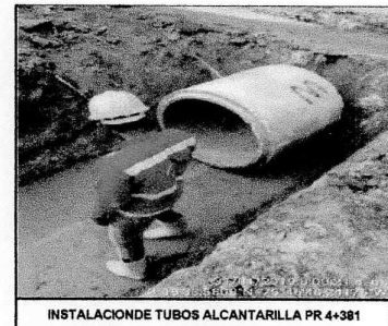
INSTALACIONE TUBOS ALCANTARILLA PR 4+381
