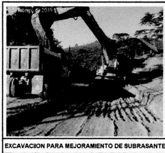
EXCAVACION PARA MEJORAMIENTO DE SUBRASANTE
