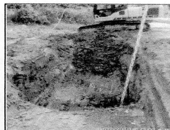
CAJEO PARA EL MEJORAMIENTO DE ZONA PR2+230
