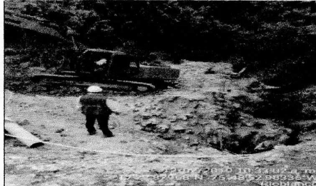
EXCAVACION PARA CORTINA Y ALETAS BOX COULVERT PR 3+660 PROFUNDIDAD 5 METROS
