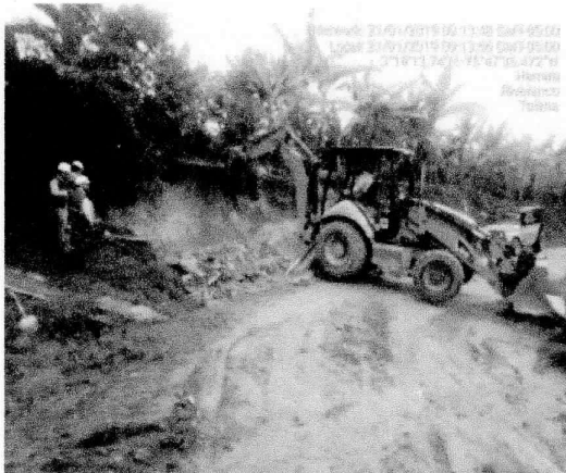
EXCAVACION ALCANTARILLA PR4+208
