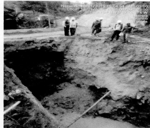
EXCAVACION PARA EL BOX PR3+660
