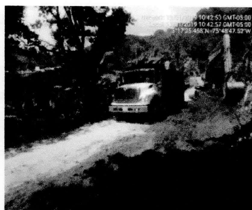
EXCAVACION PARA AMPLIACION PR 0+500
