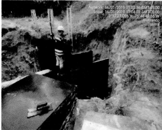
COLOCACION FORMALETA PR0+450
