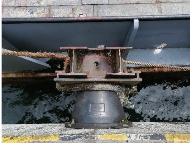
Ilustración 4. Amortiguador en funcionamiento
