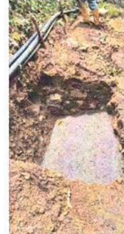
Imagen No. 2 - se evidencia el desarrollo de actividades de Excavación manual en conglomerado
