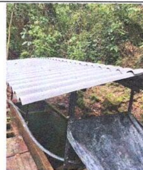
Imagen No. 8. - se evidencia el desarrollo de actividades de Caballete fijo de teja fibrocemento
