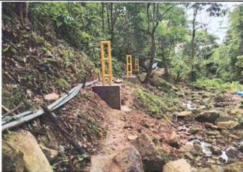
Imagen No. 7. - se evidencia el desarrollo de actividades de concreto de 3000 PSI.
