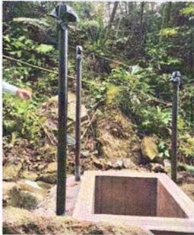
Imagen No.5 - se evidencia el desarrollo de actividades de placa de fondo y muro en concreto de 3000 PSI.
