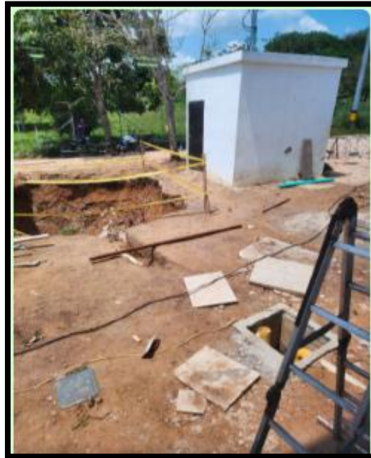
Imagen 2 – Estado actual Pozo No 2
