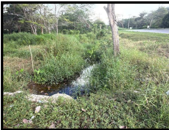
Imagen 5,6,7 y 8 – Canales con taponamiento (obstrucción por vegetación y residuos)
