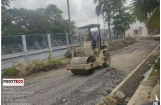
Mejoramiento De La Subrasante Con Material Seleccionado (La Granja)
