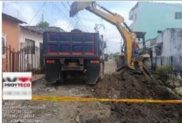
Cargue y retiro de material sobrante (Pastrana Borrero)
