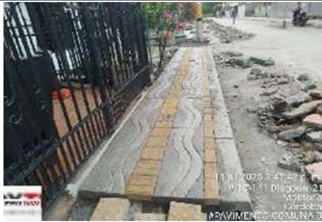
Piso En Concreto Estampado Tipo Ronda, 21 Mpa (3.000 Psi). E=0,08m (La Granja)
