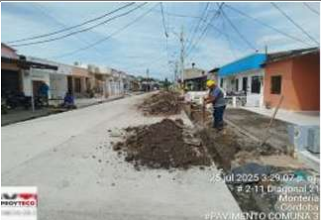
Excavación Manual De Cunetas (La Granja)
