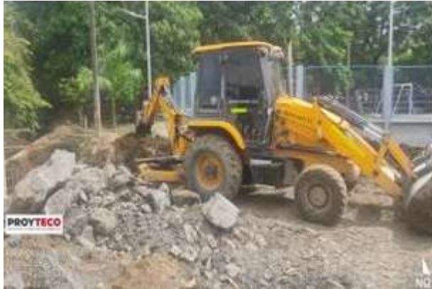
Excavación En Material Común De La Explanación Y Canales (La Granja)
