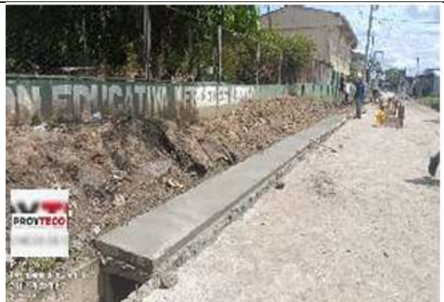
Cuneta De Concreto Vaciada In Situ (Pastrana Borrero)
