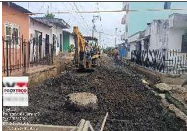
Excavación en material común de la explanación (Pastrana Borrero)
