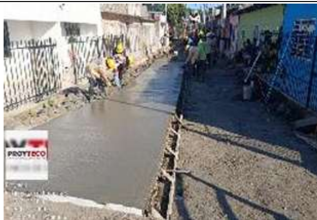
Pavimento De Concreto Hidráulico Mr (40 Kg/Cm2) (Pastrana Borrero)
