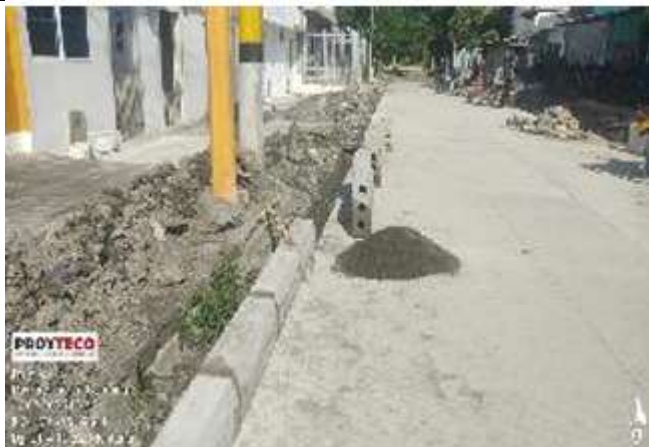
Bordillo De Piezas Prefabricadas De Concreto (La Granja)
