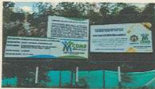
Cerramiento y vallas informativas
