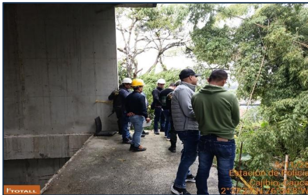
Fotografía 1: Se realizó recorrido de obra en compañía de supervisión, interventoría y obra
