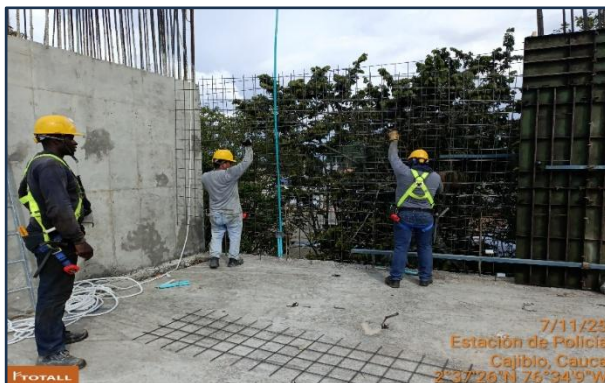
Fotografía 5: Instalación de mallas electrosoldadas para muros no estructurales piso 2 - bloque 2
