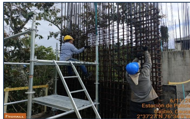
Fotografía 4: Ajuste de ganchos de refuerzo pantalla 10
