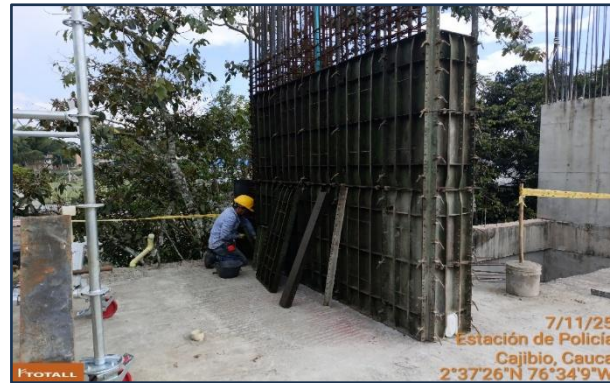
Fotografía 6: Instalación de Formaleta para pantalla y muros no estructurales piso 1 y 2 - bloque 2.
