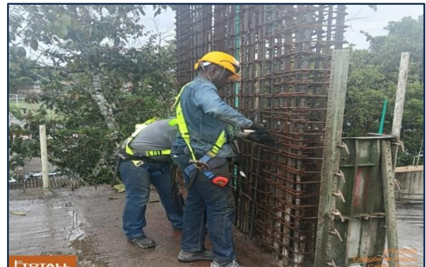
Fotografía 2: Instalación complemento de refuerzo para pantalla
