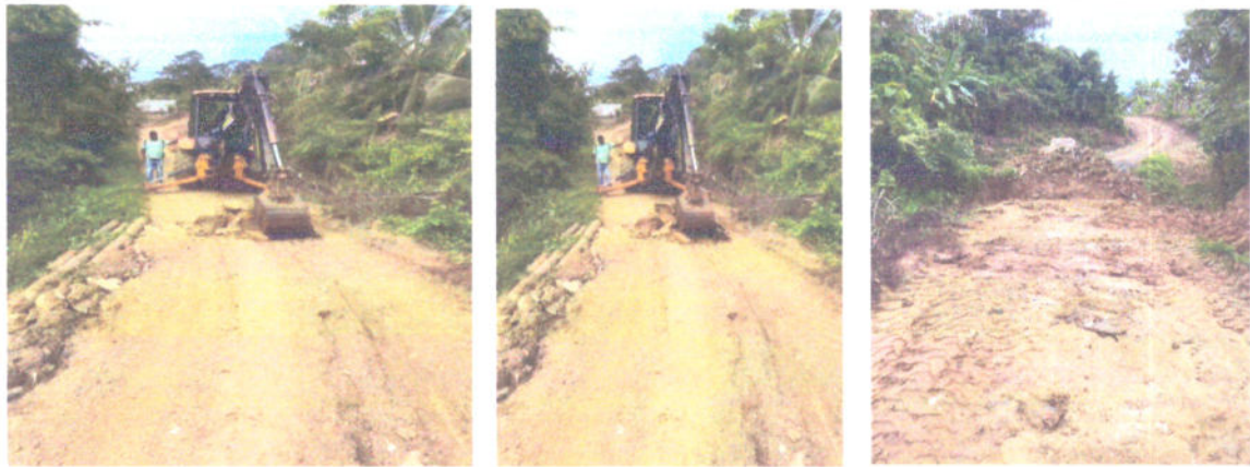
OBSERVACIONES: Excavaciones en material seco
