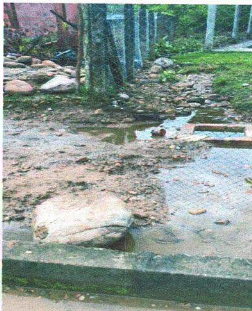
Imprevistos por lluvias en obra
