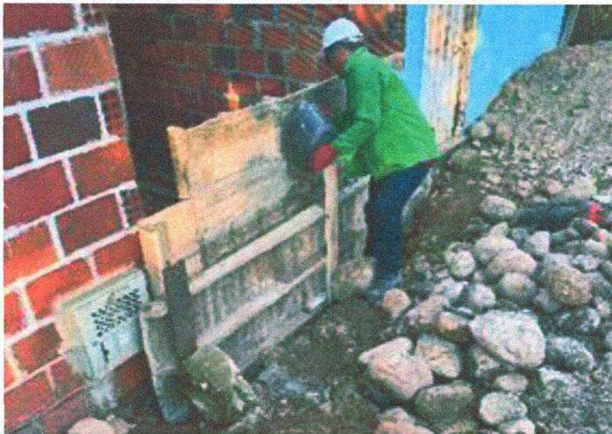
"CONSTRUCCION DE BORDILLO DE 10 X 30 CM. FUNDIDO EN CONCRETO DE 17.5 Mpa. (INCLUYE REFUERZO)."
