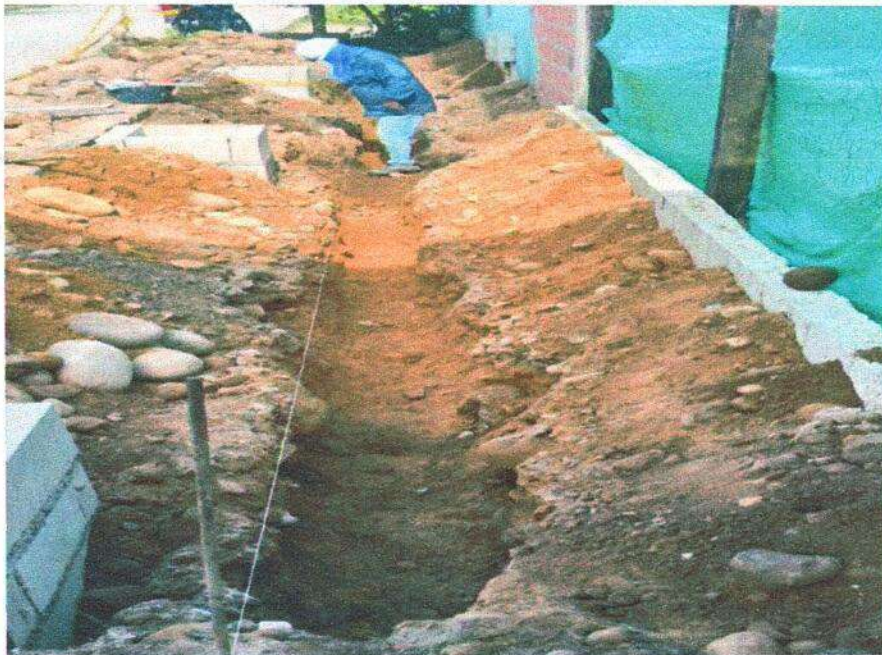
EXCAVACION MANUAL EN MATERIAL COMUN
