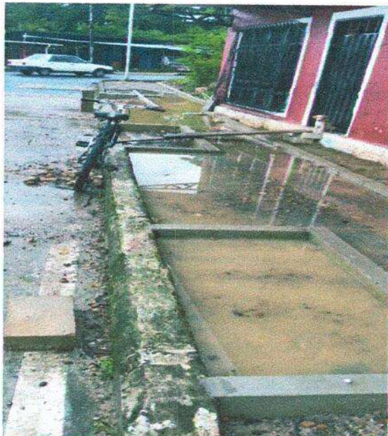
Imprevistos por lluvias en obra
