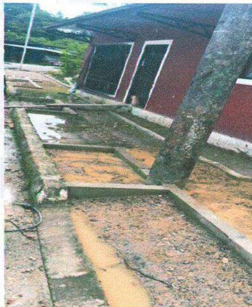
Imprevistos por lluvias en obra
