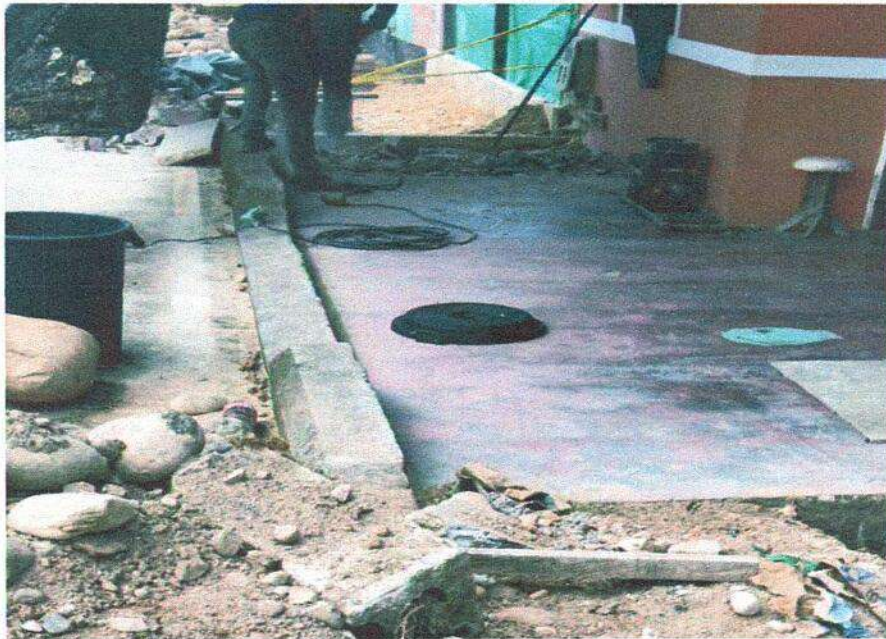
DEMOLICION ANDENES EN CONCRETO
