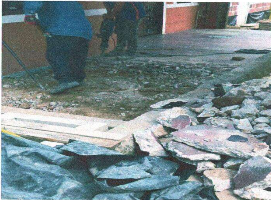
RELLENO CON MATERIAL DE AFIRMADO COMPACTADO RANA
