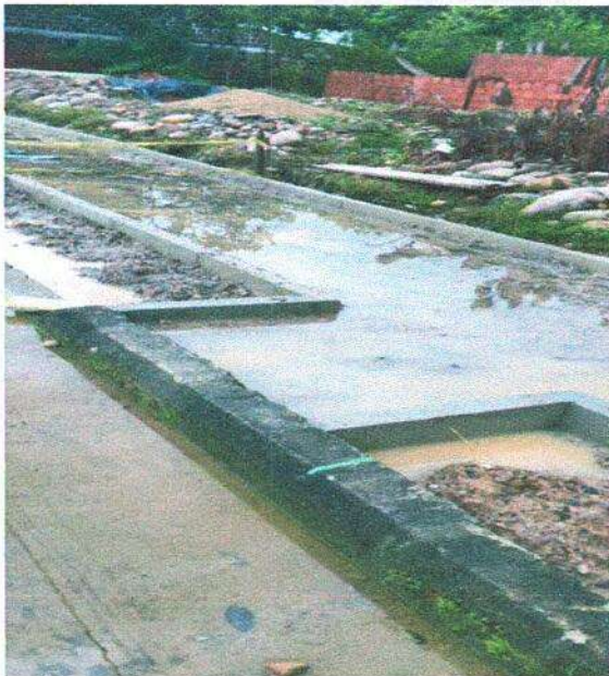
Imprevistos por lluvias en obra
