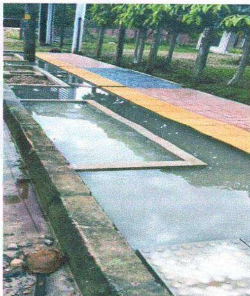
Imprevistos por lluvias en obra
