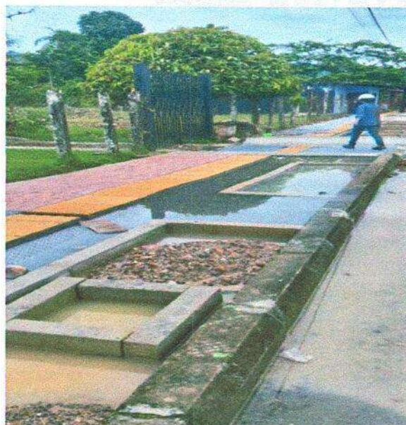
Imprevistos por lluvias en obra
