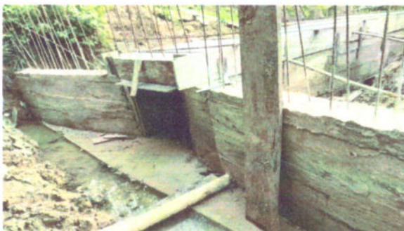
Fotografía 7 Concreto para cajon y bordillos
