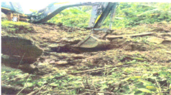
Fotografía 19 Mejoramiento de vía
