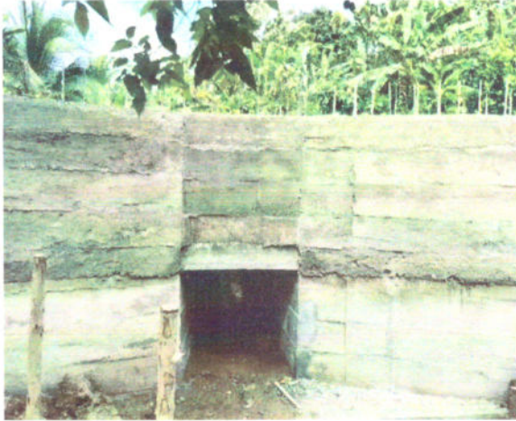
Fotografía 25 Concreto para dentellón, solera y aletas
