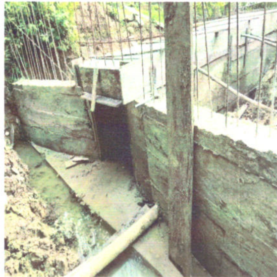
Fotografía 10 Concreto para cajon y bordillos
