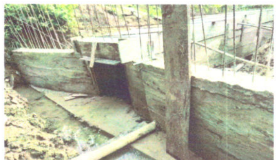
Fotografía 8 Concreto para cajon y bordillos
