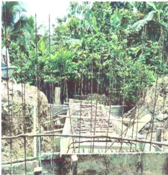
Fotografía 11 Concreto para cajon y bordillos
