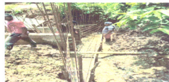
Fotografía 16 Concreto para cajon y bordillos
