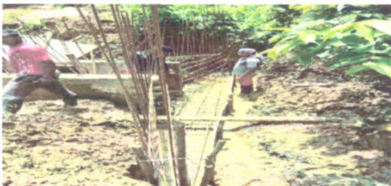
Fotografía 1 Concreto cicoplo protección del Boxculvert
