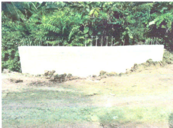
Fotografía 25 Concreto para dentellón, solera y aletas
