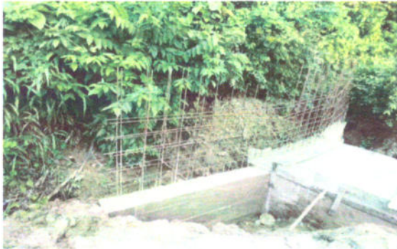
Fotografía 17 Concreto para dentellón, solera y aletas
