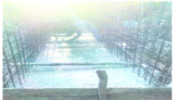
Fotografía 6 Concreto para cajon y bordillos
