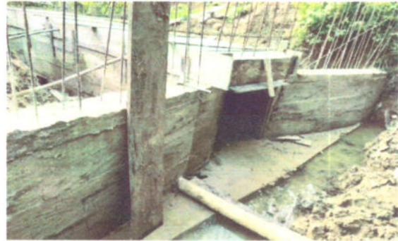
Fotografía 18 Concreto para cajón y bordillos
