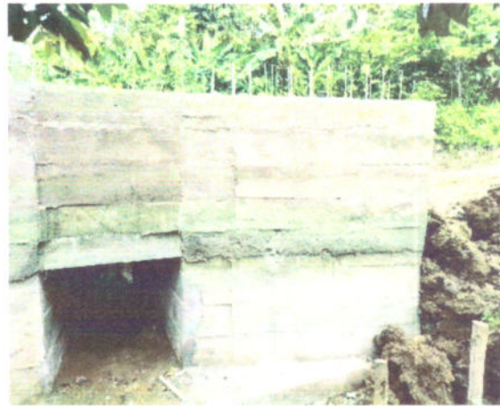
Fotografía 26 Concreto para cajon y bordillos
