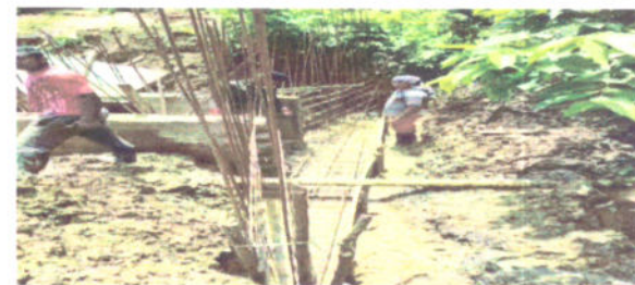
Fotografía 4 Concreto para cajon y bordillos
