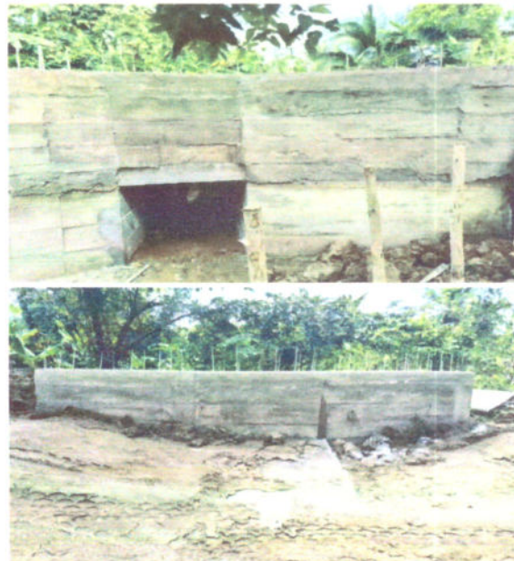
Fotografía 24 Concreto para cajón y bordillos
