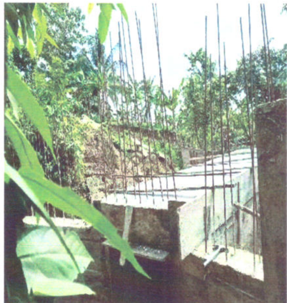
Fotografía 12 Concreto para cajon y bordillos
