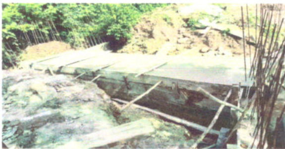
Fotografía 5 Concreto para cajon y bordillos
