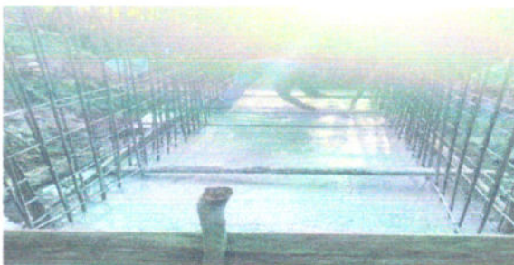
Fotografía 3 Concreto para cajon y bordillos
