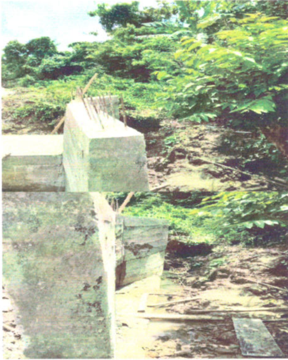
Fotografía 21 Concreto para dentellón, solera y aletas
