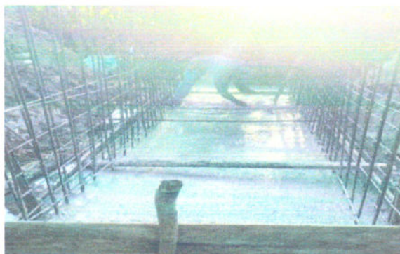
Fotografía 15 Concreto para cajon y bordillos
