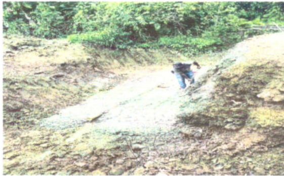
Fotografía 1 Concreto cicoplo protección del Boxculvert
