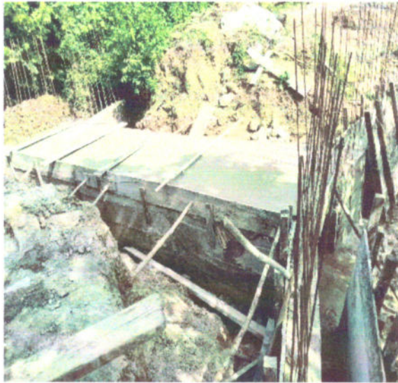
Fotografía 9 Concreto para cajon y bordillos
