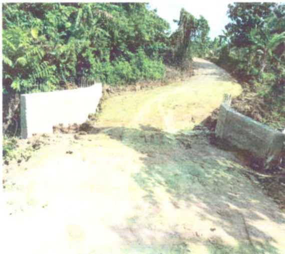
Fotografía 21 Concreto para dentellón, solera y aletas
