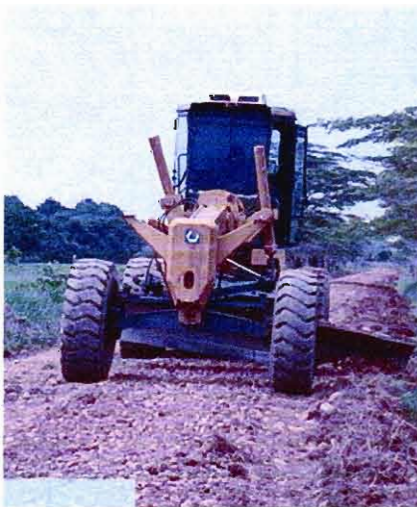
CONFORMACION DE LA BANCA EXISTENTE
