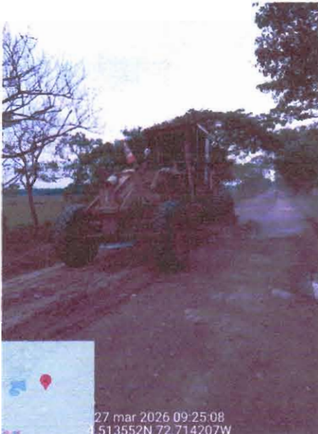
CONFORMACION DE LA BANCA EXISTENTE
