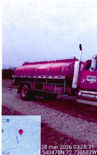
28 mar 2026 07:28:31 4.540470N 72.738682W RIEGO PARA COMPACTACION
