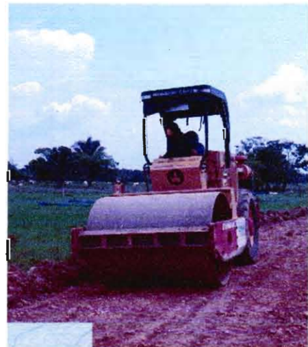
COMPACTACION DEL MATERIAL SUELTO
