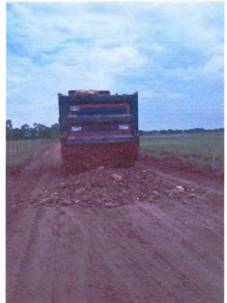
TRANPORTE DE SUB BASE GRANULAR SELECCIONADA
