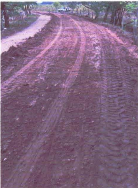
EXTENDIDO DE SUB BASE GRANULAR SELECCIONADA
