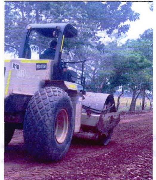
COMPACTACION DE MATERIAL EXTENDIDO
