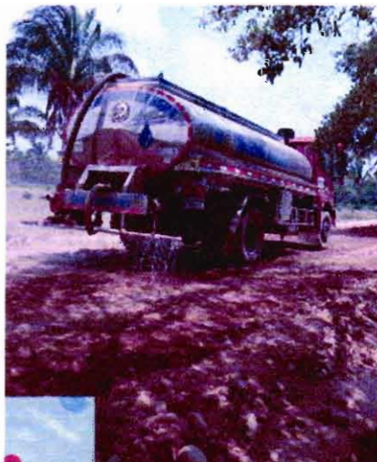
IRIEGO DEL MATERIAL SUELTO
