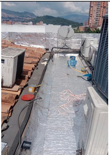
IMPERMEABILIZACION CUBIERTA
