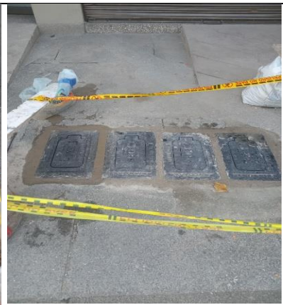
REPOSICION CAJAS MEDIDORES
