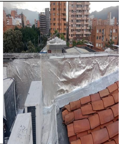
APLICACIÓN PINTURA DE ALUMINIO
