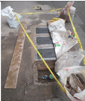
REPOSICION CAJAS MEDIDORES
