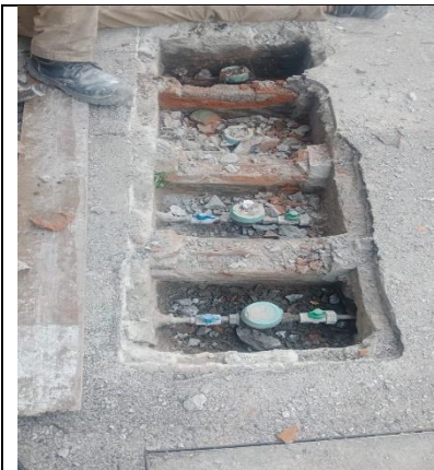
REPOSICION CAJAS MEDIDORES
