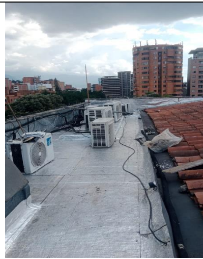
IMPERMEABILIZACION CUBIERTA
