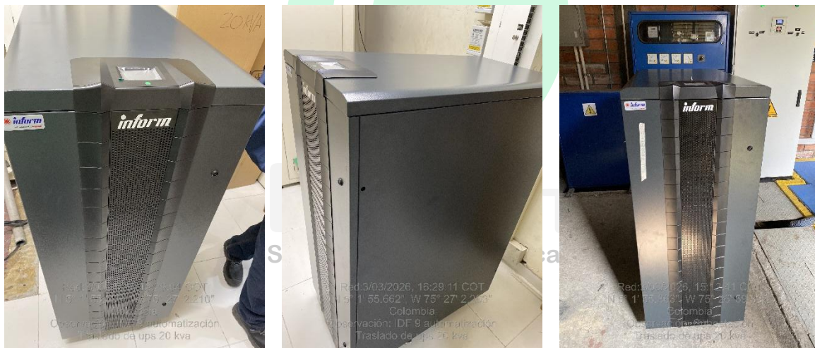
IMAGEN 7 UPS 30KVA – TRIFÁSICA
