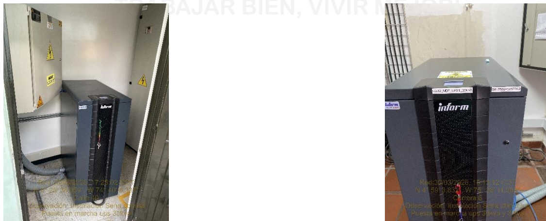
IMAGEN 7 UPS 30KVA – TRIFÁSICA
