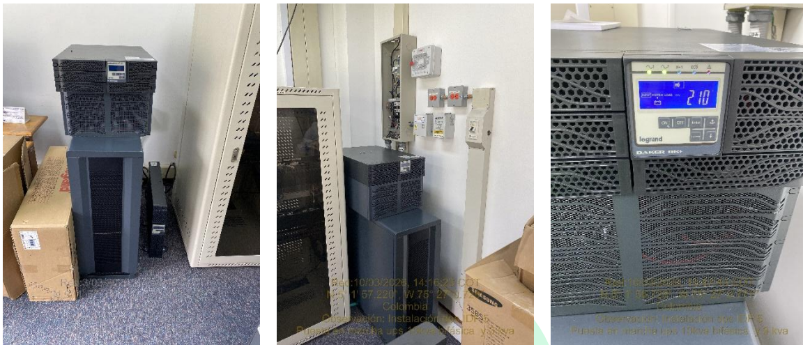
IMAGEN 4 UPS 10kVA – TRIFÁSICA
