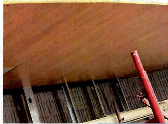
Cielo raso en fibrocemento SIDING MADERA.
