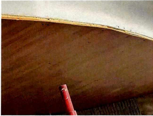
Cielo raso en fibrocemento SIDING MADERA.
