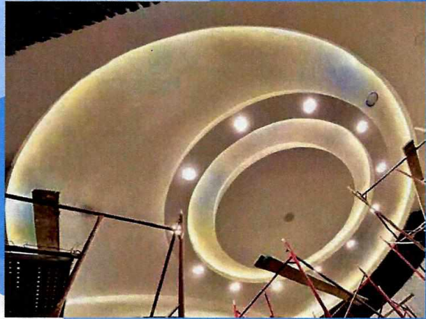
Cielo Raso en Dry Wall figuras circulares.
