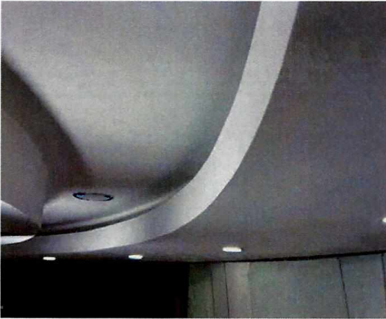
Cielo Raso en Dry Wall figuras circulares.
