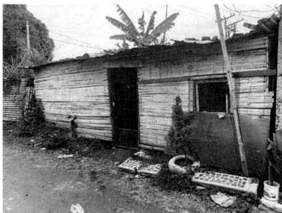
Visita Predio (1) Distrito de Santiago de Cali Comuna 21
