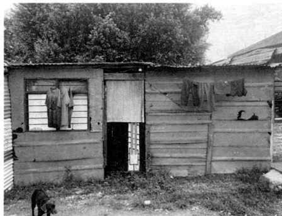
Visita Predio (2 ) Distrito de Santiago de Cali Comuna 21
