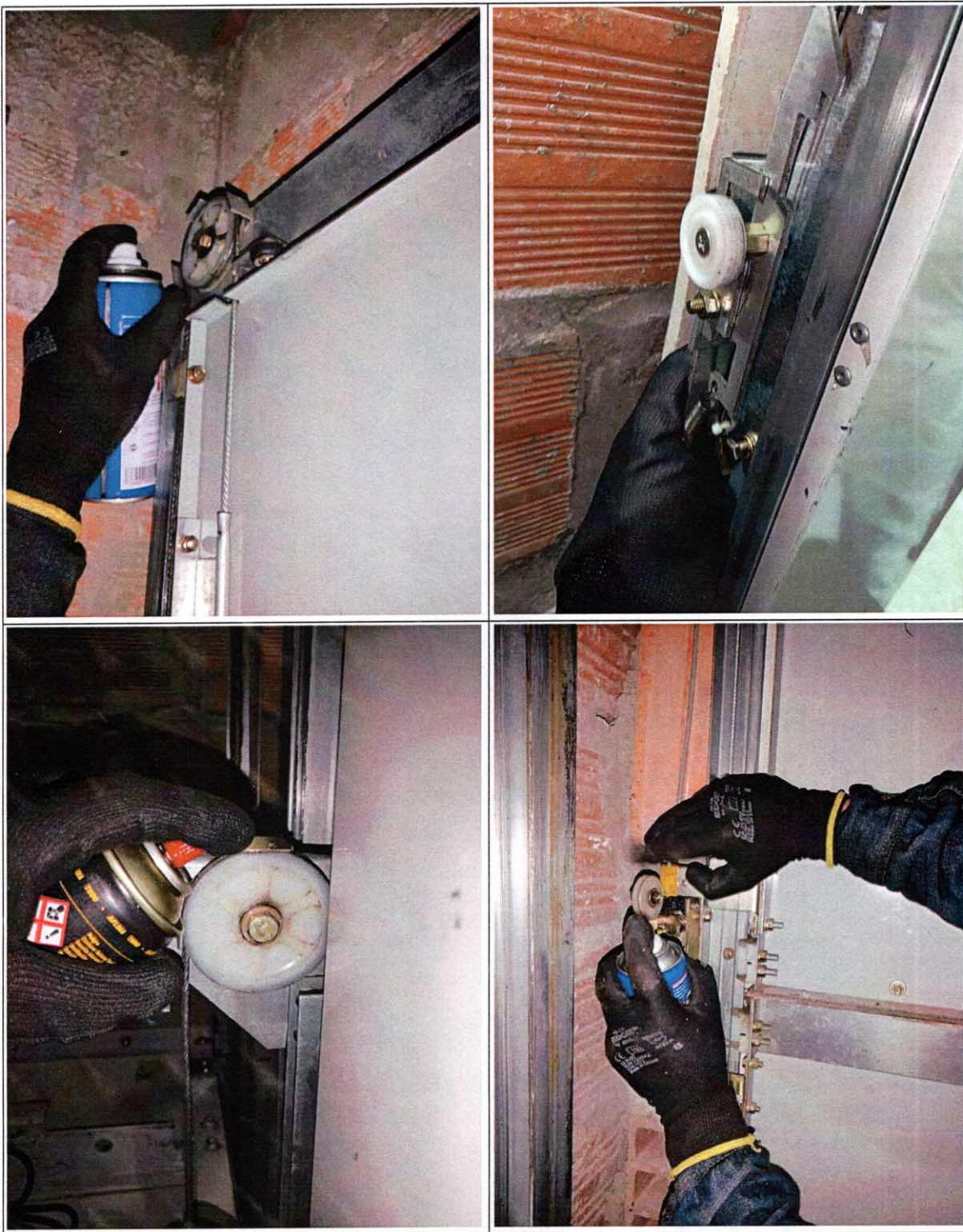
Ilustración 2: Mantenimiento preventivo, limpieza y lubricación a cada uno de los mecanismos de puertas de hall que conforman (correderas, excéntricas, guayas, topes y micros de apertura) verificación a cada uno de los circuitos eléctricos.
