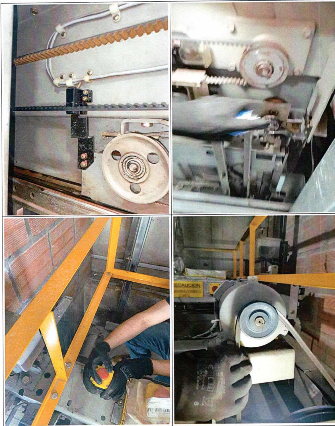
Ilustración 23: Revisión del sistema eléctrico de alimentación sobre cabina, ajuste a la correa del motor de apertura de puertas de cabina, limpieza de quicios y lubricación de los mecanismos (rolletes, excéntricas, rodamientos)
