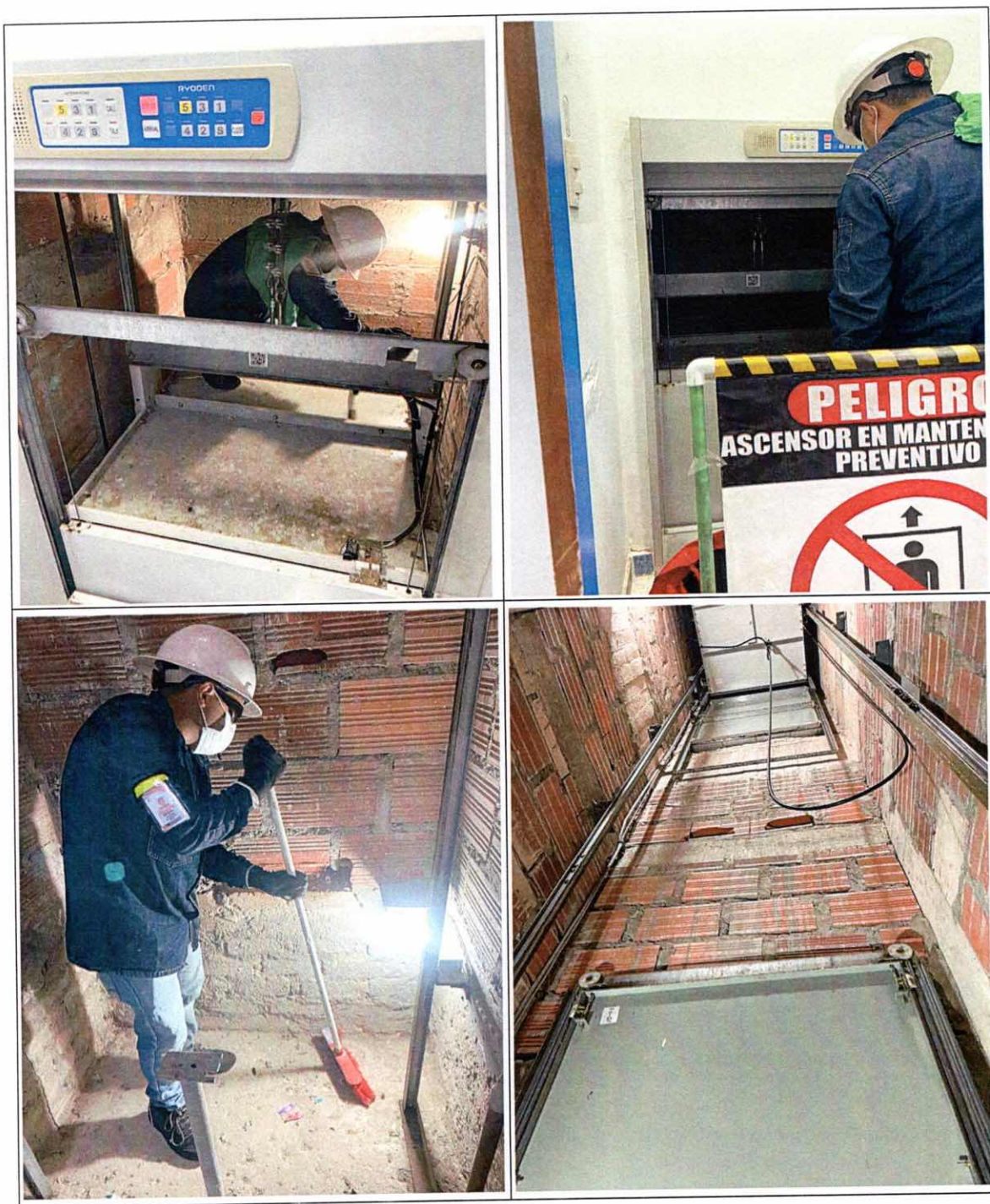
Ilustración 9: Revisión al sistema de comunicación y emergencia en cada una de las paradas, limpieza de foso y verificación a los mecanismos de los sensores de nivelación de la cabina en cada uno de los quicios de las puertas de hall, y lubricación de rieles de cabina y contrapeso.
