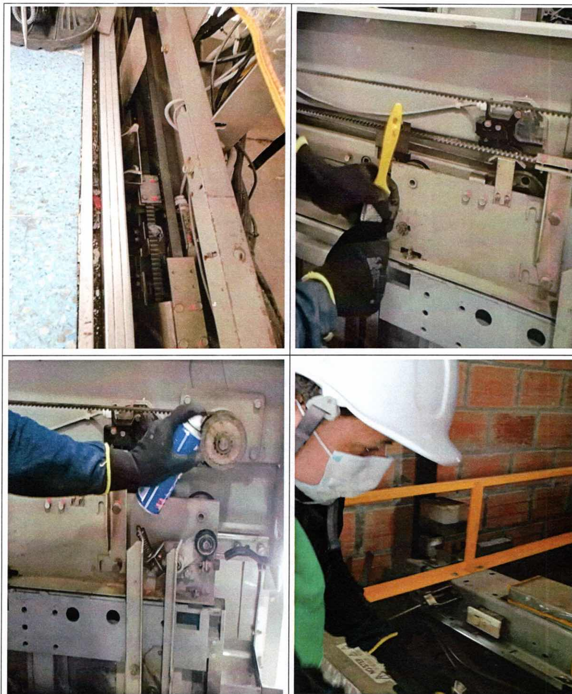
Ilustración 28: Mantenimiento preventivo y lubricación a cada uno de los mecanismos de apertura de puertas en cabina (abrir, cerrar) verificación del estado de las correas, guayas y resortes, revisión y limpieza a los ventiladores en cabina.
