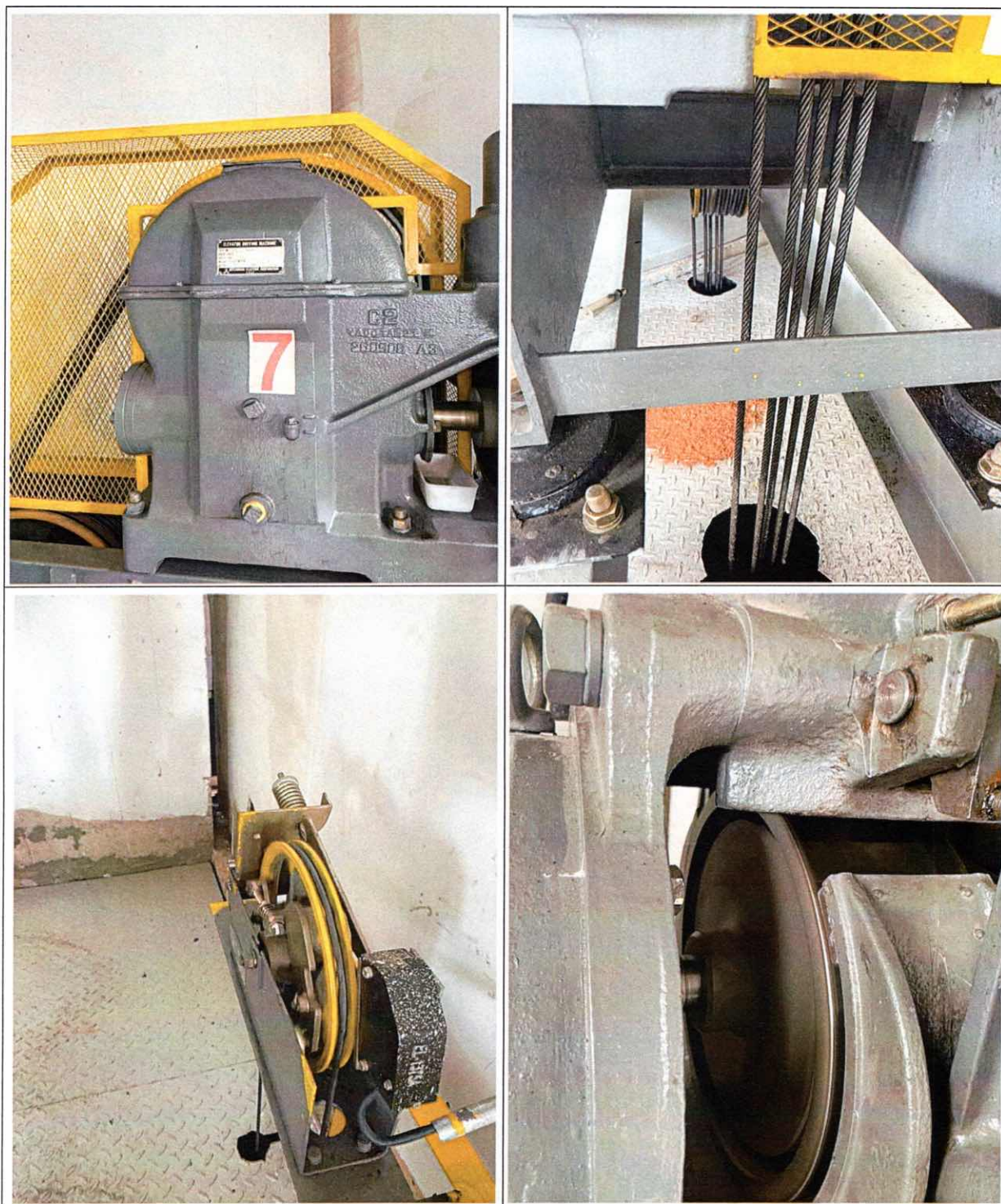
Ilustración 25: Revisión a cada uno de los componentes generales en cuarto de máquinas (motor, polea deflectora, verificación eléctrica al cuadro de control principal, verificación del estado de los cables de tracción, verificación al sistema de electro freno, verificación del limitador de velocidad (gobernador).
