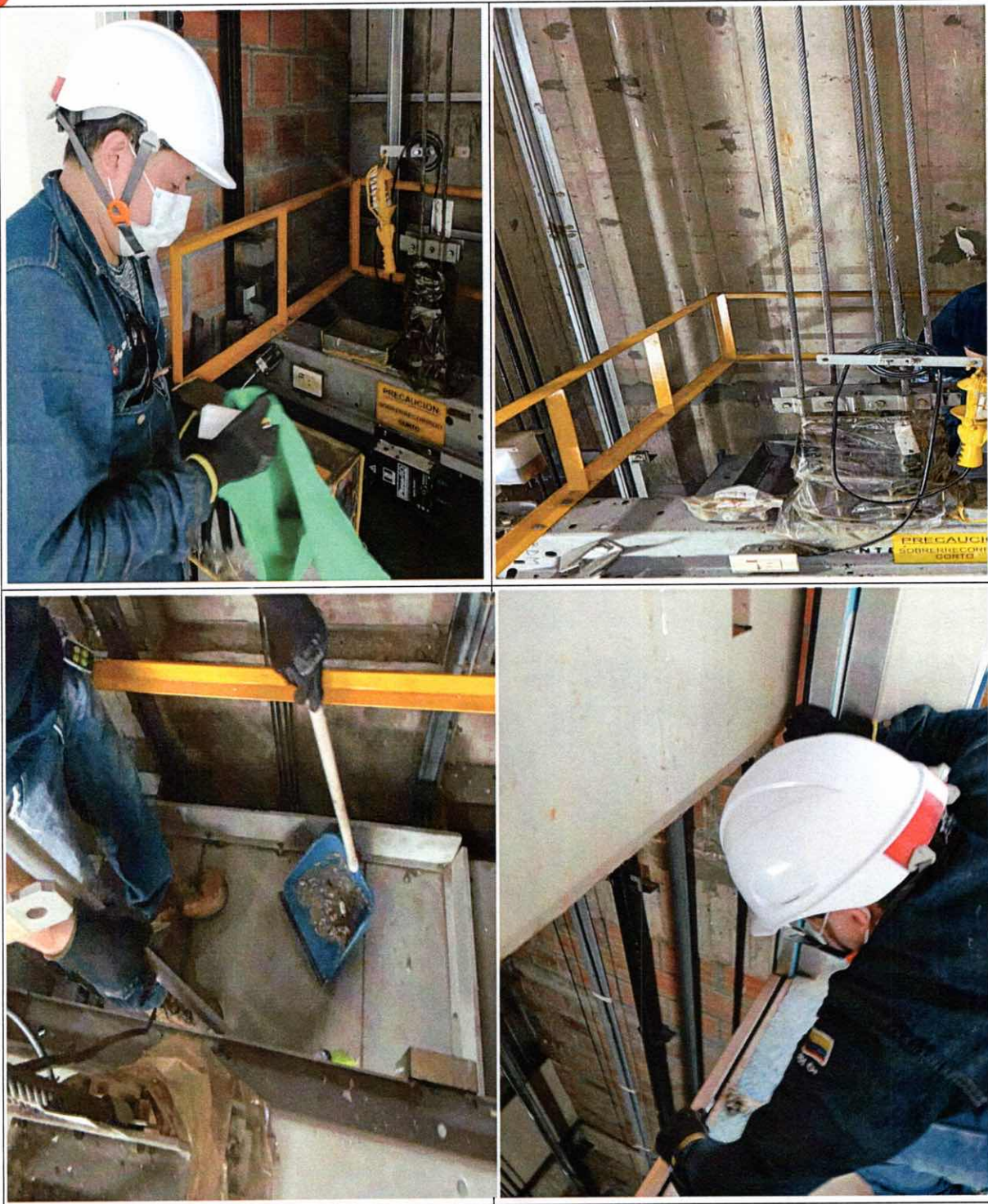
Ilustración 18: Mantenimiento preventivo, limpieza y lubricación a cada uno de los mecanismos de apertura y cierre en puertas de cabina que conforman (correderas, excéntricas, guías, contactos, resortes, poleas y guaya).
