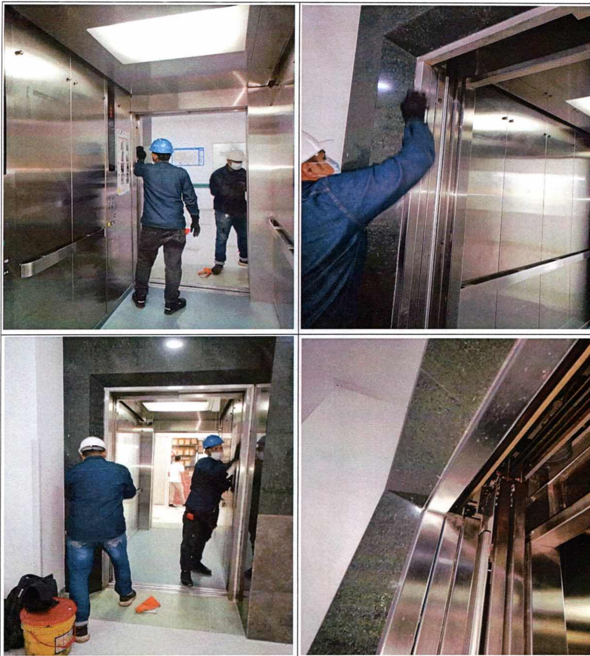
Ilustración 31: Se realizó el mantenimiento correctivo de los marcos de las puertas de hall en acero inoxidable, correspondientes a los equipos 4 y 5 en acero inoxidable tipo 430, y 6 y 7 en acero inoxidable tipo 304, ejecutado por cada parada (piso). La actividad incluyó lijado y satinado de los marcos, con el fin de eliminar corrosión superficial, manchas, rayones y deterioro ocasionado por el uso permanente, el contacto constante de los usuarios y la aplicación de productos de limpieza, restableciendo así su acabado estético y protección superficial.
