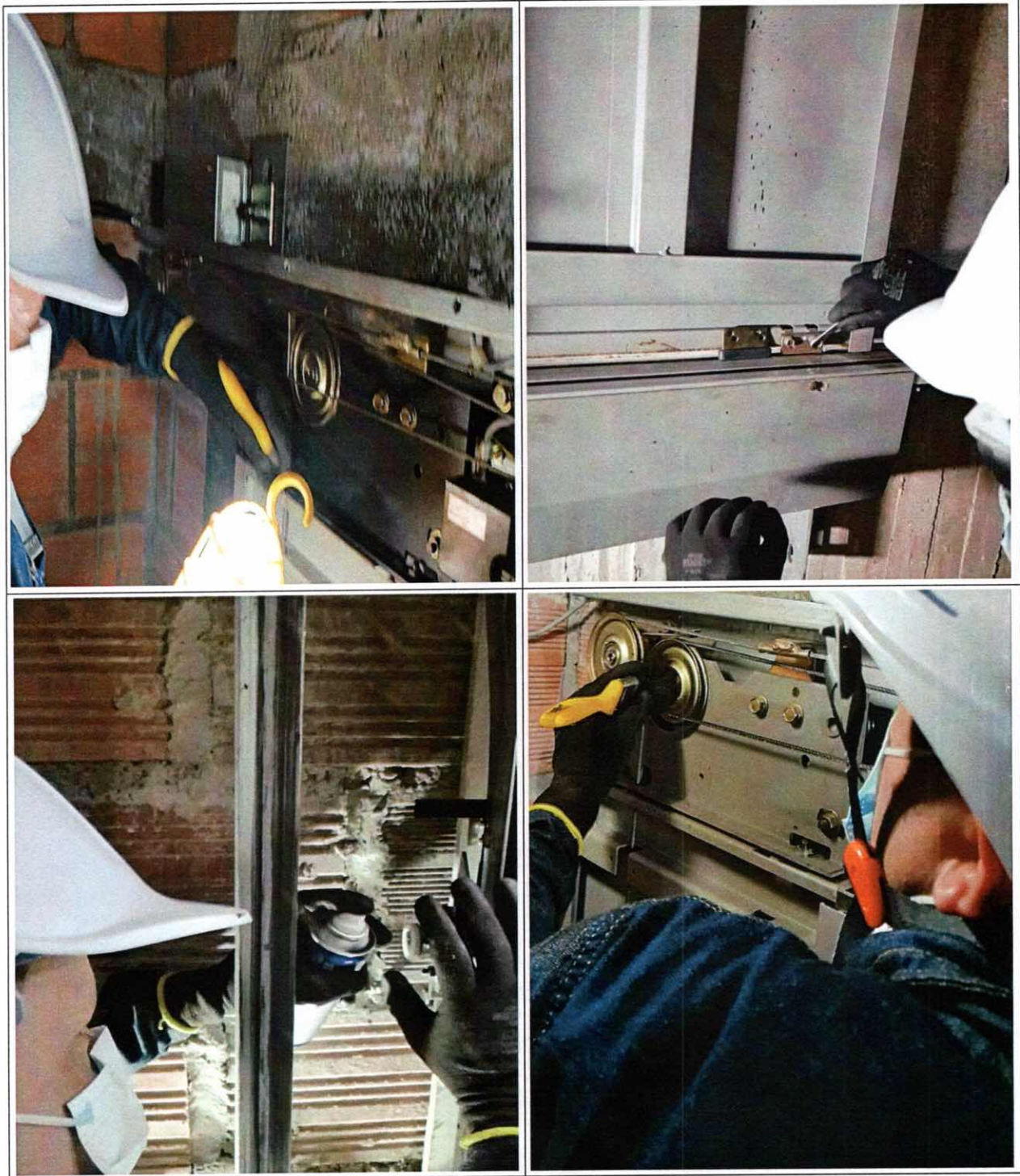
Ilustración 17: Mantenimiento preventivo limpieza y lubricación a cada uno de los mecanismos de apertura en puertas hall y de cabina que conforman (correderas, excéntricas, guías, contactos, resortes, poleas y guaya), cambio kit de zapatas ajuste y calibración.
