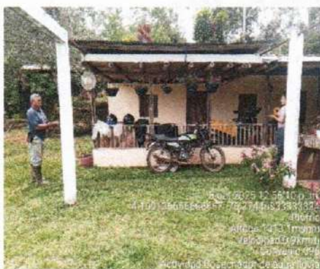
Imagen 7. Antes, Vivienda sin estructura de captación de agua
