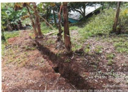
Imagen 44. Durante, Adecuación de la red de conducción del agua residual de las viviendas al reactor
