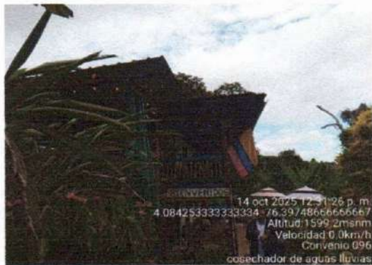
Imagen 21. Antes, Vivienda sin estructura de captación de aguas lluvias.
