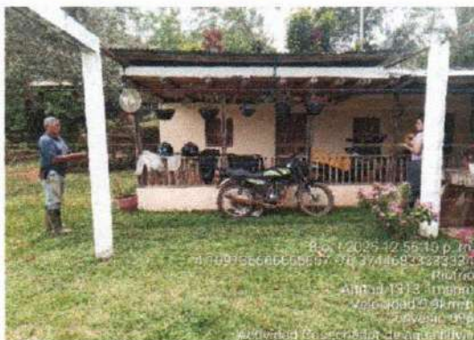
Imagen 12. Antes, Vivienda sin estructura de captación de agua
