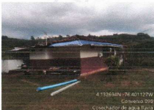
Imagen 16. Proceso de instalación de las canales receptoras de agua
