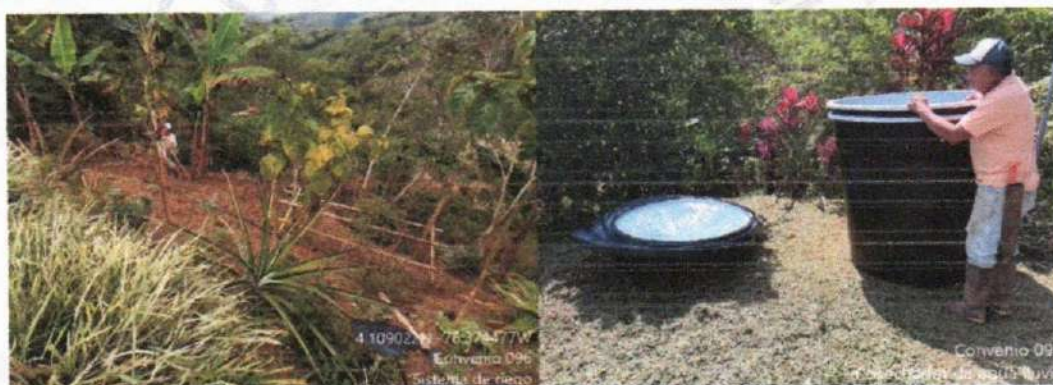
Imagen 31. Durante, Preparación de terreno para la implementación de sistema de riego
