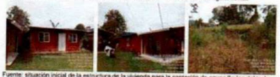
Imagen 9. Antes, estado de estructura de captación y área de reservorio de aguas lluvias
