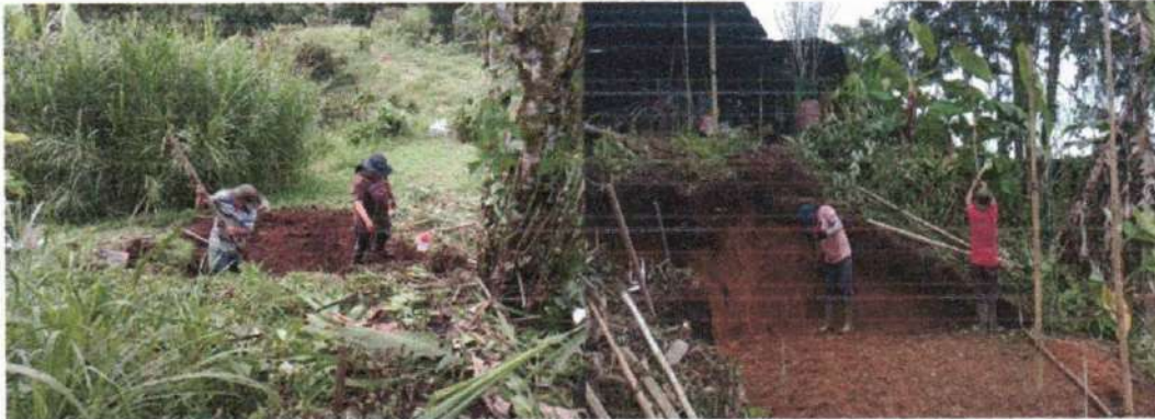
Imagen 44 adecuación de terreno
