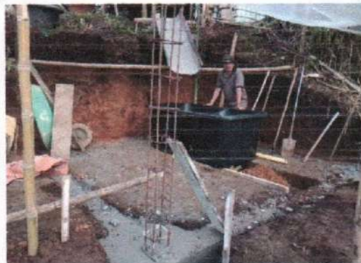
Imagen 45 durante el proceso fundición de losa
