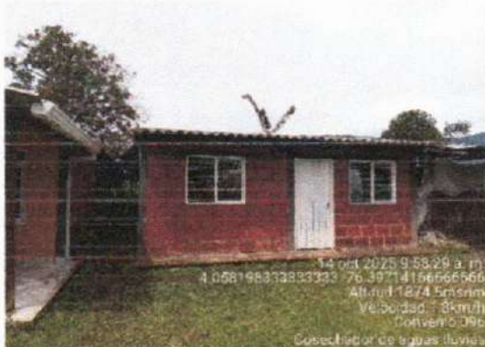
Imagen 18. Antes, estado de estructura de captación y área de reservorio de aguas lluvias
