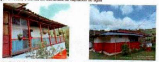
Imagen 8. Antes, Vivienda sin estructura de captación de agua
