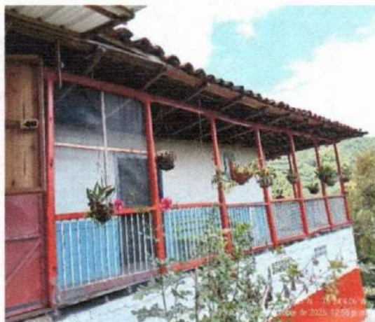
Imagen 15. Antes, Vivienda sin estructura de captación de agua
