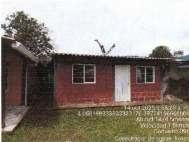
Imagen 18. Antes, estado de estructura de captación y área de reservorio de aguas lluvias
