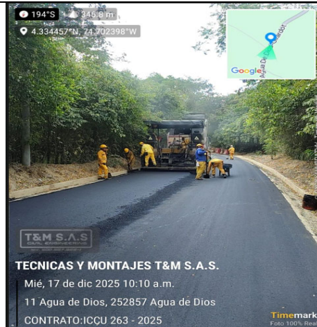
Fotografía 4: Actividades de Instalación MDC 19
