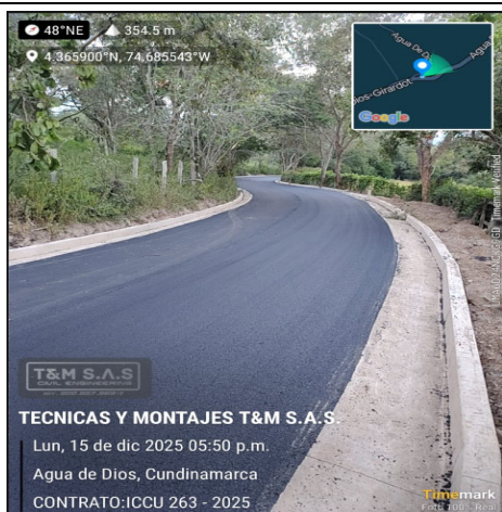
Fotografía 3: Actividades de Instalación MDC 19
