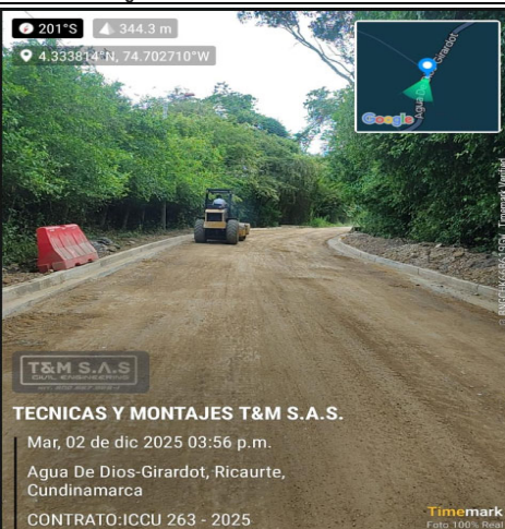
Fotografía 5: Instalación y compactación de Base Granular
