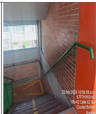
Se realizó la instalación de baranda metálica en punto fijo de los costados oriental y occidental del primer al tercer piso.
