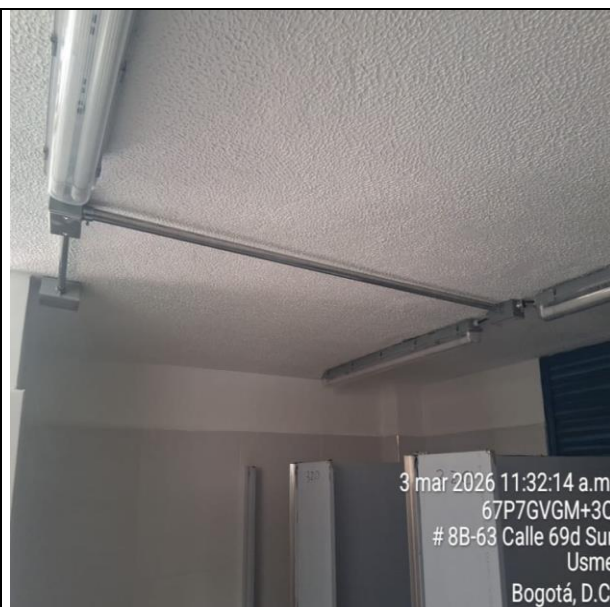
Baño mujeres. Instalación de tubería eléctrica, cableado eléctrico, instalación de lampara en techo. Instalación de divisiones de baño en acero inoxidable.
