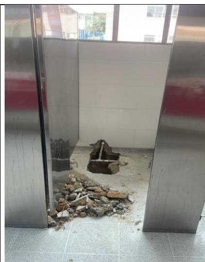
Baños hombres del segundo piso. Demolición de baldosa en granito para detección de humedad hacia piso inferior.
