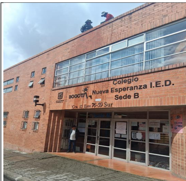
Fachada Principal: Se realiza el lavado e impermeabilizado de ladrillo a la vista
