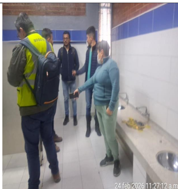
Visita técnica de obra para establecer presupuesto – Colegio Estancia Sede B. Remodelación baño.
