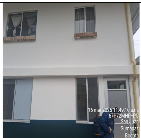
Visita técnica de obra para establecer presupuesto Colegio san Juan de la Cruz. Instalación de reja contra impactos
