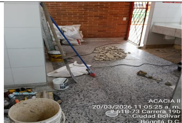
Baño mujeres segundo piso costado oriental. Demolición de piso en granito pulido para ubicación de filtración de agua hacia techo del piso inferior.
