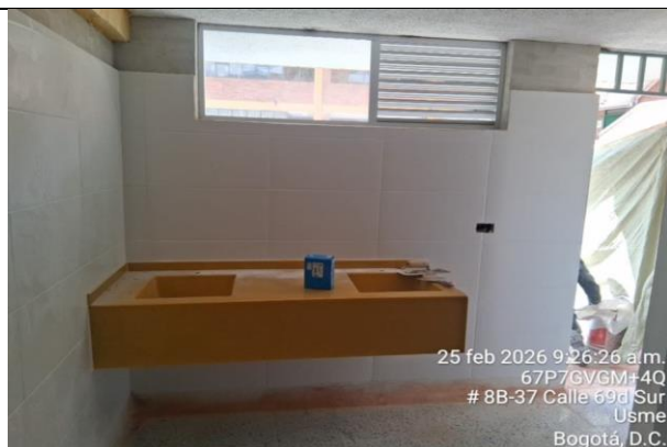
Baño mujeres. Instalación de mueble lavamanos en policuarzo. Ventanería en aluminio.
