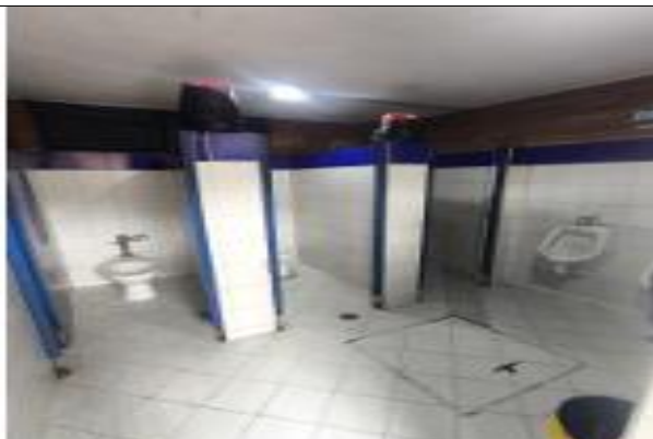
Baño Hombres. Se observa estado inicial de baño de caballeros ubicado en el primer piso.
