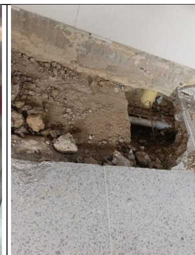
Baño hombres del tercer piso. Demolición de piso en baldosa en granito bajo mesón.
