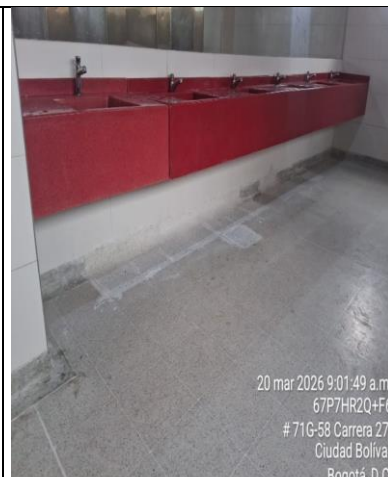
Baño hombres del tercer piso. Una vez detectada la humedad se procede al lleno y colocación de baldosa en granito.
