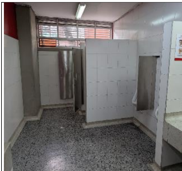
Baño Hombre. Se observa estado inicial de los baños ubicados en el primer piso costado oriental.
