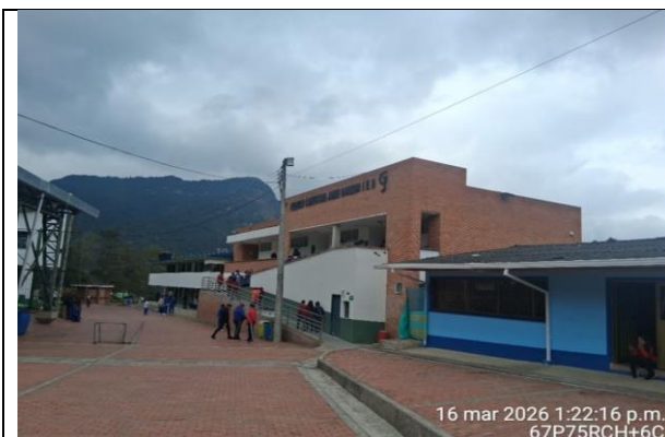
Visita técnica de obra para establecer presupuesto Colegio campestre Jaime Garzón
