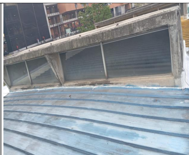
Cubierta. Se realizó el sellado perimetral en cubierta existente.
