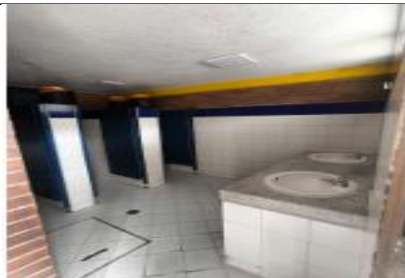
Baño mujeres. Se observa estado inicial de baño
