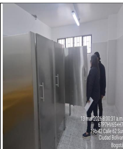
Baño mujeres. Estado final de la remodelación de espacio de baño de damas.
