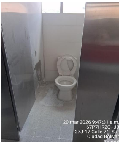
Baños hombres del segundo piso. Instalación de sanitario. Se realizó dicha intervención en dos (02) baños.
