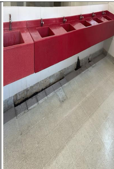
Baño hombres del tercer piso. Una vez detectada la humedad se procede al lleno y colocación de baldosa en granito.
