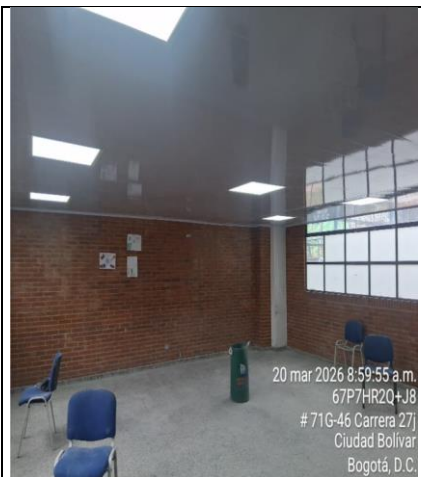
Salón 201. Instalación de techo en PVC. Instalación de lámparas.
