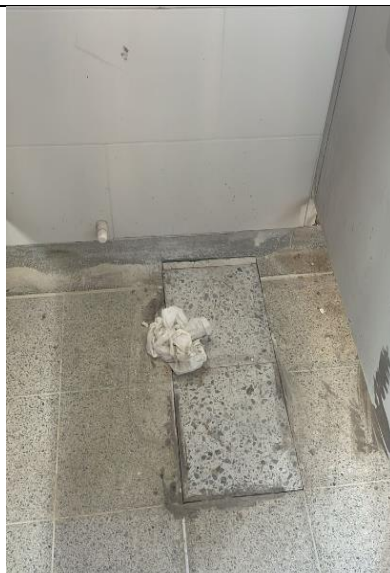
Baños hombres del segundo piso. Una vez detectada la humedad se procede al lleno y colocación de baldosa en granito.
