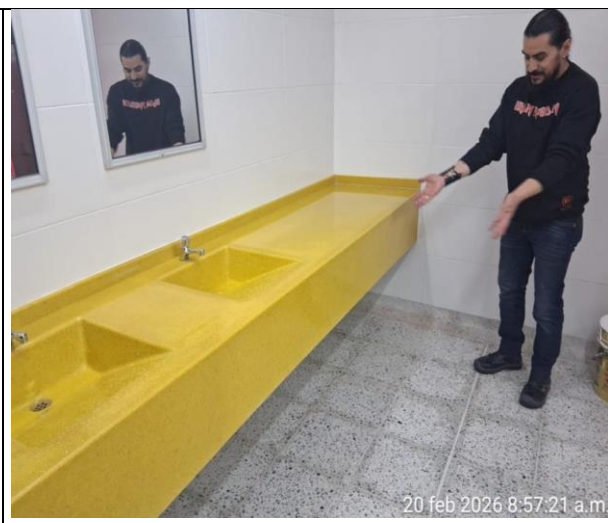
Baño mujeres: Instalación de espejos. Grifería lavamanos.
