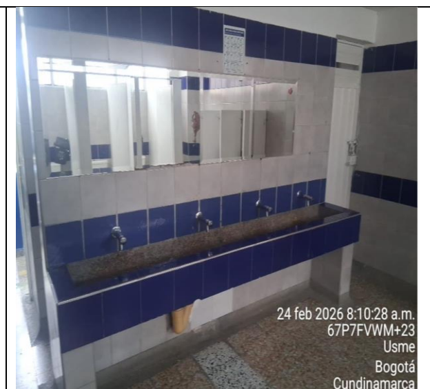
Visita técnica de obra para establecer presupuesto – Colegio Usminia IED Sede A. Se observa zona de baños para remodelación.
