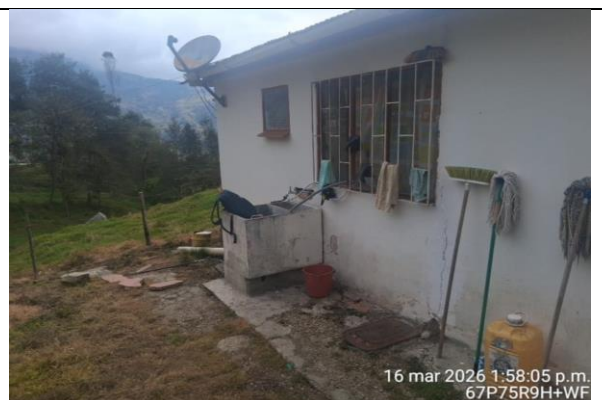
Visita técnica de obra para establecer presupuesto Colegio campestre Jaime Garzón – Adecuación batería sanitaria
