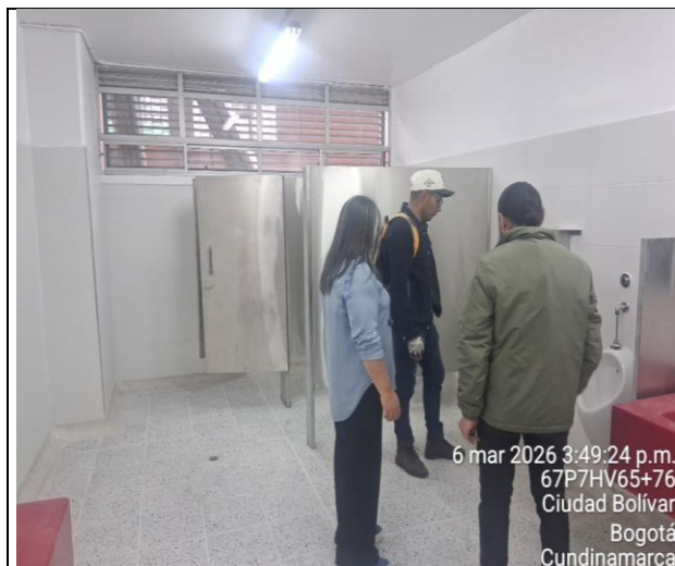
Baño Hombres. Se realiza entrega del baño a la rectora del colegio Acacias II, en compañía del contratista de obra e interventoría.
