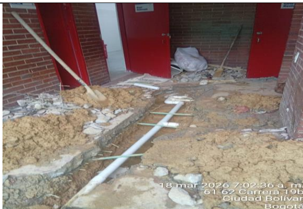
Almacén. Demolición de piso en tableta en gres, cambio de tubería PVC agua potable.
