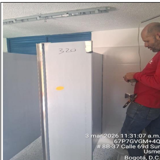
Baño Hombres. Suministro e instalación de divisiones de baños en acero inoxidable. Instalación de tubería eléctrica, cableado eléctrico.
