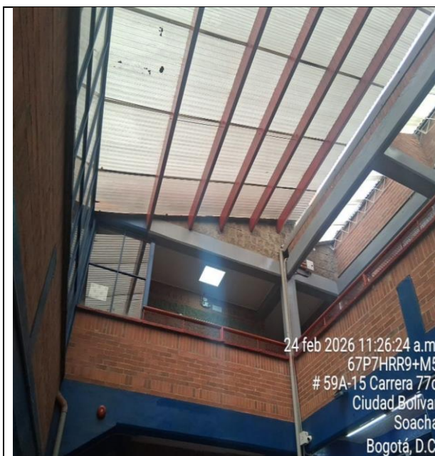
Visita técnica de obra para establecer presupuesto – Colegio Estancia Sede B. Cambio de cubierta
