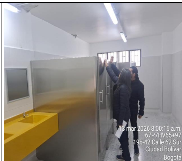
Baño mujeres. Se observa directora del Colegio Acacias II realizando el recibo de la remodelación del baño de mujeres.
