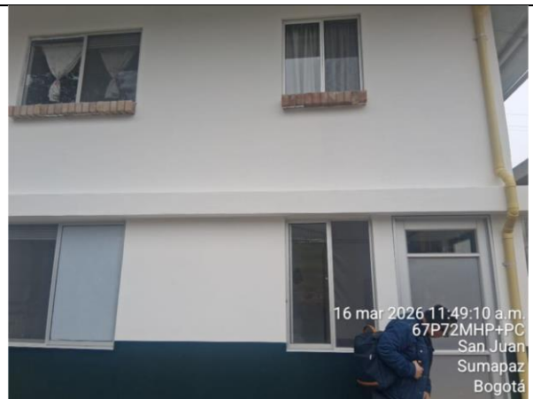
Visita técnica de obra para establecer presupuesto Colegio san Juan de la Cruz. Instalación de reja contra impactos
