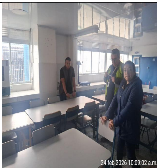
Visita técnica de obra para establecer presupuesto – Colegio Canadá IED. Sistema de bombeo. Cambio de red hidráulica.
