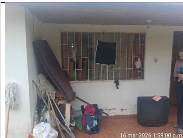
Visita técnica de obra para establecer presupuesto Colegio campestre Jaime Garzón – Adecuación batería sanitaria alojamiento profesores
