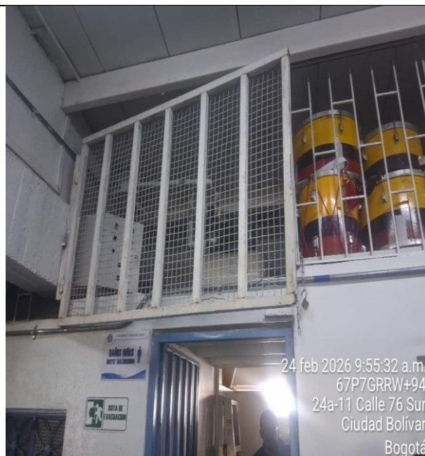
Visita técnica de obra para establecer presupuesto – Colegio Canadá IED. Sistema de bombeo. Cambio red hidráulica.
