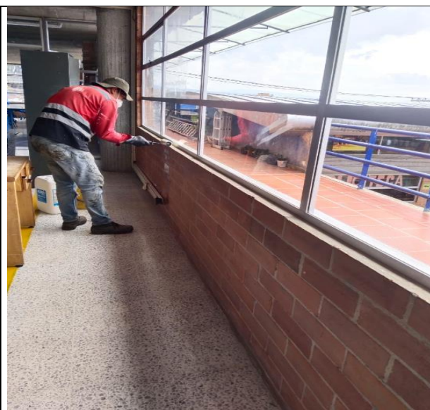
Muros internos. Se realizó el lavado e impermeabilizado de muros internos.
