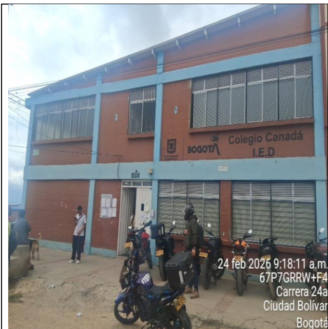
Visita técnica de obra para establecer presupuesto – Colegio Canadá IED
