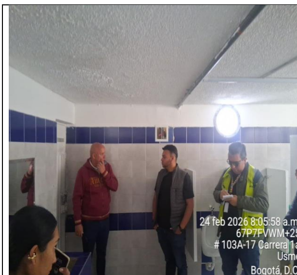
Visita técnica de obra para establecer presupuesto – Colegio Usminia IED Sede A. Se observa zona de baños.
