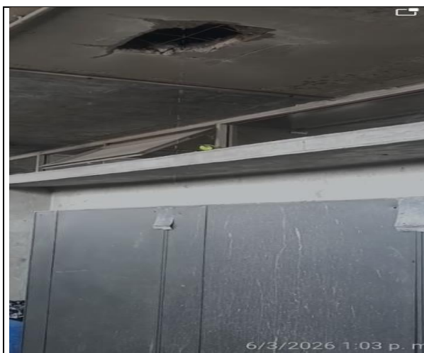
Pasillo frente a salones 210 al 218. Se realiza demolición de torta inferior en concreto en placa aligerada para detección de
