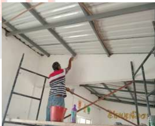
Suministro e instalación de cerchas metálicas
