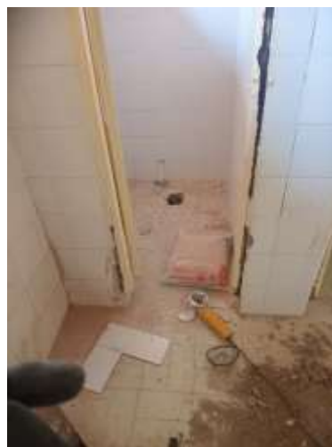
Desmonte de sanitario existente – Cambio de punto sanitario de 4" gress por punto sanitario en 4" en PVC
