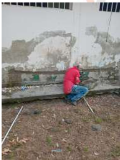
Regata para conexión hidráulica para lavamanos
