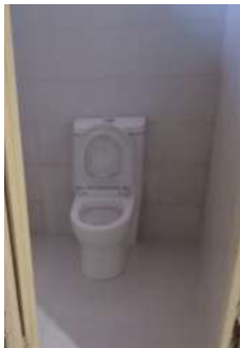
Suministro e instalación de sanitario línea infantil
