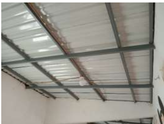
Reinstalación de tubería eléctrica existente e instalacion de bombillas
