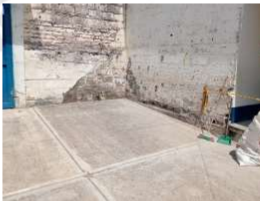
Aseo de las zonas intervenidas
