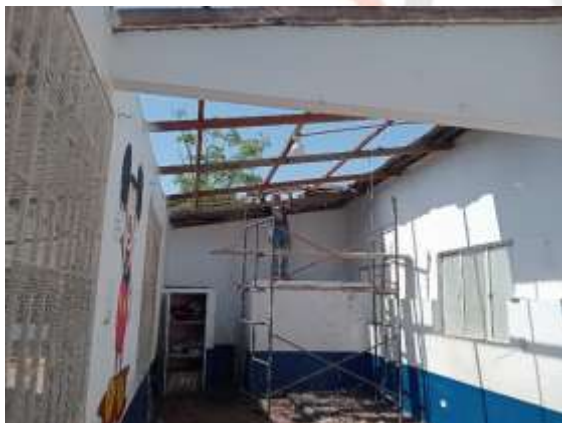
Desmonte de cerchas de madera
