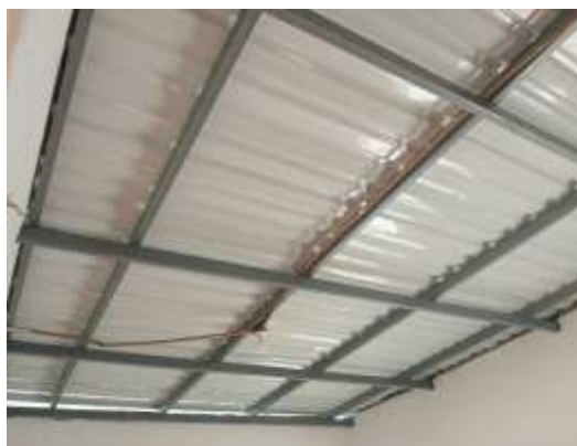
Reinstalación de tubería eléctrica existente e instalacion de bombillas
