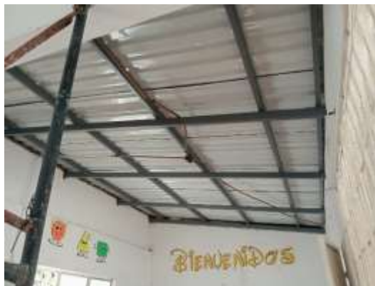
Suministro e instalación de cerchas metálicas
