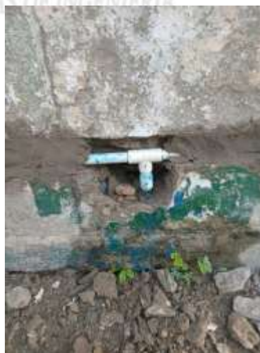
Conexión puntos hidráulicos
