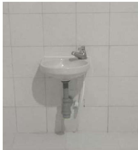
Suministro e instalacion de lavamanos linea infantil
