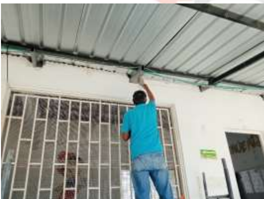
Resane de zonas fachada externa de salon
