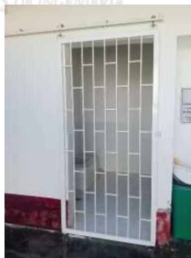
Instalación de reja pintada, nivelada y organizado el sistema corredizo
