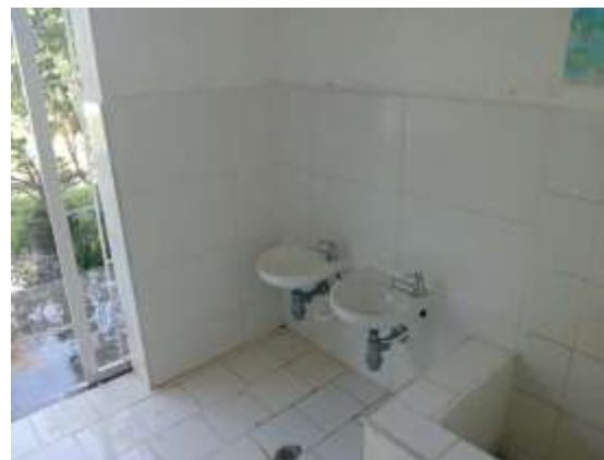
Suministro e instalacion de cerámica sobre muros
