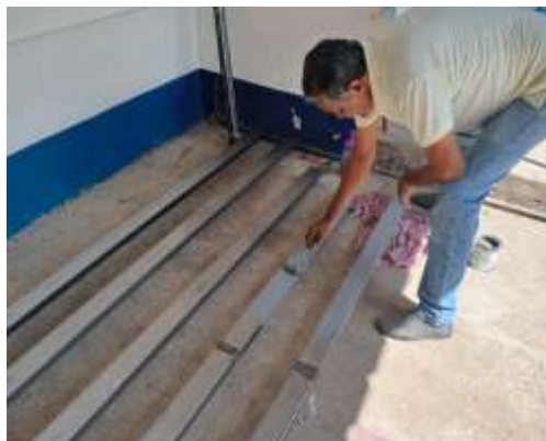
Preparación y pintura de cerchas metálicas
