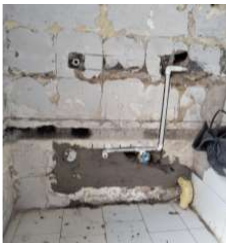
Suministro e instalacion de puntos sanitarios 2" y puntos hidráulicos para conexión de lavamanos
