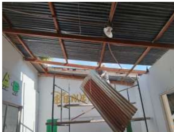
Desmonte de cubierta
