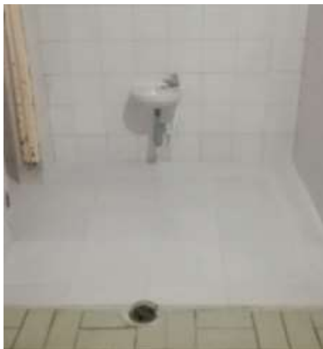
Suministro e instalacion de cerámica de piso área circulación frente a lavamanos
