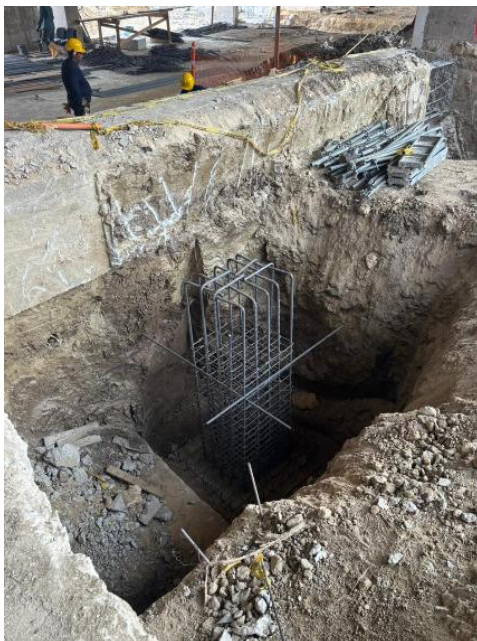
Figura 3. Armado de acero para cimientos de museo del Junior
