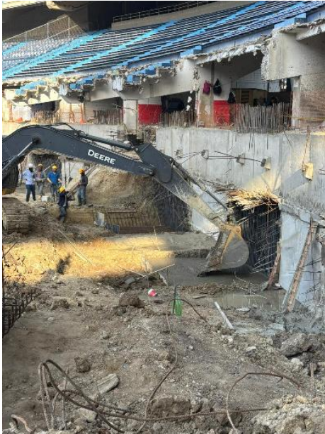
Figura 8. Fundida de zarpa de muro pantalla
