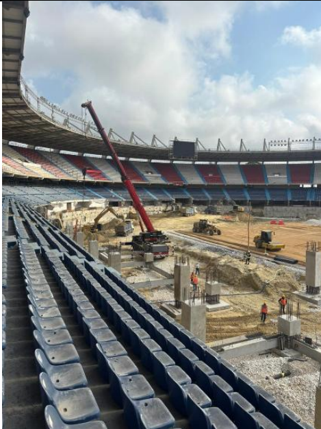
Figura 1. Izaje de elementos prefabricados en zona occidental
