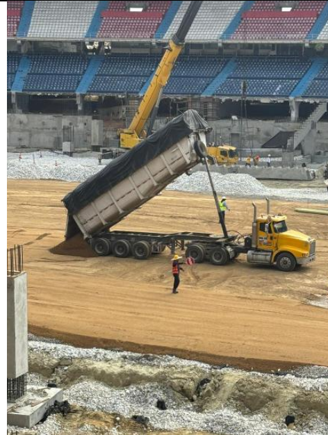
Figura 2. Extendida de subbase para estructura de drenaje de cancha
