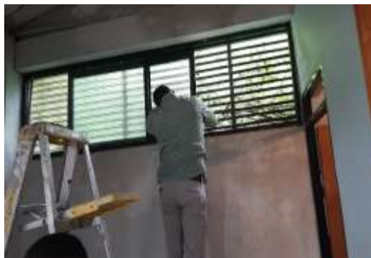
Suministro e instalacion de vidrios
