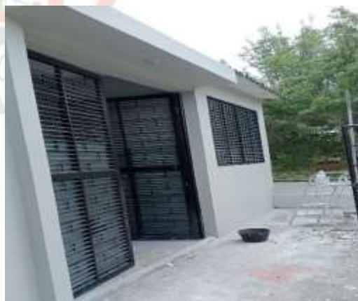
Resane de muros y placa
