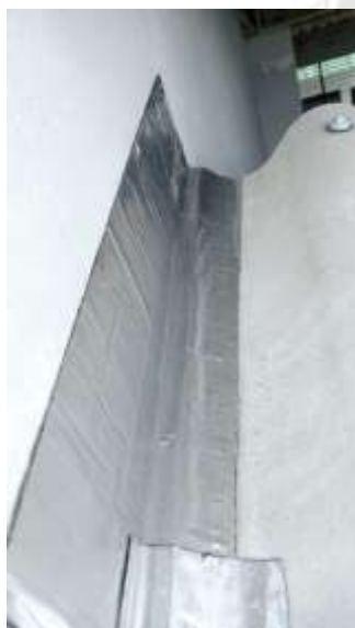
Instalacion de cinta asfáltica sobre costados de cubierta - almacén
