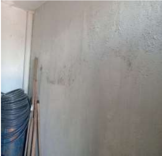
Estado inicial muros – internos
