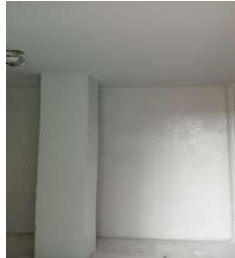
Aplicación de estuco sobre resanes y pintura de muros
