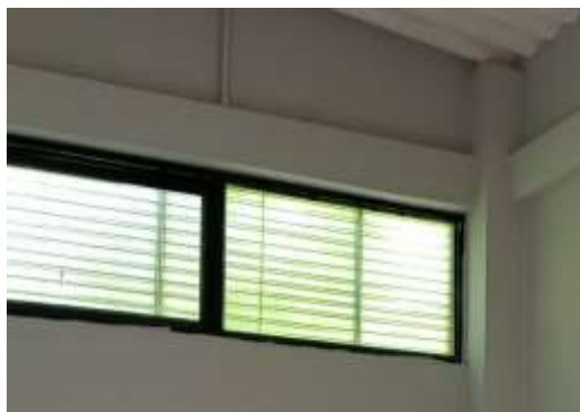
Suministro e instalacion de vidrios
