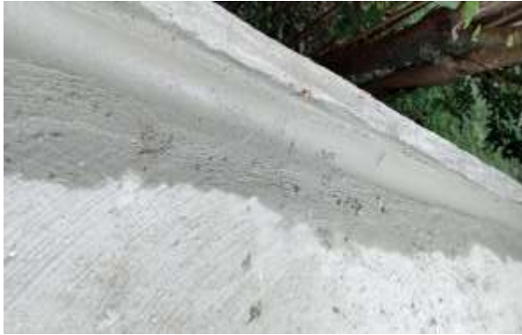
Construcción de media caña sobre borde de placa interior perimetral
