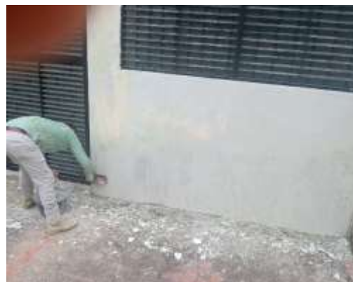
Resane de muros y placa
