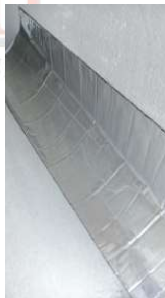
Instalacion de cinta asfáltica sobre costados de cubierta costados área circulación
