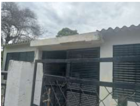
Estado inicial fachada
