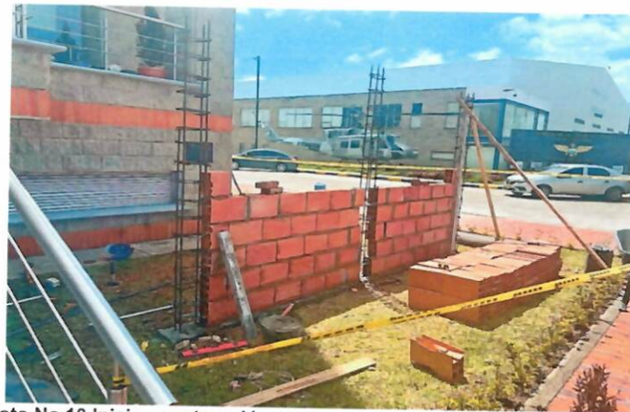
Foto No.10 Inicio construcción muro.
