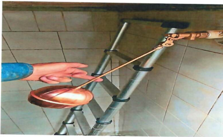
Foto No.2 Suministro e instalación de cheque flotador
