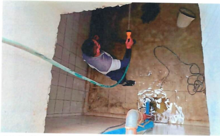
Foto No.1 Lavado de tanque con hipoclorito
