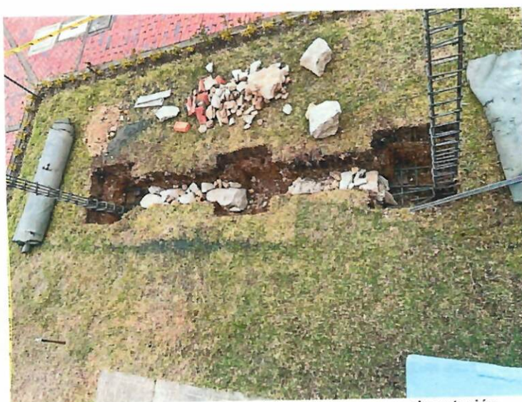
Foto No.8 Excavación y preparación del terreno para cimentación
