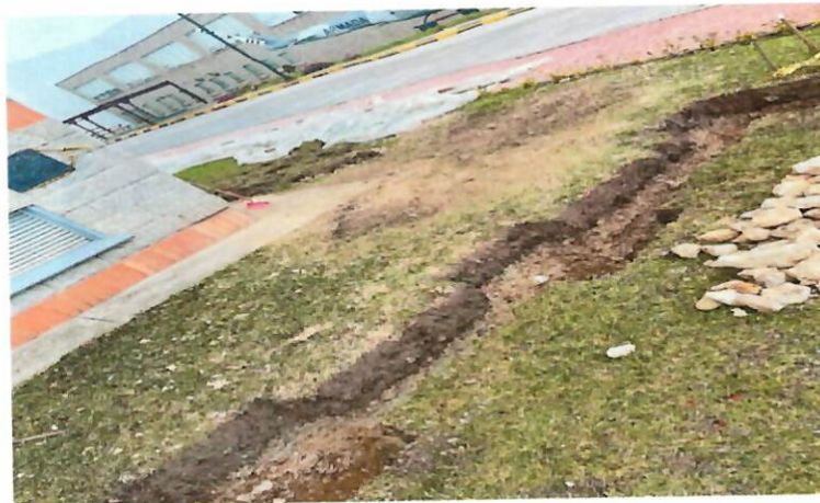
Foto No.4 excavación para muro
