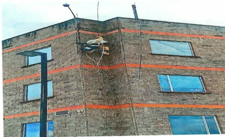
Foto No.3 Lavado de fachada en bloque abusardado
