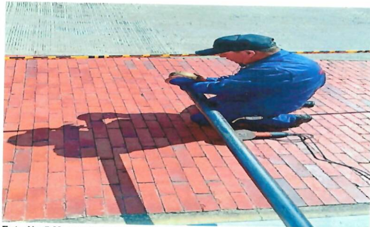
Foto No.5 Mantenimiento de mástiles e instalación de pomos en bronce
