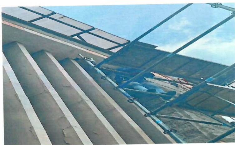
Foto No.7 Instalación de cielo raso en superboard
