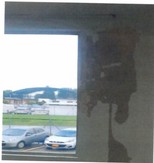
Imagen 6. Resane e instalación de estuco en oficina del 3er piso
