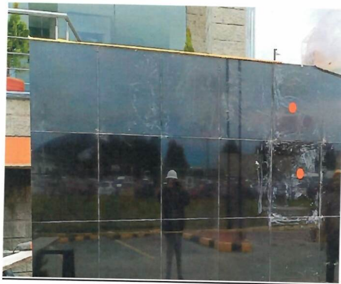
Imagen 5. Instalación de enchape en el muro
