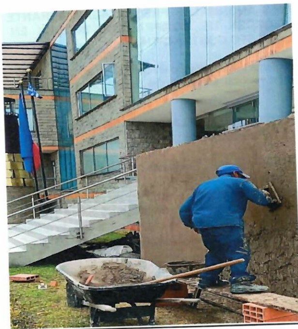
Imagen 1. Pañete del muro de ingreso
