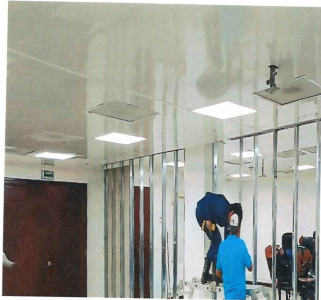
Imagen 7. Instalación de estructura para muro en drywall
