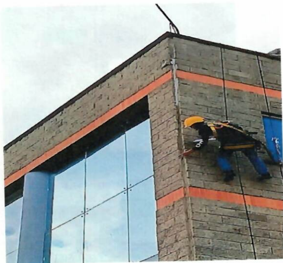
Imagen 9. Impermeabilización exterior de oficina del 3er piso
