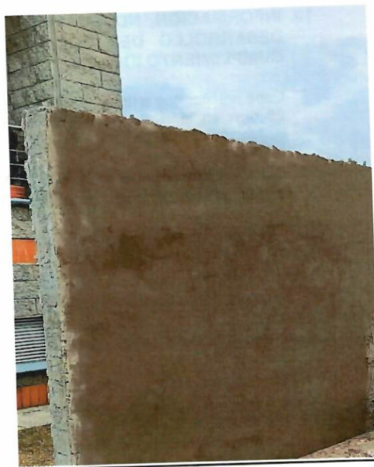
Imagen 2. Aplicación de pañete muro
