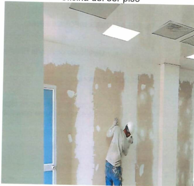
Imagen 8. Aplicación de pañete del muro en drywall
