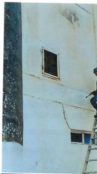
Imagen 4. Inicio de trabajos de escarificación en la Regional de Inteligencia del Caribe
