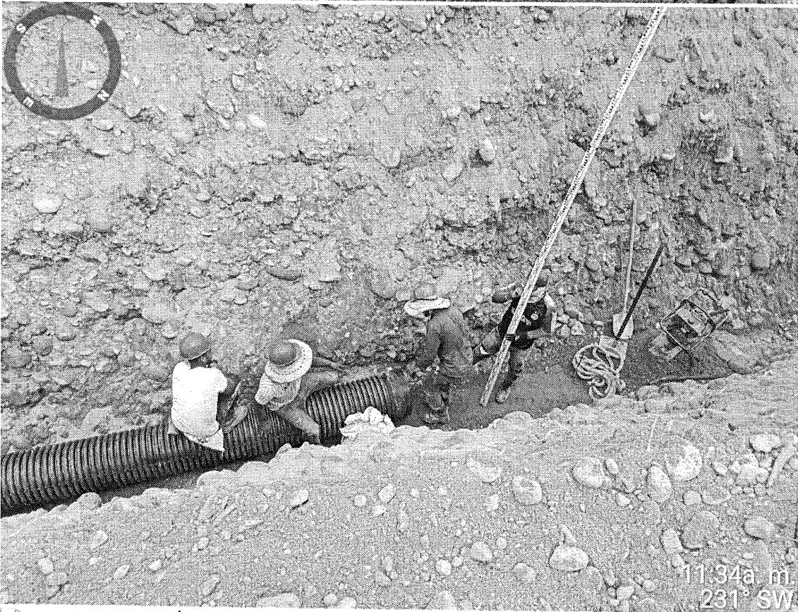
FASE 2 EJECUCIÓN FOTO 4.jpg
