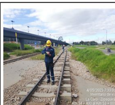
PK34+400 AL PK53+000 APOYO INVENTARIO DE VIA
