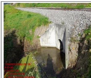
PK 92+380 LIMPIEZA DE ALCANTARILLA
