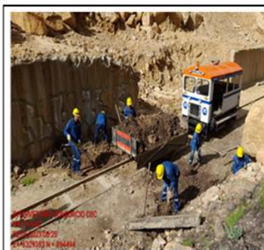
PK77+090 REMOCION DERRUMBE
