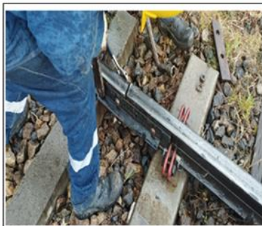
PK13+260 CAMBIO/INSTALACION DE ECLISAS Y PERNOS
