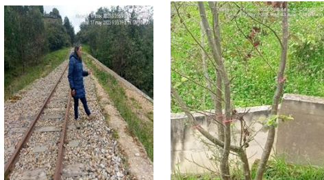
Foto 1. Identificación en sitio Boyacá PK 127+00 como punto crítico a ejecutar y su correspondiente impacto ambiental a considerar – manejo de flora
