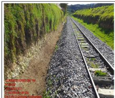
PK 92+630 LIMPIEZA DE CUNETA
