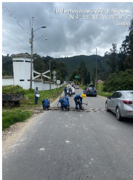
Foto 7. fotografía izquierda Limpieza de cunetas en tierra. Derecha limpieza paso nivel Hato Grande (Sopó PK 41+740, tramo La Caro - villa pinzón).
