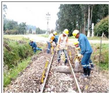
PK 44+800 NIVELACION Y ALINEACION
