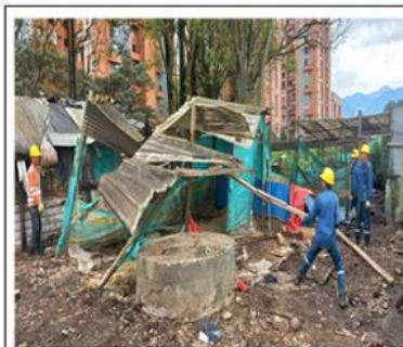
DESMANTELAMIENTO DE VIVIENDAS INVACION KM5
