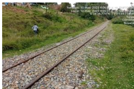
Foto 5. Alcantarilla Identificada en sitio Pk 188+400 Boyacá para ejecución de obra
