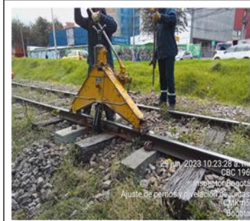
PK 16-450 MANTENIMIENTO JUNTAS
