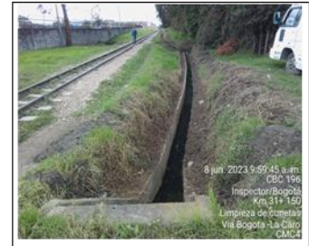
PK 31-150 LIMPIEZA DE CUNETAS
