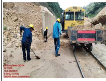
PK 77-070 REMOCION DE DERRUMBE
