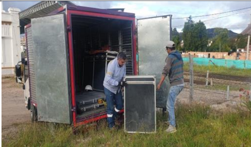
Seguimiento a la Instalación de equipos para monitoreos ambientales en campo en Estación Tunja en fecha 9 de junio
