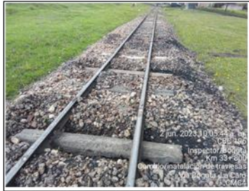
PK 33-800 CAMBIO TRAVESAS DE MADERA
