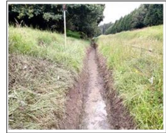
PK PK 44-750 LIMPIEZA DE CUNETAS
