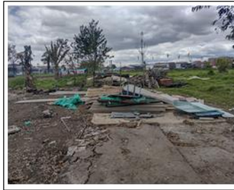
Km 5 DEMOLICION INVASIONES TRIANGULO DE INVERSION
