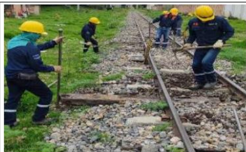
PK 185+170 ALINEACION NIVELACION DE VIA
