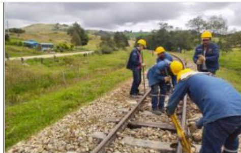
PK 209+440 DESMONTE Y ARME DE VIA EXISTENTE
