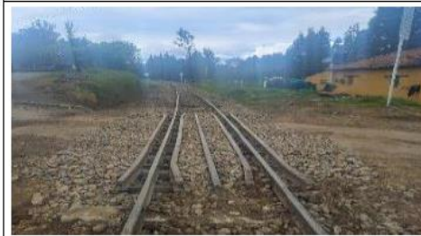
PK 209+440 DESMONTE Y ARME DE VIA EXISTENTE
