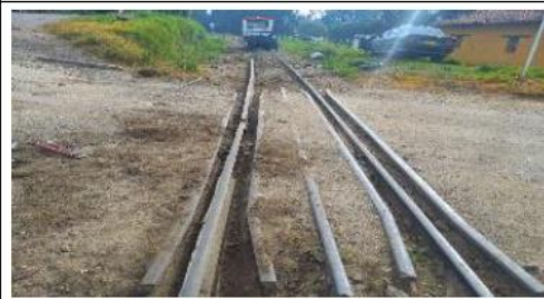
PK 209+440 DESMONTE Y ARME DE VIA EXISTENTE
