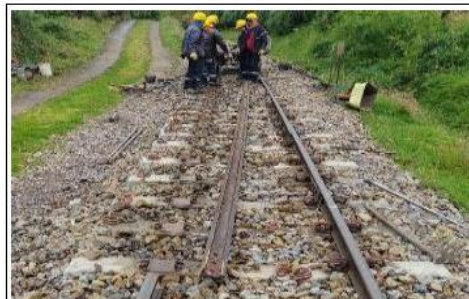
PK165+930 CAMBIO DE RIEL
