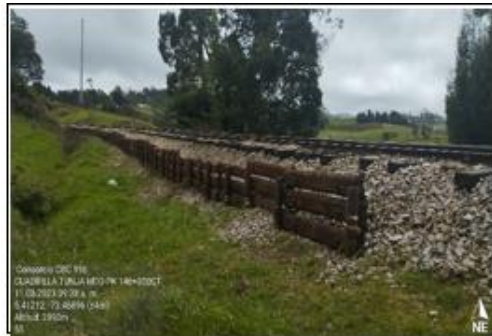
PK 146+650 CONSTRUCCION PANTALLA GUARDA BALASTO
