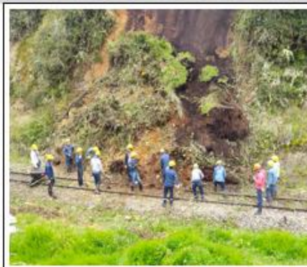
PK 131+520 REMOCION DERRUMBE
