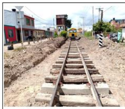
PK 52+555 DESCARPE DE VIA
