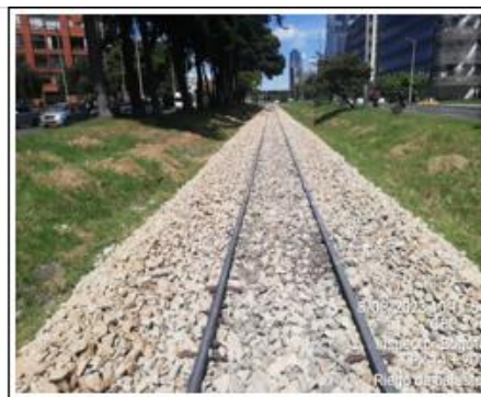
PK 14+200 RIEGO DE BALASTO LATERAL
