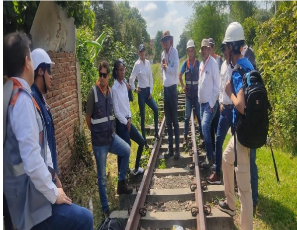
Foto No.7 Revisión de puentes con el especialista estructural del contratista
