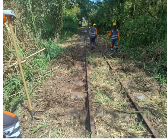
Tramo Palmira – Buga con cuadrilla de mantenimiento haciendo limpieza.
