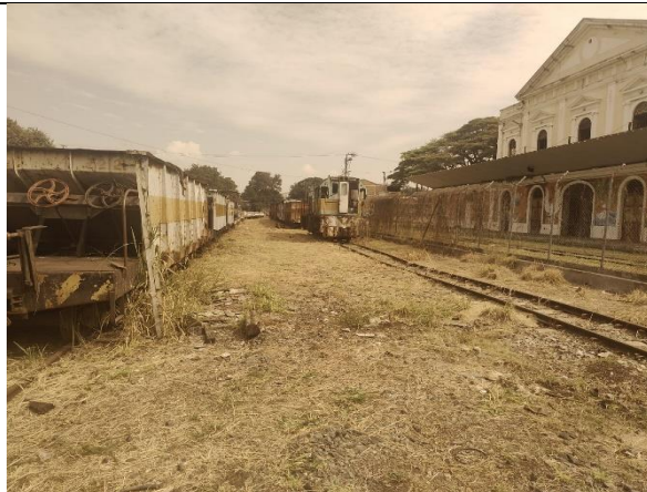
Estación de Palmira donde se evidencia el efecto del químico
