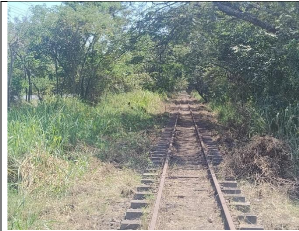
Tramo Prioritario en proceso de limpieza y ampliación de ancho
