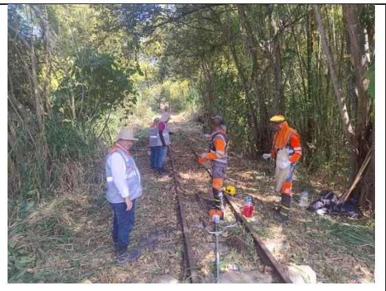
Cuadrilla de mantenimiento haciendo labores de limpieza en la vía férrea
