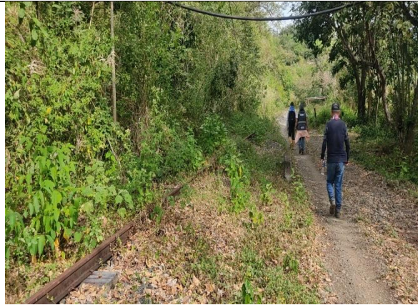
Tramo del sector Buenaventura -Cisneros sin rocería
