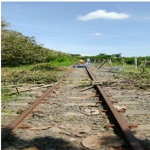
Foto No.5 Recorrido de verificación ambiental en el PK234+100 Buga
