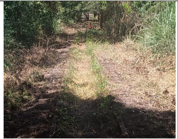
Tramo prioritario antes de la limpieza y el deshierbe manual
