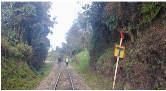
Foto 10 Descripción: Señal de 300 metros antes de la obra PK 132+299
