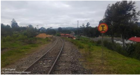
Foto 9 Descripción: Señal de 300 metros antes de la obra PK 205+610
