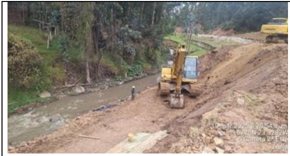
Foto 3 Descripción: Seguimiento a obra PK 188+650
