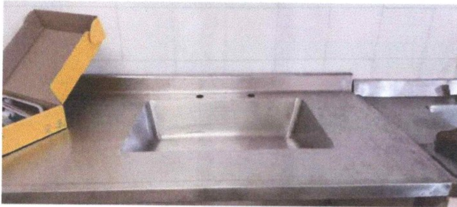
instalación de llave doble para lavaplatos
