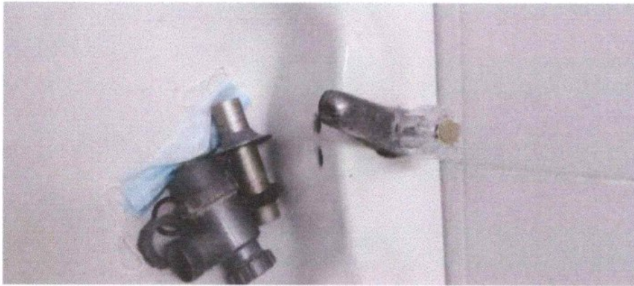
instalación de llave para lavamanos
