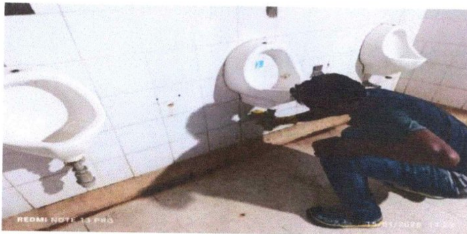
destaponamiento de sifón tapado
