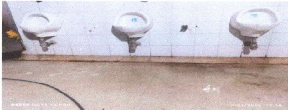
instalación de lleves para orinal
