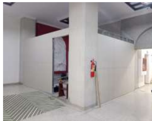
Imagen No.1: cerramiento provisional
