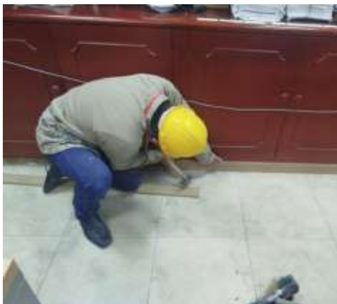
Imagen No.8: instalación de guarda escobas SPC
