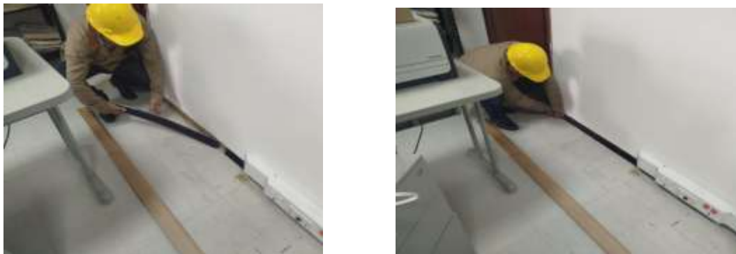
Imagen No.2: demolición de guarda escobas
