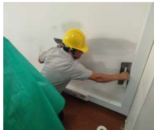
Imagen No.7: resane de juntas e imperfecciones
