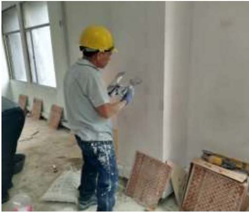
Imagen No.7: resane de juntas e imperfecciones
