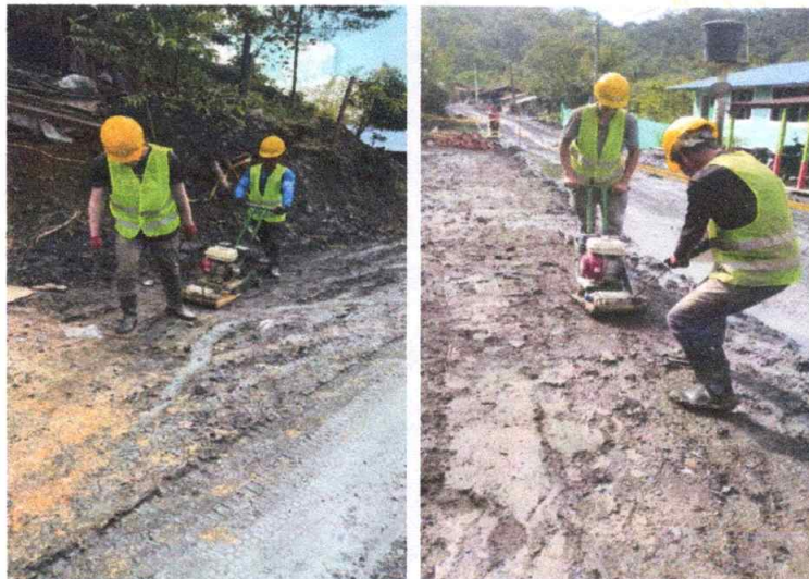
Foto 4. Compactación del material con plancha vibradora.
