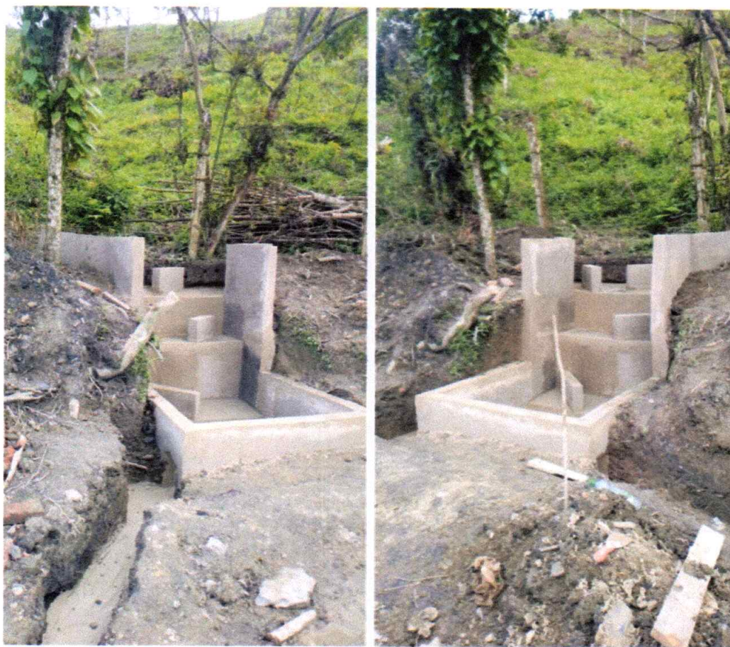
Foto 19. Placa maciza con espesor de 0,10 m, que actua como discipador de energía.
