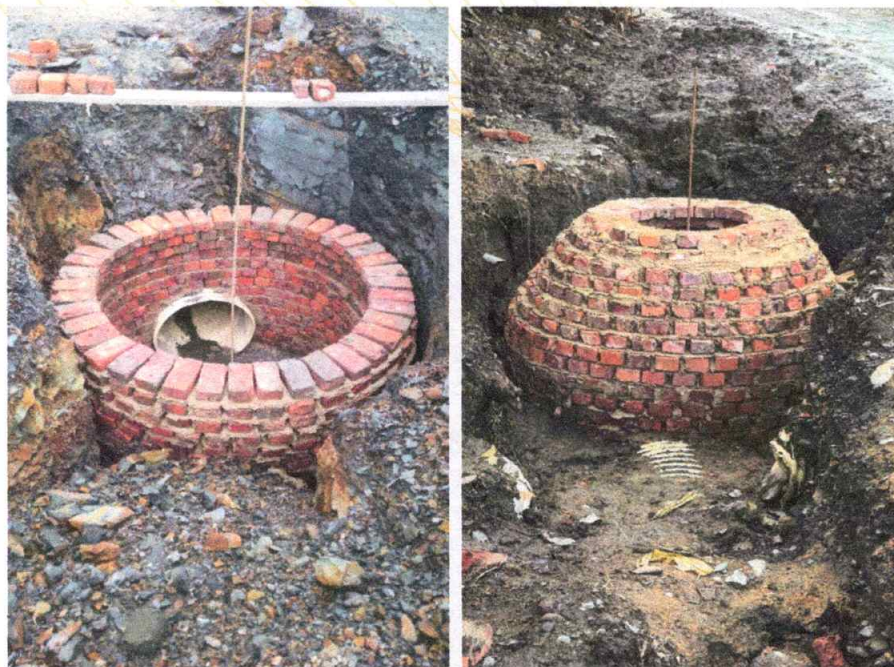
Foto 8. Proceso constructivo pozos de inspección.
