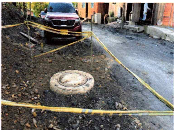
Foto 6. Aro y tapas para los pozos de inspección – recepción de aguas lluvias de los sumideros laterales.
