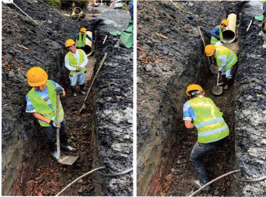
Foto 2. Excavación para instalación de tubería.
