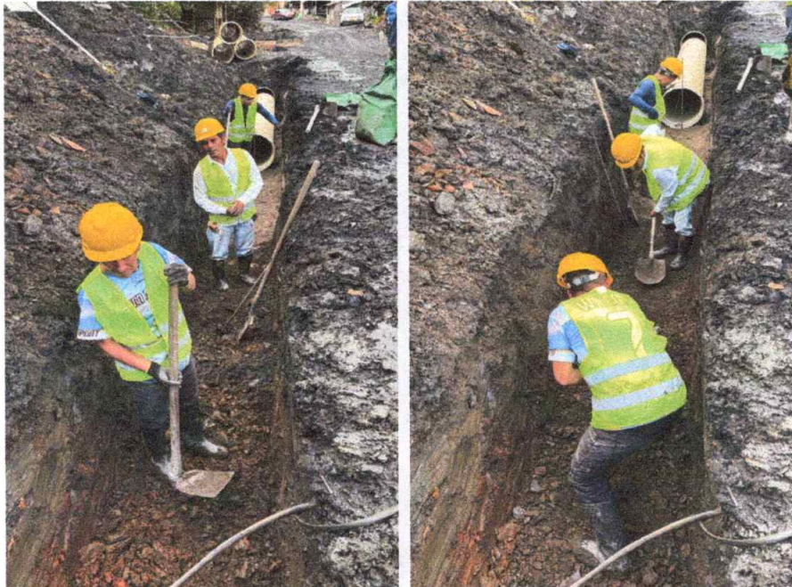
Foto 2. Excavación para instalación de tubería.
