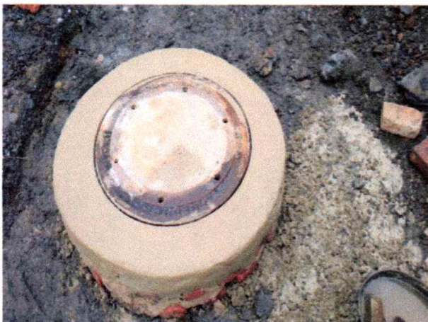
Foto 6. Aro y tapas para los pozos de inspección – recepción de aguas lluvias de los sumideros laterales.
