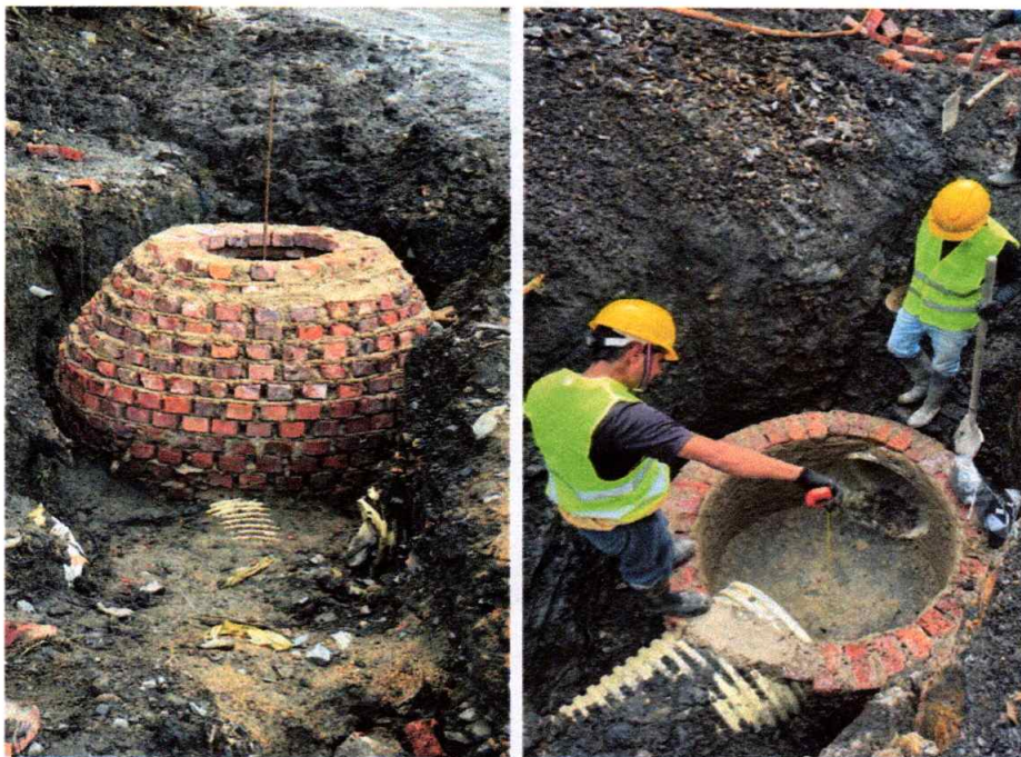
Foto 3. Excavación para pozos de inspección.
