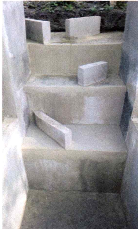
Foto 17. Caja de inspección, que facilitará el acceso y mantenimiento al sistema de alcantarillado.
