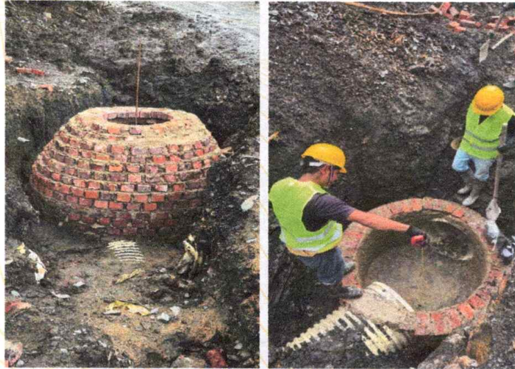
Foto 3. Excavación para pozos de inspección.
