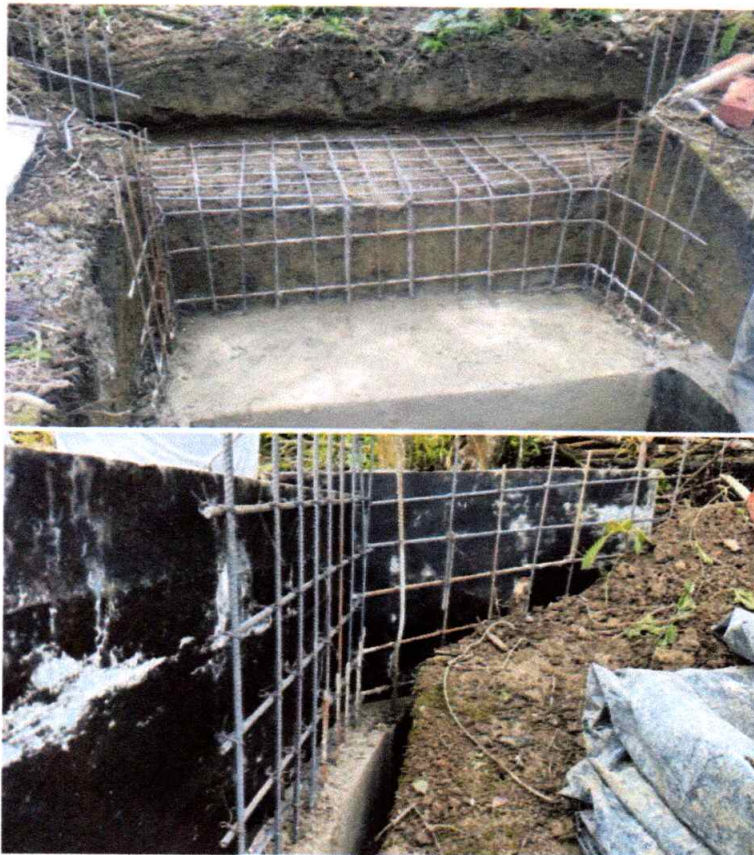
Foto 20. Figurado de acero para placas.
