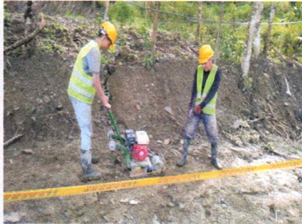
Foto 5. Superficie compactada y en funcionamiento para paso vehicular.
