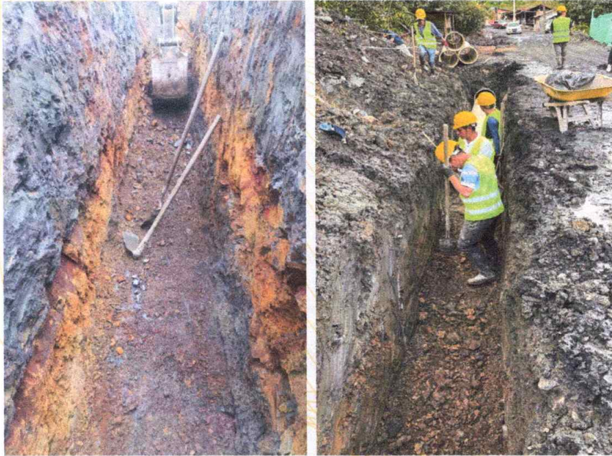
Foto 1. Excavación para instalación de tubería.
