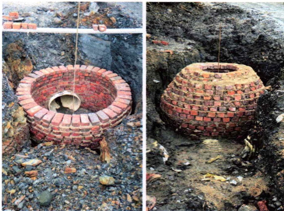
Foto 8. Proceso constructivo pozos de inspección.
