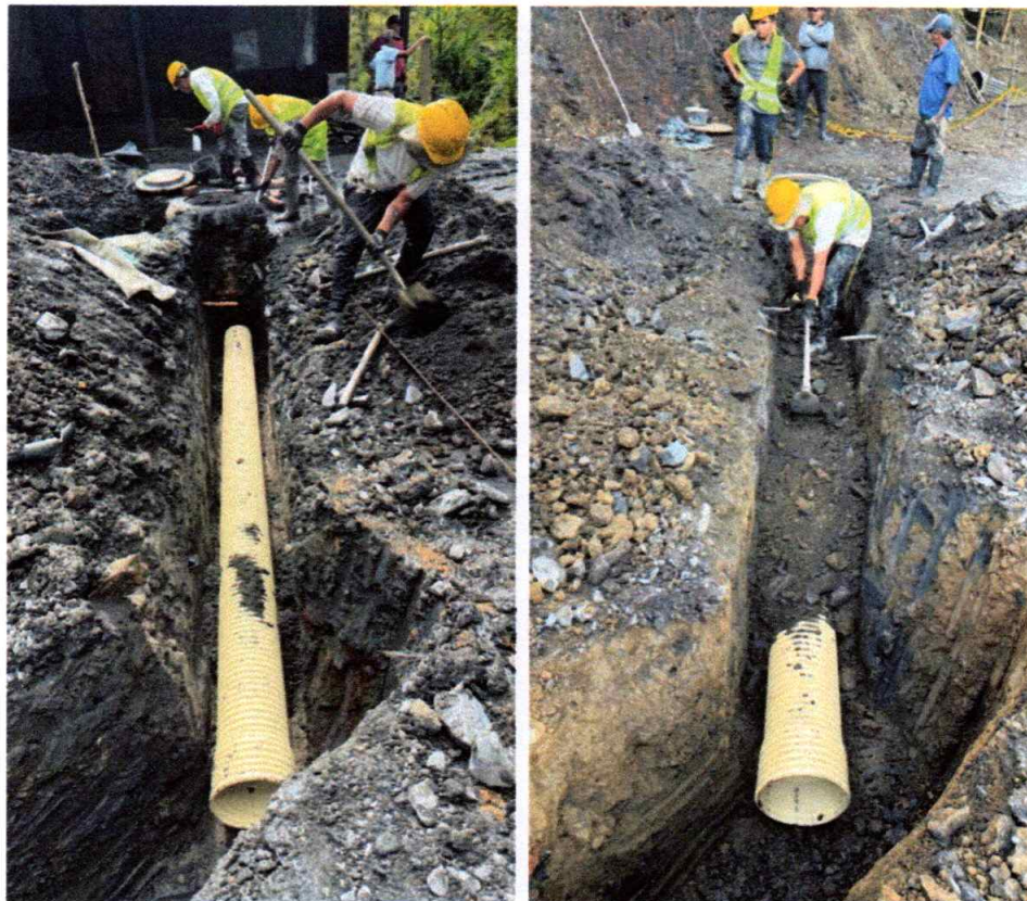
Foto 10. Tubería para alcantarillado D=12" de la red principal.
