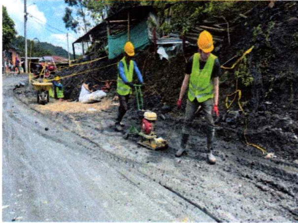
Foto 5. Superficie compactada y en funcionamiento para paso vehicular.
