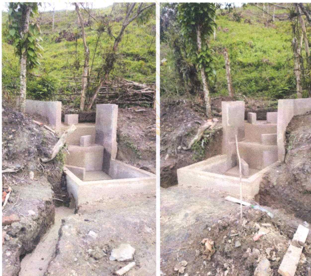
Foto 19. Placa maciza con espesor de 0,10 m, que actúa como dissipador de energía.
