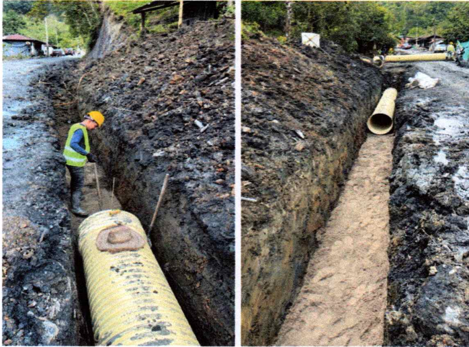
Foto 13. Encamado construido em arena de río, listo para instalación de la tubería.
