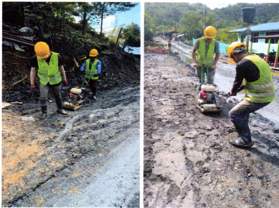
Foto 4. Compactación del material con plancha vibradora.
