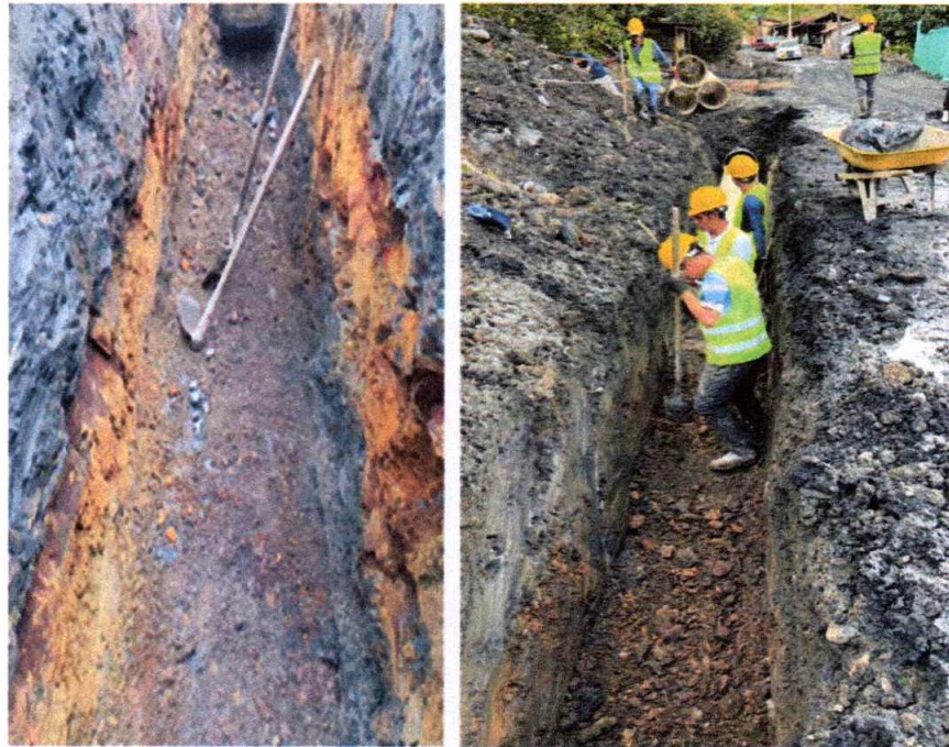
Foto 1. Excavación para instalación de tubería.
