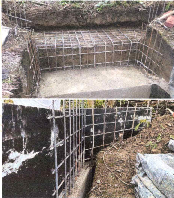
Foto 20. Figurado de acero para placas.
