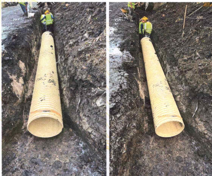
Foto 12. Tubería para alcantarillado tipo TDP D=24", que permitirá recibir y entregar aguas lluvias.
