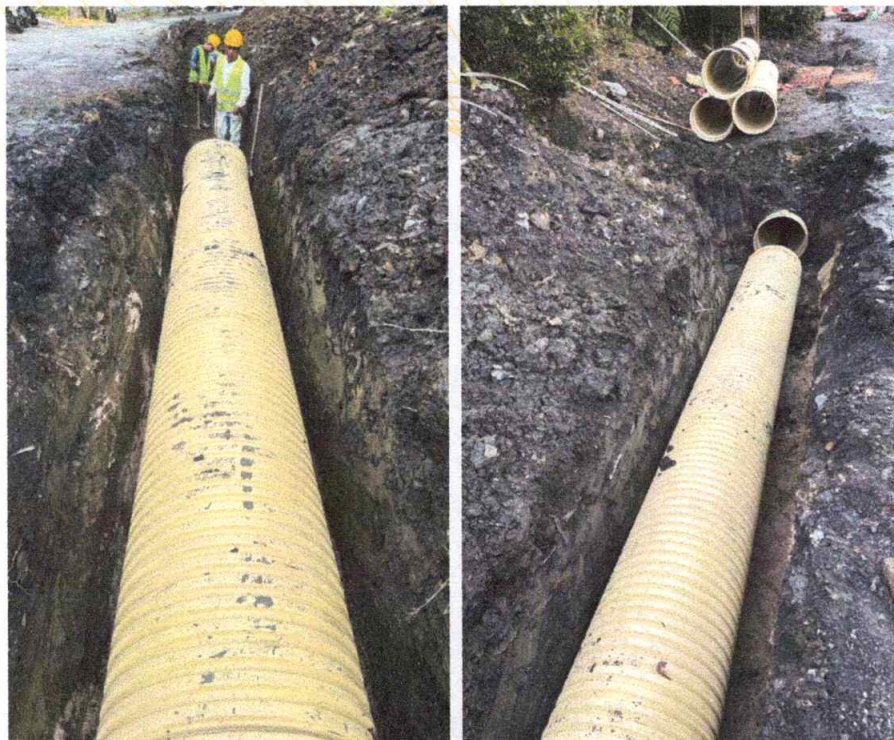
Foto 11. Tubería para alcantarillado tipo TDP D=24" de la red principal.
