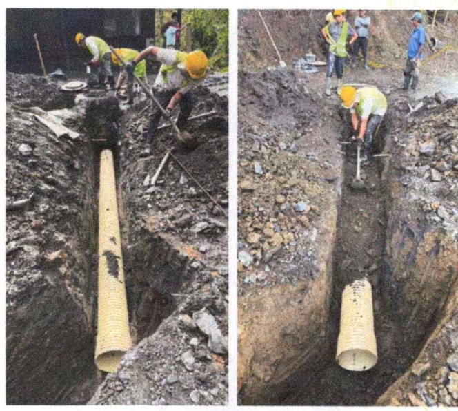
Foto 10. Tubería para alcantarillado D=12" de la red principal.
