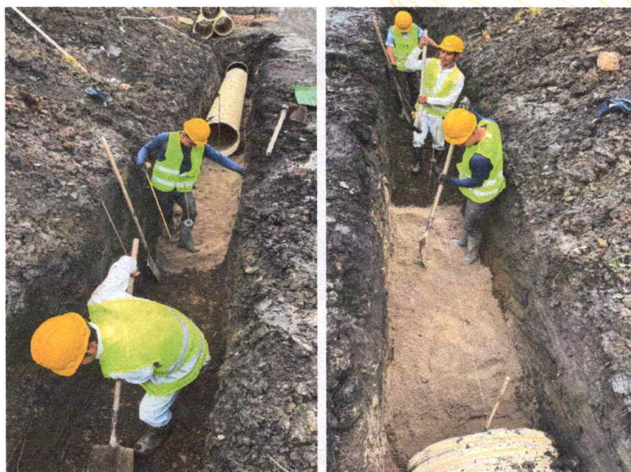
Foto 14. Tubo para alcantarillado instalado sobre encamado en arena de río.
