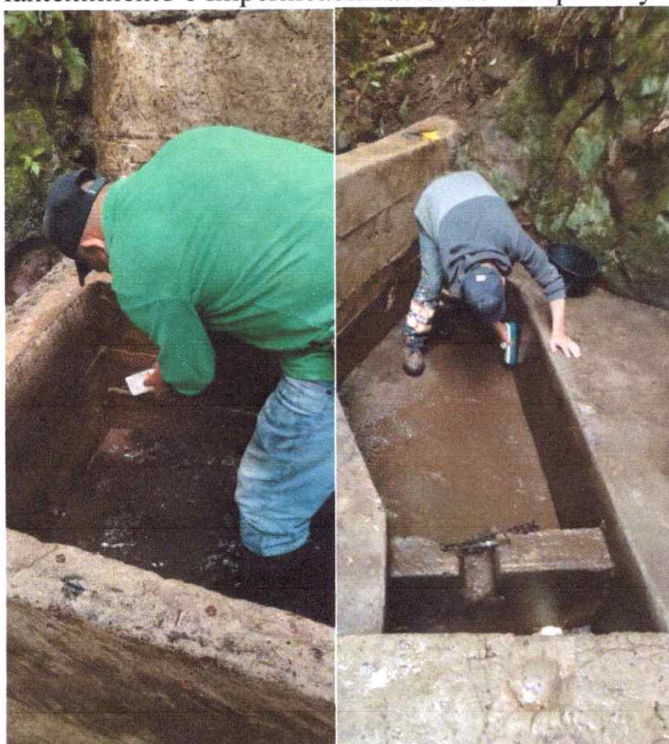
Limpieza, Mantenimiento e Impermeabilización de Tanquillas y Desarenador.
