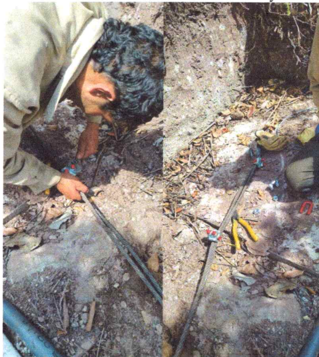
Instalación de Estructura Cable-Guaya
