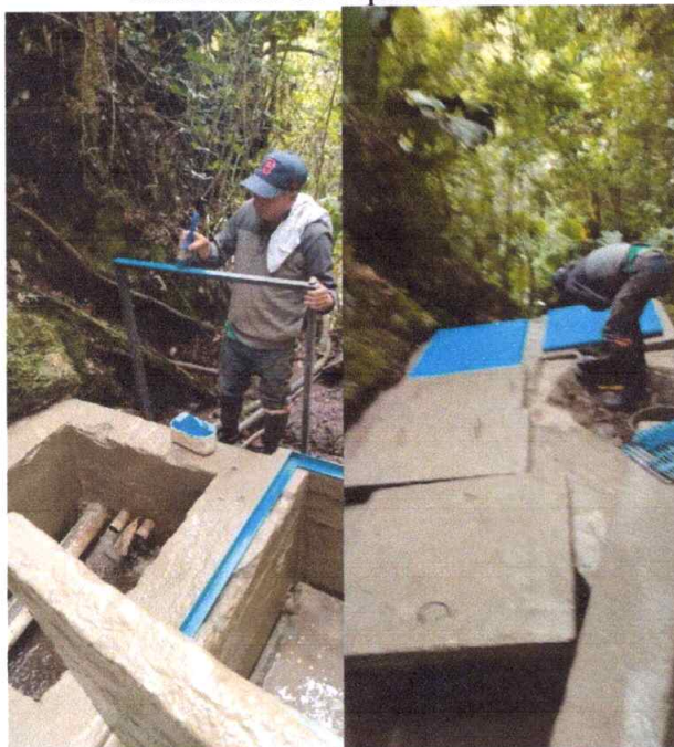
Instalación de Tapas Metálicas
