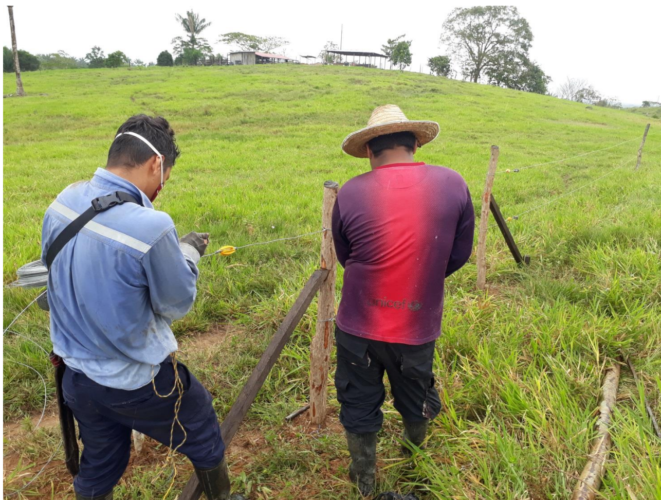
Construcción de cerca perimetral
