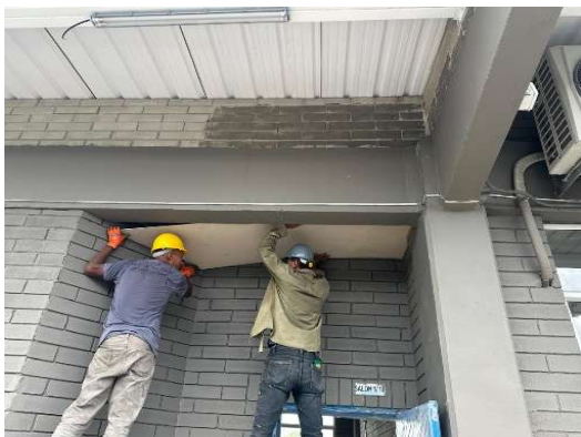
Imagen 14 Instalación de cielo raso
