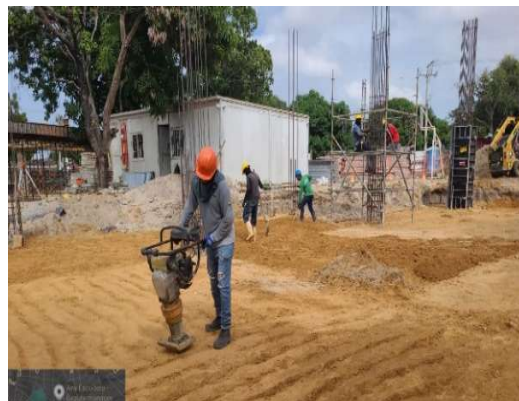
Imagen 123 Relleno en material
