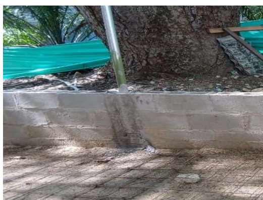
Imagen 27 Columneta de cerramiento
