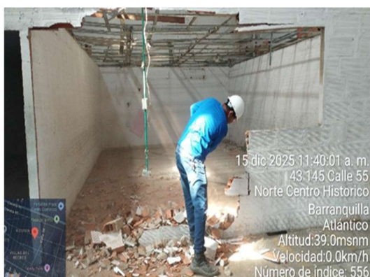
Imagen 142 Demolición de muro
