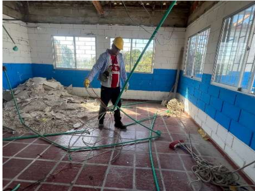
Imagen 78 Desmonte y retiro de puntos eléctricos
