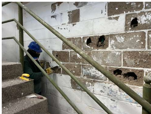
Imagen 67 Escarificación de muro
