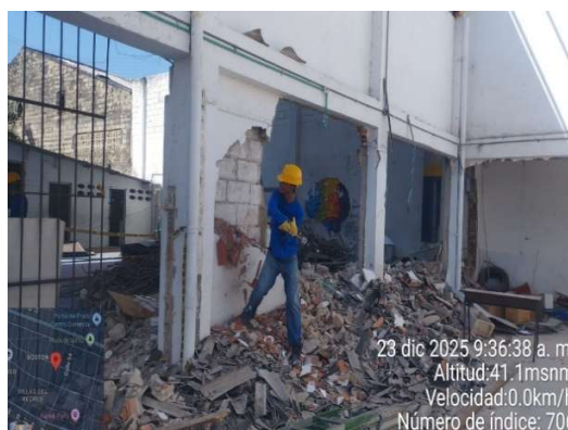
Imagen 143 Demolición de muros
