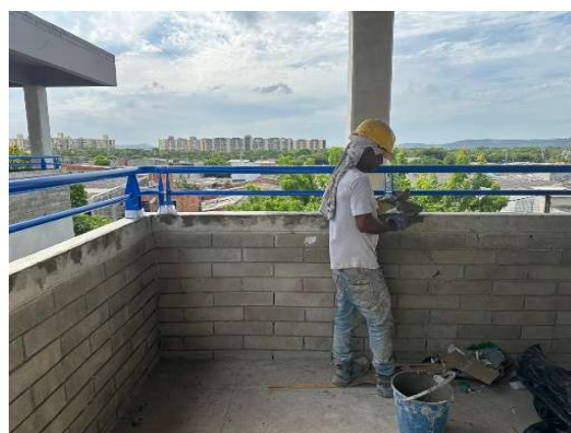
Imagen 11 Pañete lineal sobre muro
