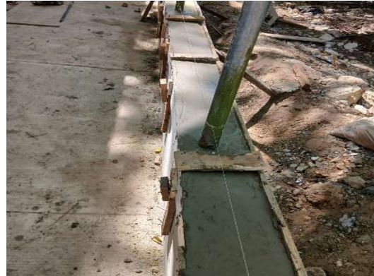
Imagen 29 Alfajía de cerramiento
