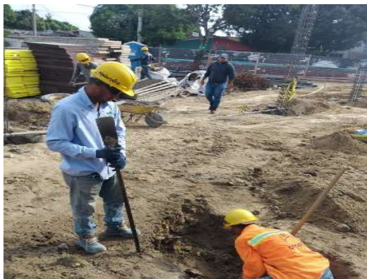
Imagen 122 Excavación a mano
