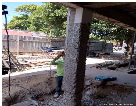
Imagen 42 Escarificación de columnas
