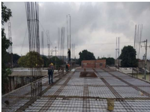
Imagen 128 Instalación de losa
