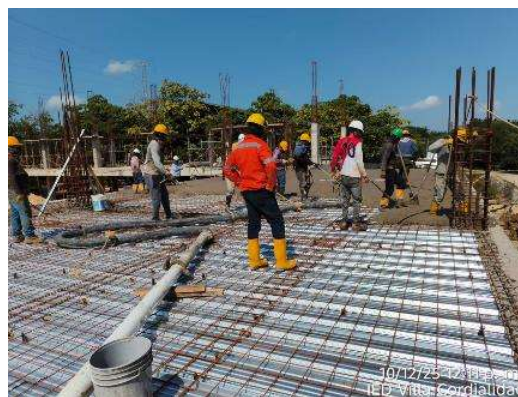
Imagen 109 Instalación de losa en steeldeck
