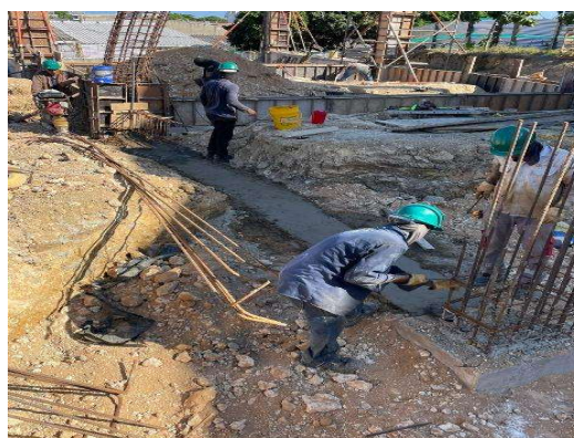
Imagen 115 Solado en concreto
