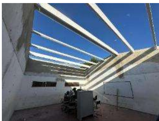
Imagen 91 Montaje de estructura metálica
