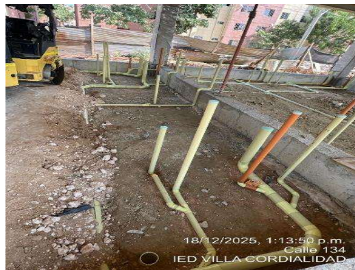
Imagen 107 Instalación de tubería sanitaria de 2"
