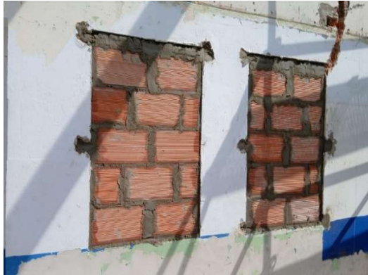
Imagen 28 Levante de muro
