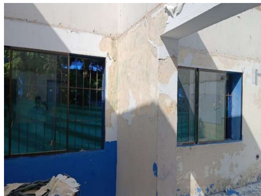
Imagen 35 Escarificación de pintura
