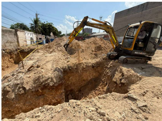
Imagen 132 Excavación a maquina
