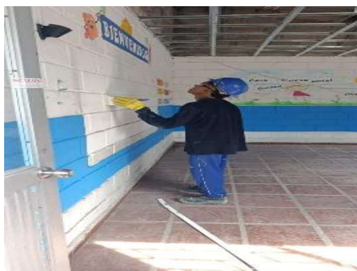
Imagen 69 Aplicación de pintura
