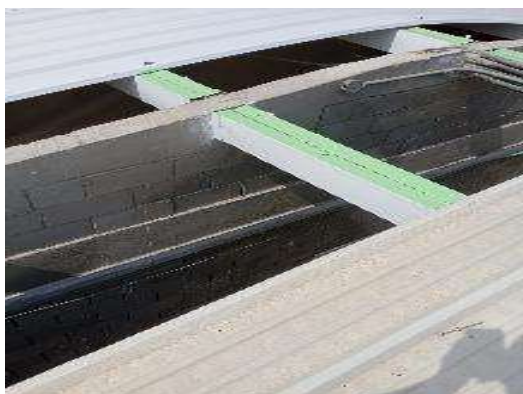
Imagen 62 Mantenimiento de estructura metálica
