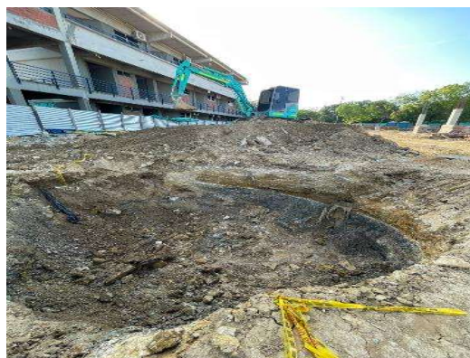
Imagen 113 Excavación a máquina
