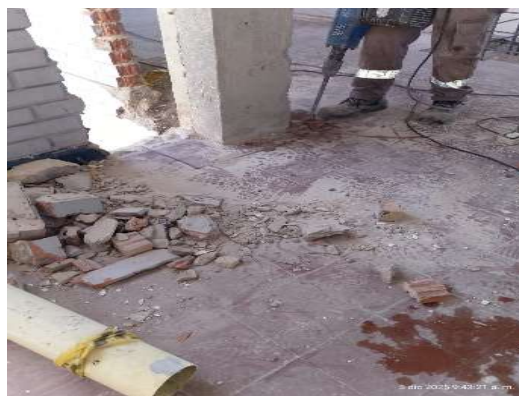
Imagen 47 Demolición de losa
