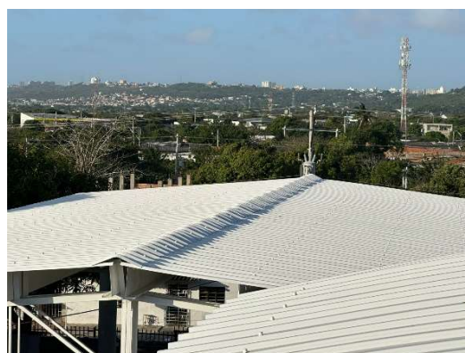
Imagen 65 Instalación de caballete
