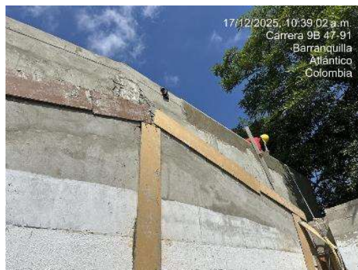
Imagen 83 Fundida de columnetas
