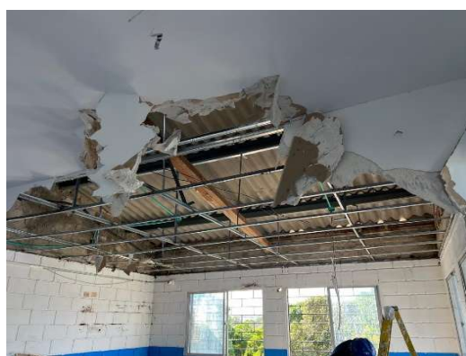
Imagen 71 Desmonte de cielo raso
