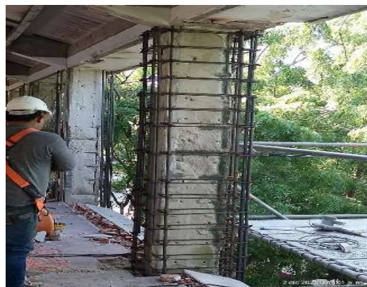
Imagen 43 Acero de refuerzo
