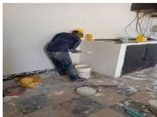
Imagen 33 Aplicación de pintura
