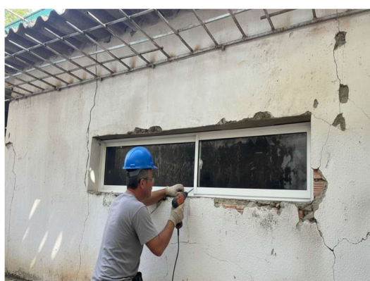
Imagen 76 Instalación de ventana en aluminio
