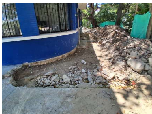
Imagen 36 Demolición de piso
