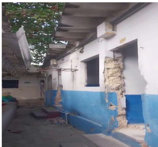
Imagen 98 Desmonte de puertas y ventanas
