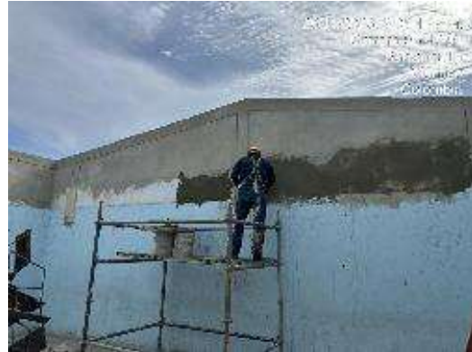
Imagen 93 Pañete sobre muro
