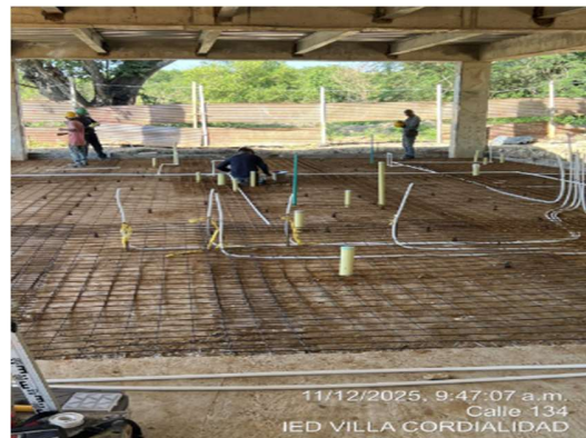
Imagen 105 Instalación de tubería de agua potable
