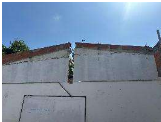
Imagen 87 Corte de muro
