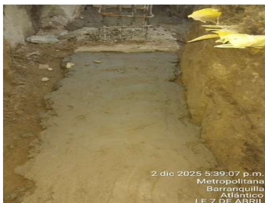
Imagen 124 Solado en concreto
