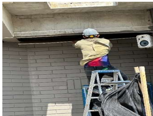
Imagen 15 Desmonte de cielo raso
