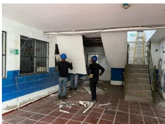
Imagen 70 Instalación de cielo raso
