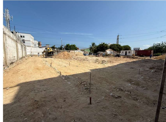
Imagen 137 Trazado de ejes
