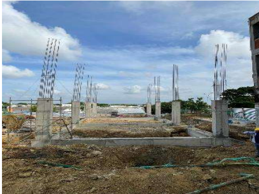
Imagen 118 Fundida de columnas
