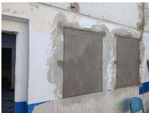
Imagen 30 Pañete sobre muro
