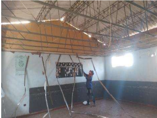
Imagen 92 Desmonte y retiro de puntos eléctricos
