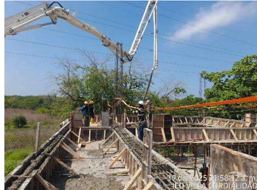
Imagen 101 Viga sobre muro
