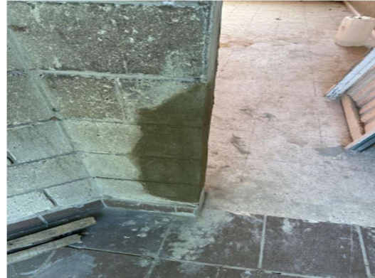
Imagen 55 Pañete sobre muros
