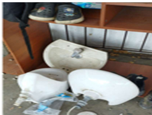
Imagen 141 Desmonte de sanitario
