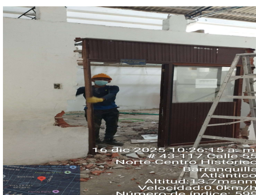
Imagen 145 Desmonte de puerta
