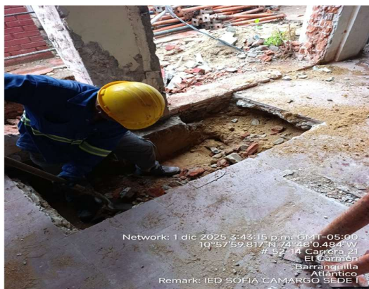
Imagen 40 Excavación a mano
