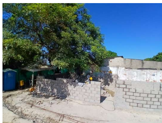
Imagen 25 Levante de muro
