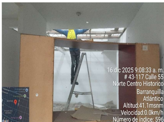
Imagen 140 Desmonte de cielo raso
