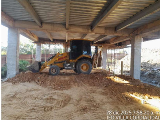
Imagen 100 Relleno en material seleccionado
