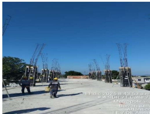
Imagen 129 Concreto en columnas
