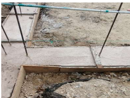
Imagen 24 Levante de bloque con dovelas
