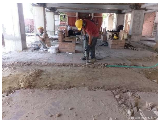
Imagen 49 Demolición de piso
