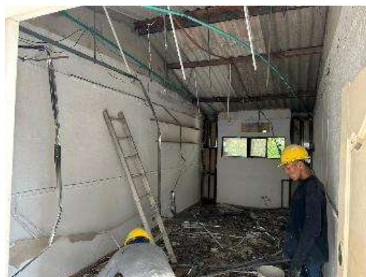
Imagen 89 Desmonte de cielo raso
