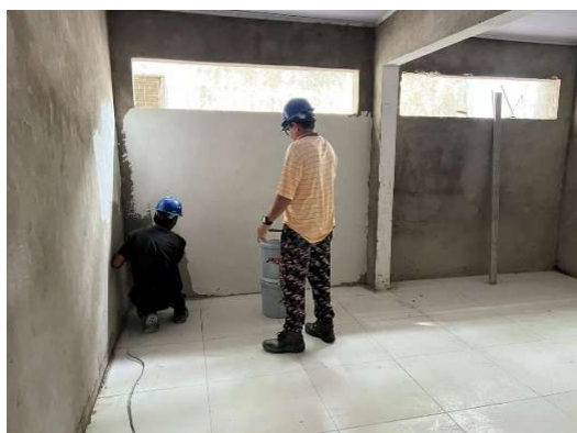
Imagen 68 Aplicación de estuco
