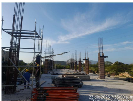
Imagen 110 Fundida de columnas
