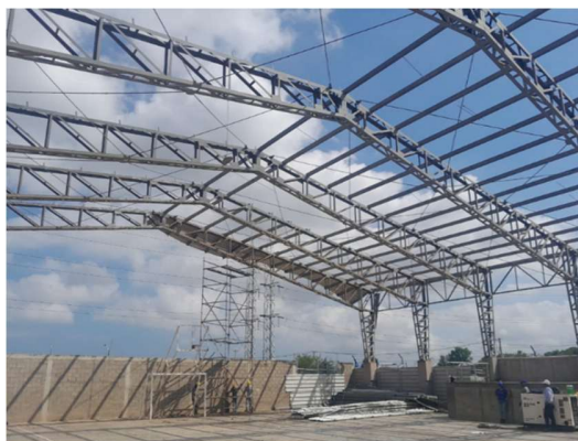
Imagen 96 Desmonte de cubierta
