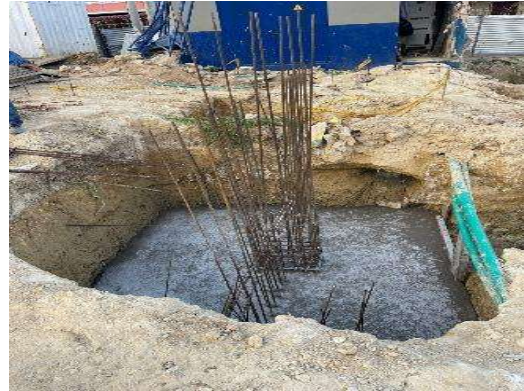
Imagen 119 Fundida de zapata
