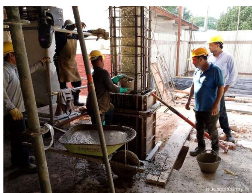
Imagen 51 Concreto para columnas
