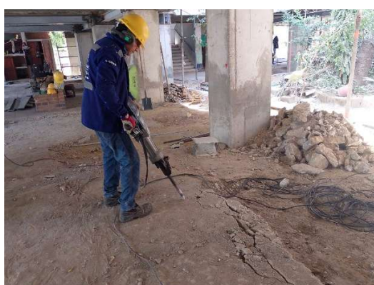
Imagen 50 Demolición de plantilla
