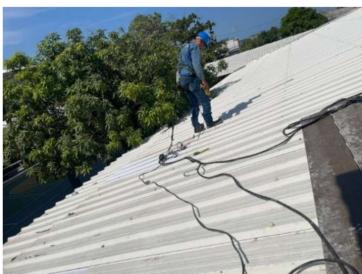
Imagen 18 Instalación de cubierta
