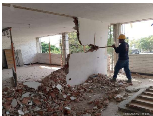
Imagen 48 Demolición de muro
