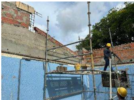
Imagen 86 Demolición de mampostería
