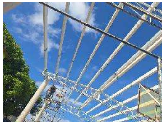
Imagen 61 Montaje de estructura metálica
