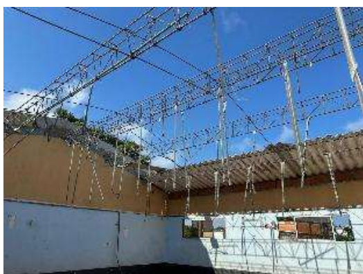
Imagen 90 Desmonte de cubierta
