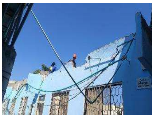
Imagen 85 Demolición de zabaletas
