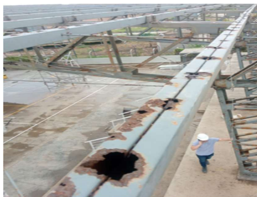
Imagen 97 Desmonte de perfilería metálica
