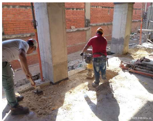
Imagen 41 Relleno de material
