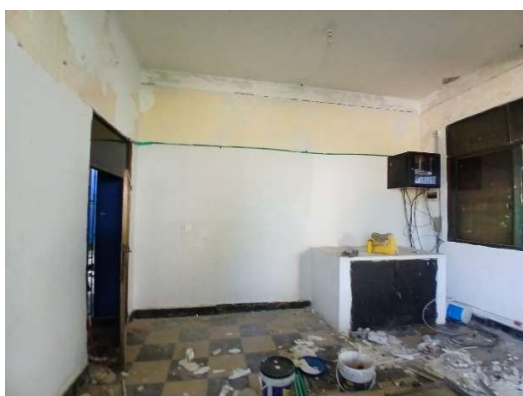
Imagen 32 Aplicación de estuco
