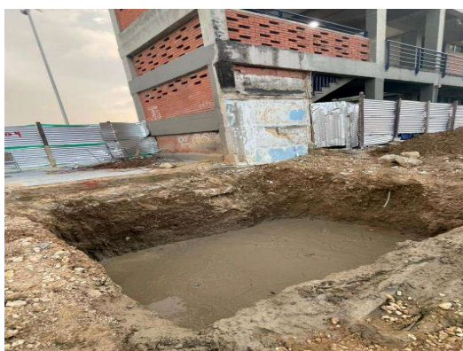
Imagen 116 Fundida de concreto ciclópeo
