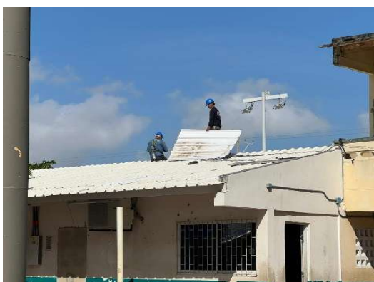
Imagen 16 Desmonte de cubierta
