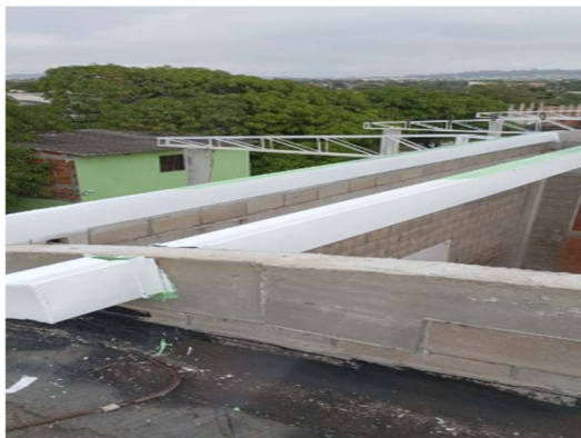
Imagen 60 Desmonte de cubierta
