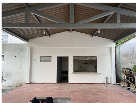
Imagen 74 Mantenimiento de estructura metálica
