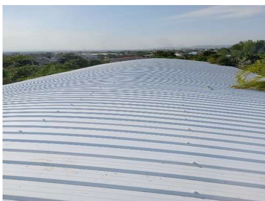
Imagen 64 Instalación de cubierta
