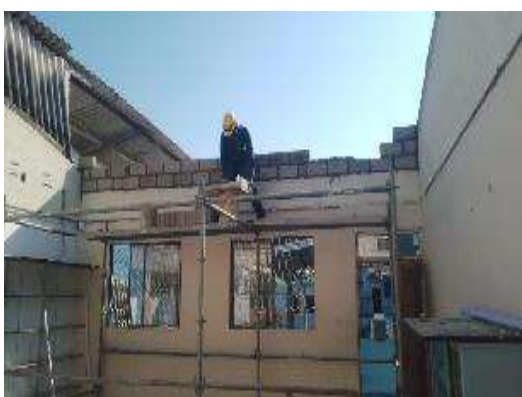
Imagen 84 Levante de mampostería
