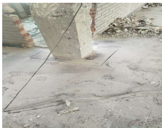
Imagen 45 Corte de losa
