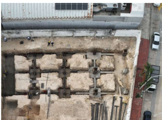
Imagen 134 Viga de cimiento
