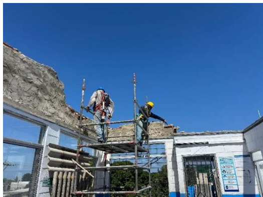
Imagen 66 Demolición de zabaletas
