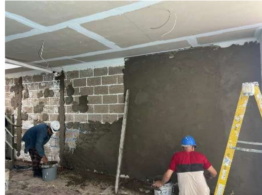
Imagen 79 Pañete de muro
