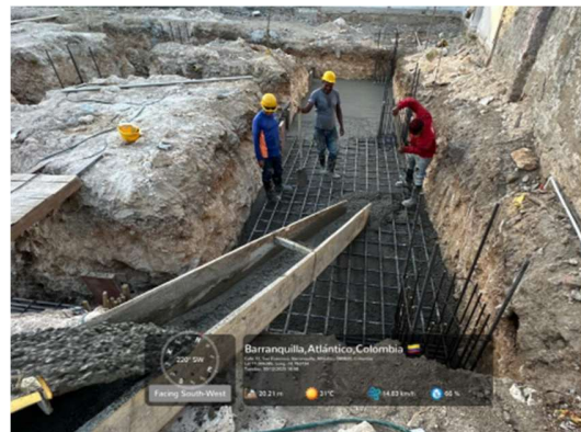
Imagen 139 Zapata en concreto
