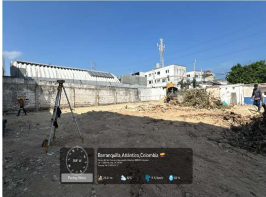
Imagen 130 Nivelación y replanteo
