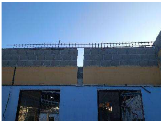
Imagen 80 Figurado y armado de acero
