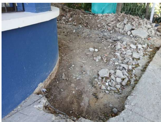
Imagen 26 Excavación a mano de zapata
