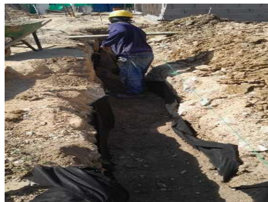
Imagen 21 Relleno de material seleccionado
