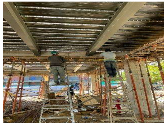
Imagen 121 Instalación de vigas IPE
