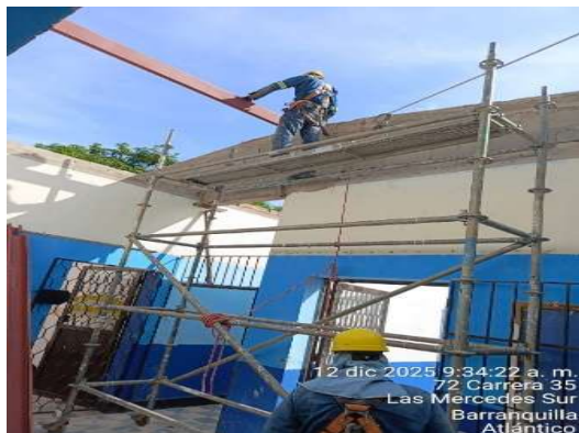
Imagen 34 Instalación de perfilera
