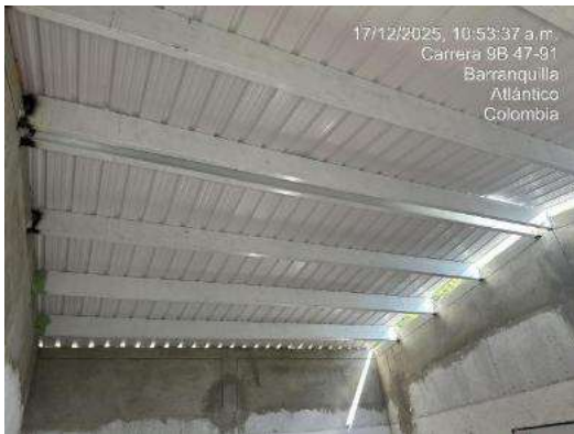
Imagen 94 Instalación de teja ecoroof
