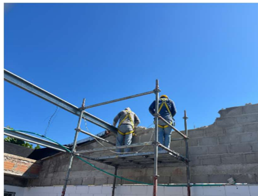
Imagen 73 Desmonte de perfilera
