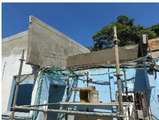
Imagen 88 Pañete exterior sobre muro
