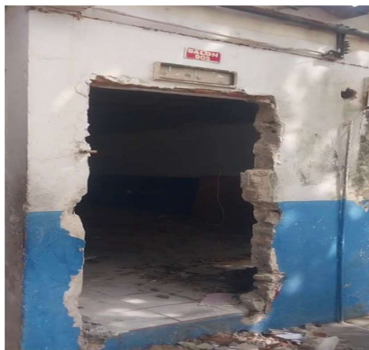
Imagen 99 Desmonte de puerta
