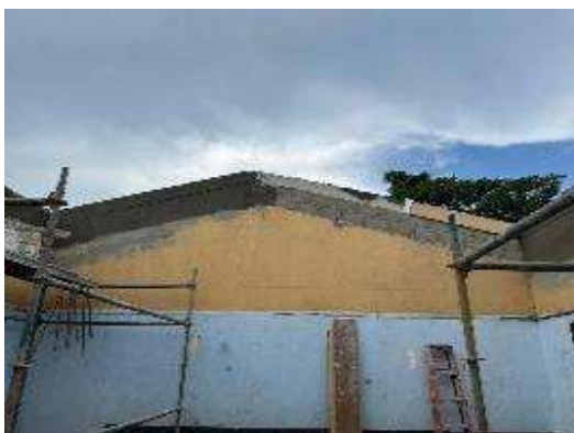
Imagen 82 Fundida de viga cinta
