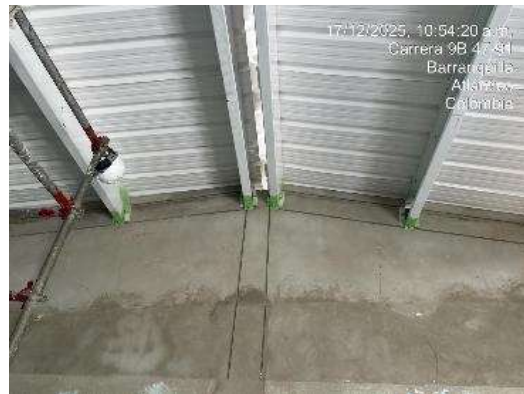
Imagen 95 Instalación de caballete
