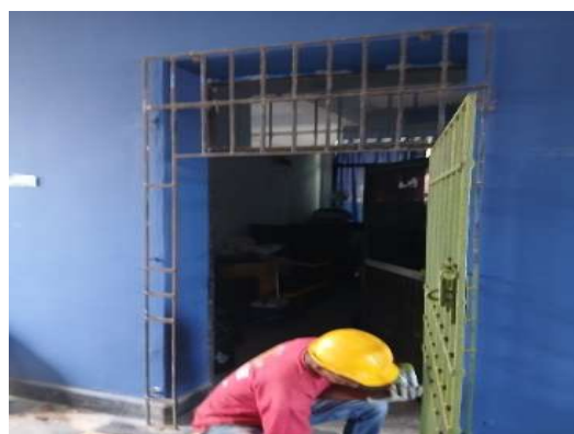
Imagen 37 Mantenimiento de rejas
