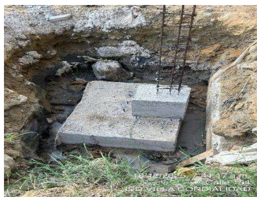
Imagen 111 Fundida de zapata
