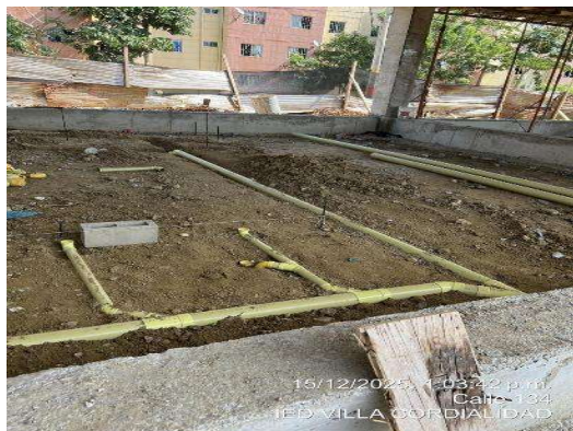
Imagen 106 Instalación de tubería sanitaria de 4"
