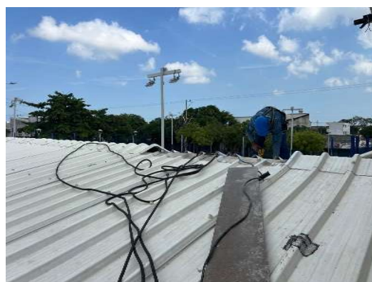
Imagen 19 Instalación de cubierta
