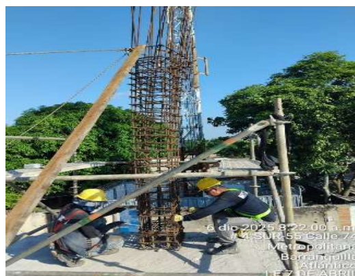
Imagen 125 Acero de refuerzo
