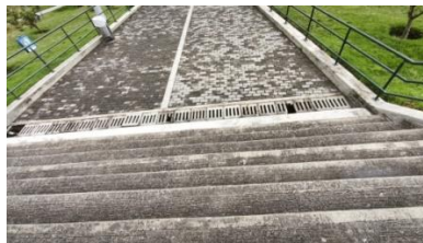
Fotos # 7,2, 3, mantenimiento de rejillas escaleras
