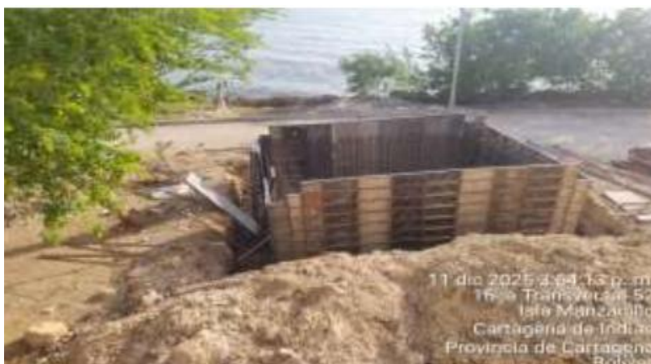
Figura N°5 Mantenimiento y mejora del sistema de agua potable
