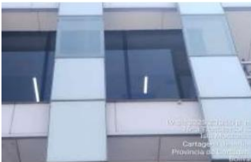
Figura N°6 Suministro e instalación de perfil gotero en aluminio anodizado, debidamente alineado y fijado.
