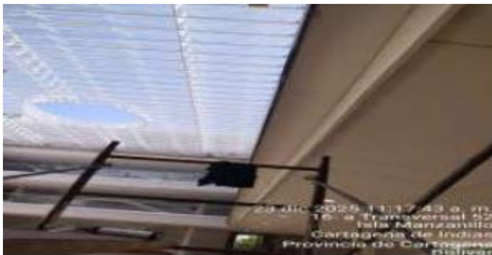
Figura N°4 Mantenimiento de estructuras metálicas, pasamanos y reposapiés
