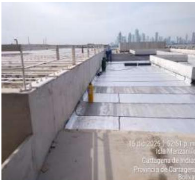
Figura N°2 Mantenimiento e impermeabilización de cubiertas planas en concreto
