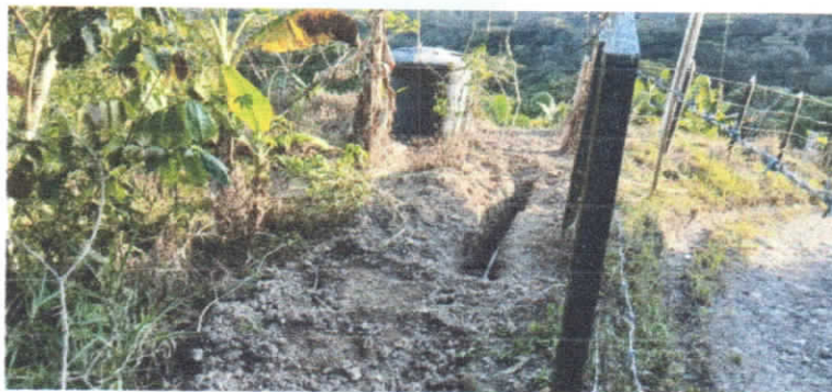
Ilustración 6. ACUEDUCTO CONFINES SEC. PALO BLANCO 2.02. (Autor)
