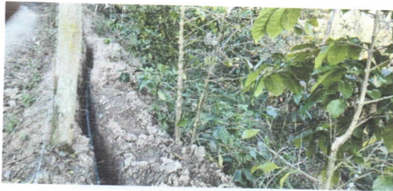
Ilustración 53. ACUEDUCTO CONFINES SEC. PALO BLANCO 6.01. (5) (Autor)
