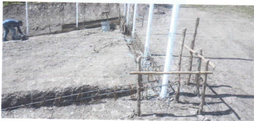
Ilustración 15. ACUEDUCTO CONFINES SEC. PALO BLANCO 3.02. (3) (Autor)
