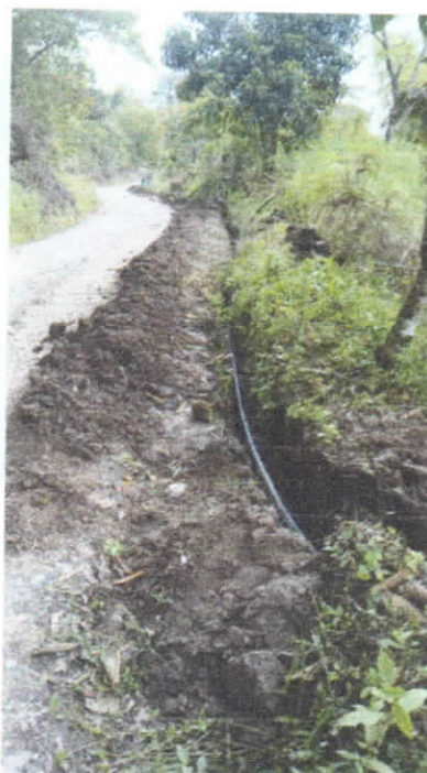
Ilustración 55. ACUEDUCTO CONFINES SEC. PALO BLANCO 6.02. (2) (Autor)
