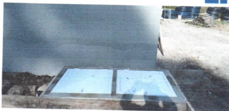
Ilustración 45. ACUEDUCTO CONFINES SEC. PALO BLANCO 5.10. (2) (Autor)
