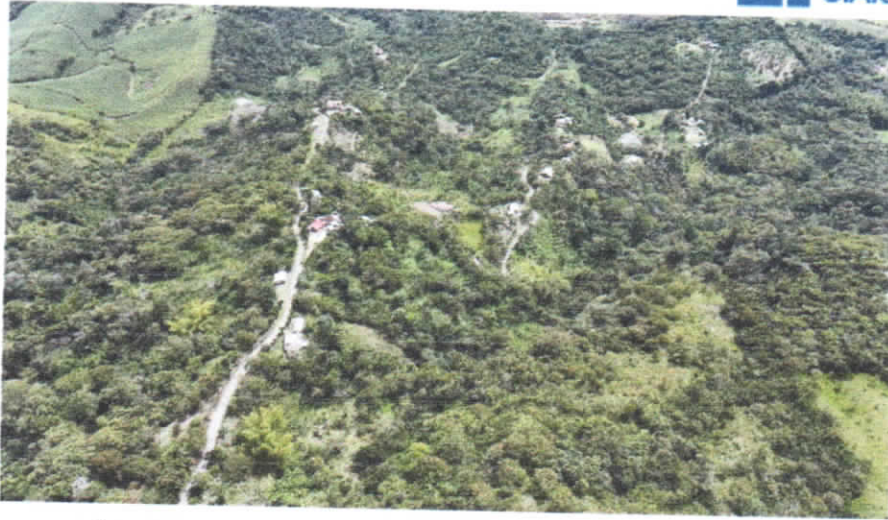
Ilustración 19. ACUEDUCTO CONFINES SEC. PALO BLANCO 4.01. (3) (Autor)
