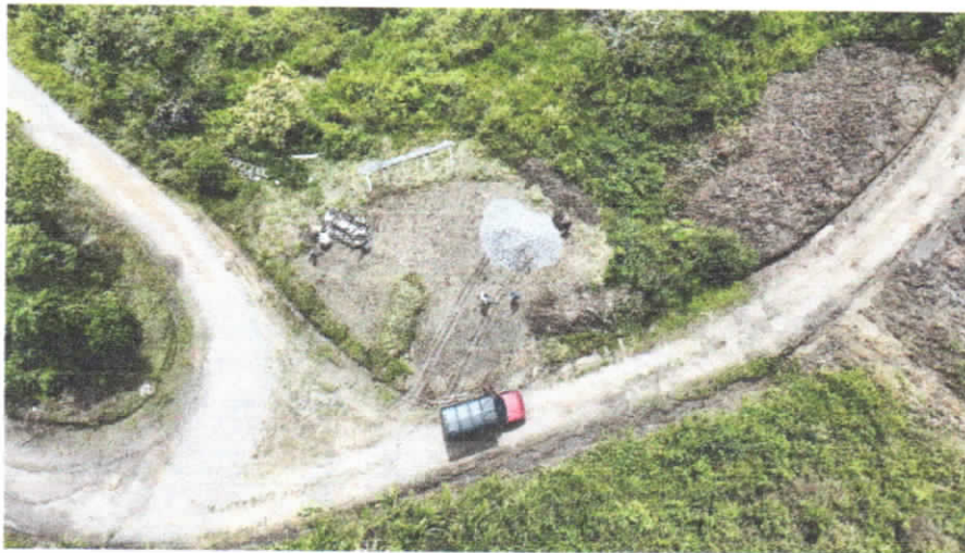
Ilustración 27. ACUEDUCTO CONFINES SEC. PALO BLANCO 5.01. (Autor)
