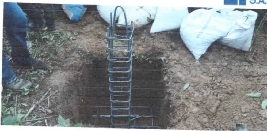
Ilustración 24. ACUEDUCTO CONFINES SEC. PALO BLANCO 4.05. (Autor)
