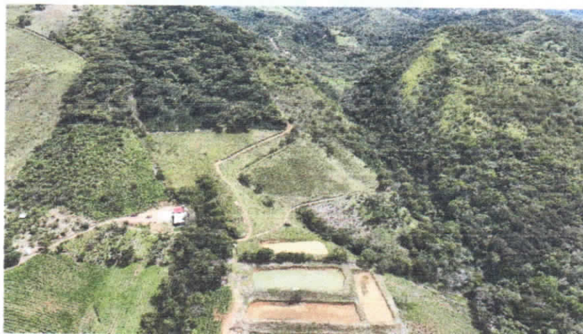
Ilustración 4. ACUEDUCTO CONFINES SEC. PALO BLANCO 2.01. (2) (Autor)
