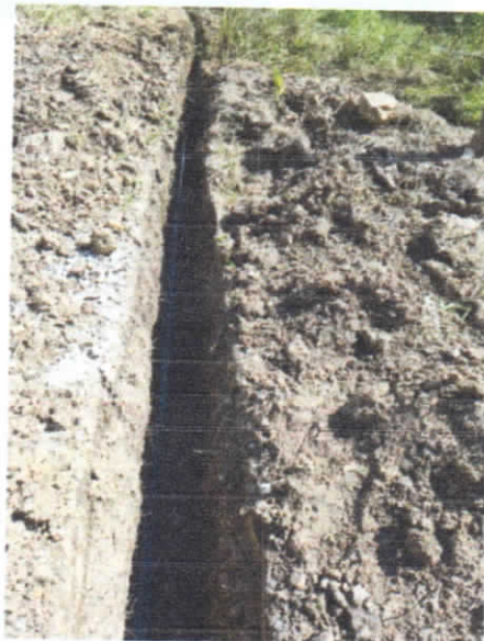
Ilustración 22. ACUEDUCTO CONFINES SEC. PALO BLANCO 4.03. (2) (Autor)
