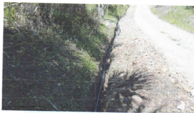
Ilustración 50. ACUEDUCTO CONFINES SEC. PALO BLANCO 6.01. (2) (Autor)
