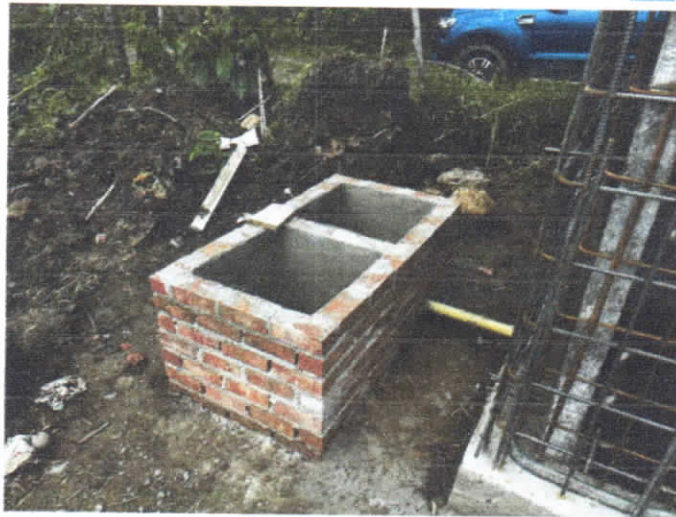
Ilustración 42. ACUEDUCTO CONFINES SEC. PALO BLANCO 5.09. (2) (Autor)
