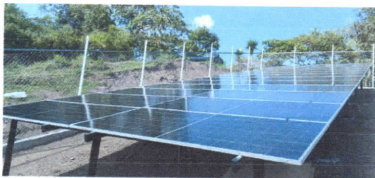
Ilustración 76. ACUEDUCTO CONFINES SEC. PALO BLANCO 7.08. (3) (Autor)
