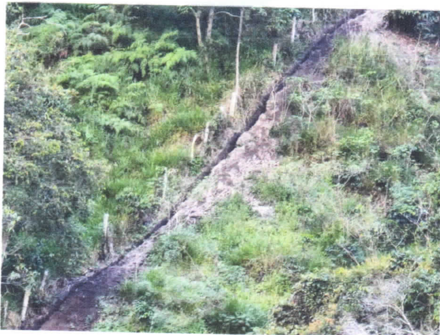
Ilustración 20. ACUEDUCTO CONFINES SEC. PALO BLANCO 4.02. (Autor)
