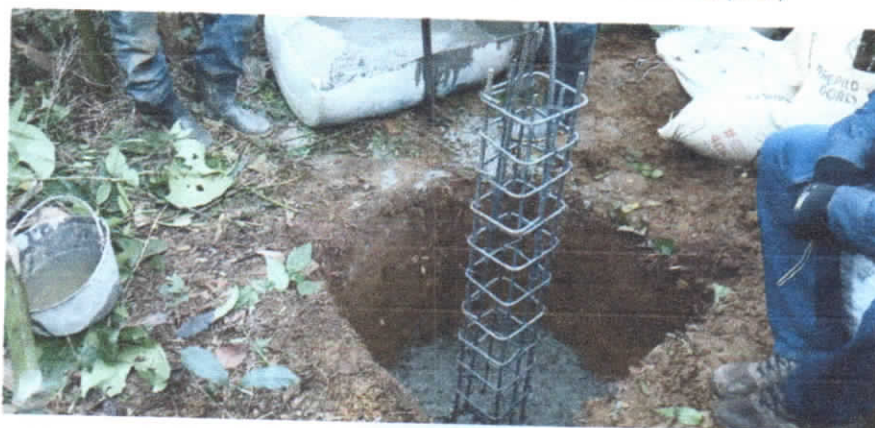
Ilustración 25. ACUEDUCTO CONFINES SEC. PALO BLANCO 4.05. (2) (Autor)
