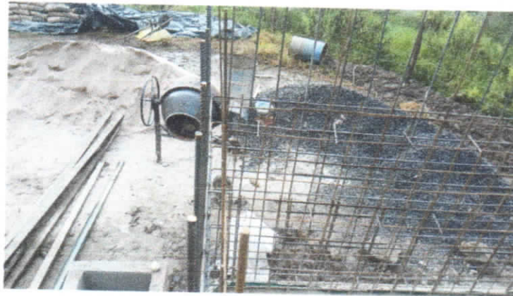
Ilustración 35. ACUEDUCTO CONFINES SEC. PALO BLANCO 5.05. (Autor)
