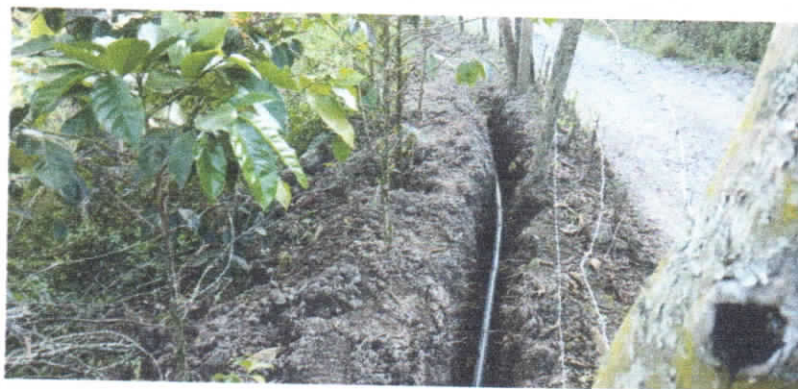
Ilustración 51. ACUEDUCTO CONFINES SEC. PALO BLANCO 6.01. (3) (Autor)
