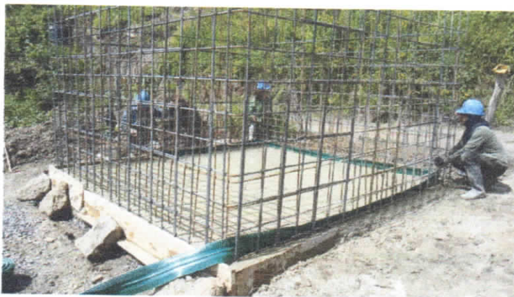
Ilustración 39. ACUEDUCTO CONFINES SEC. PALO BLANCO 5.08. (Autor)
