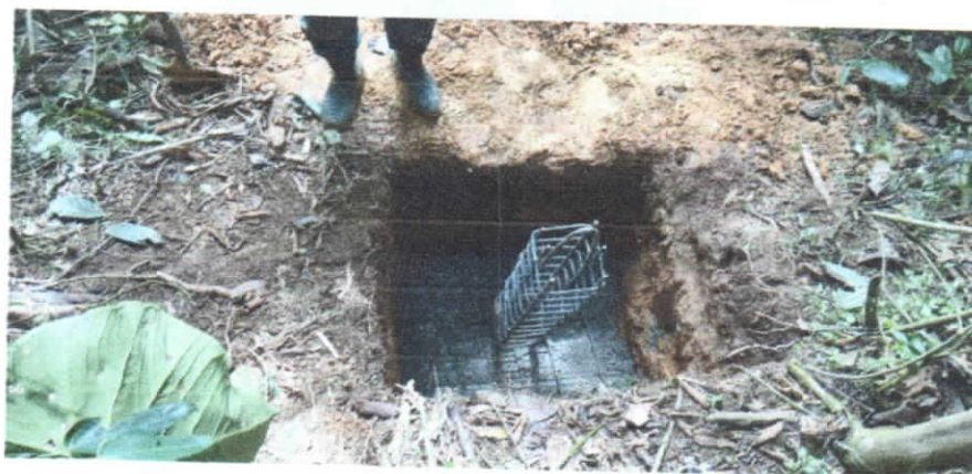
Ilustración 26. ACUEDUCTO CONFINES SEC. PALO BLANCO 4.05. (3) (Autor)
