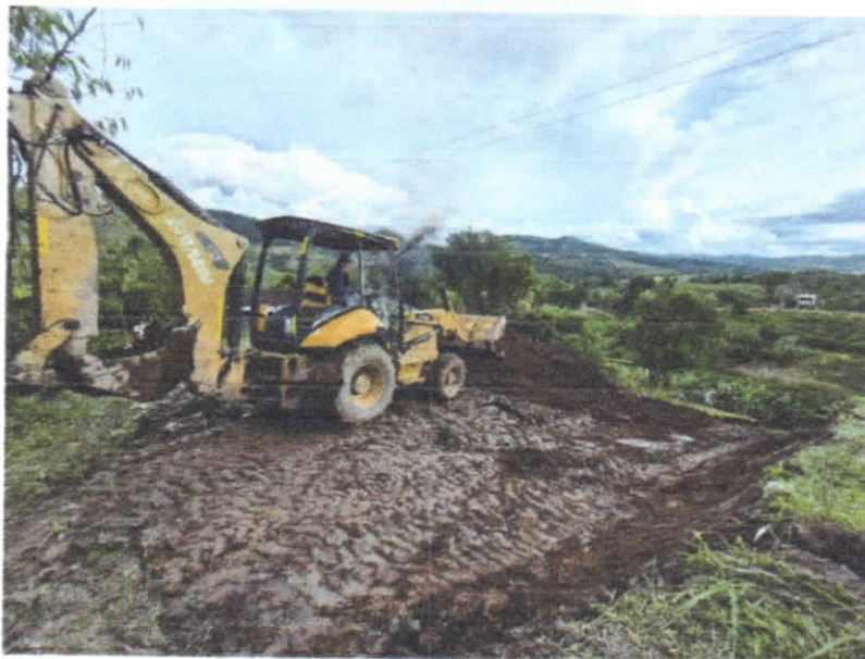
Ilustración 13. ACUEDUCTO CONFINES SEC. PALO BLANCO 3.02. (Autor)
