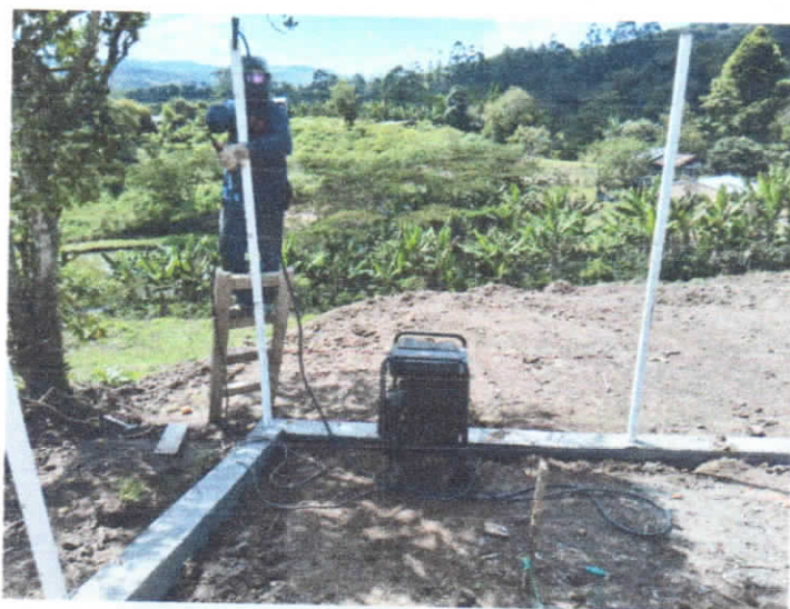
Ilustración 63. ACUEDUCTO CONFINES SEC. PALO BLANCO 7.03. (2) (Autor)
