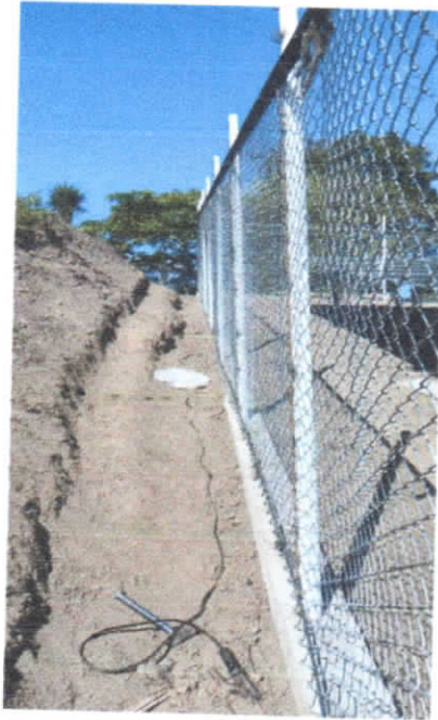
Ilustración 65. ACUEDUCTO CONFINES SEC. PALO BLANCO 7.03. (4) (Autor)
