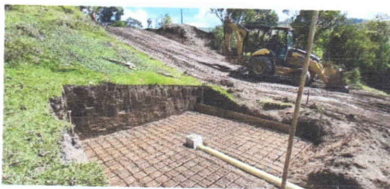
Ilustración 61. ACUEDUCTO CONFINES SEC. PALO BLANCO 7.02. (2) (Autor)
