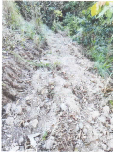
Ilustración 7. ACUEDUCTO CONFINES SEC. PALO BLANCO 2.08. (Autor)
