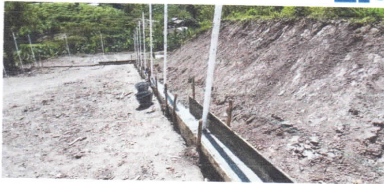
Ilustración 58. ACUEDUCTO CONFINES SEC. PALO BLANCO 7.01. (Autor)
