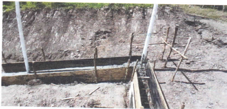
Ilustración 59. ACUEDUCTO CONFINES SEC. PALO BLANCO 7.01. (2) (Autor)
