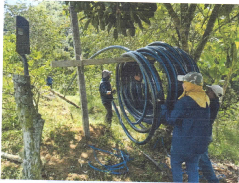
Ilustración 21. ACUEDUCTO CONFINES SEC. PALO BLANCO 4.03. (Autor)
