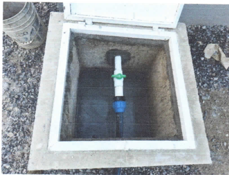
Ilustración 48. ACUEDUCTO CONFINES SEC. PALO BLANCO 5.11. (3) (Autor)
