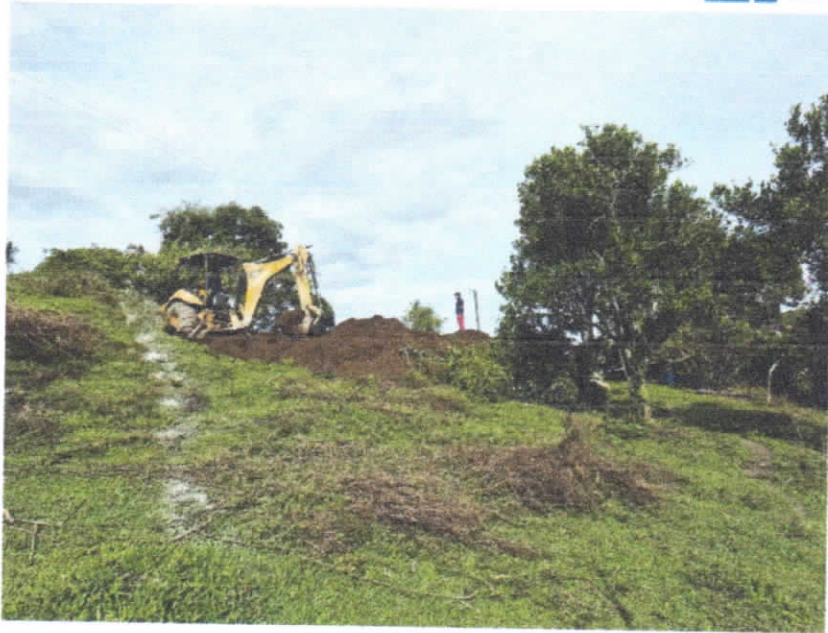
Ilustración 14. ACUEDUCTO CONFINES SEC. PALO BLANCO 3.02. (2) (Autor)
