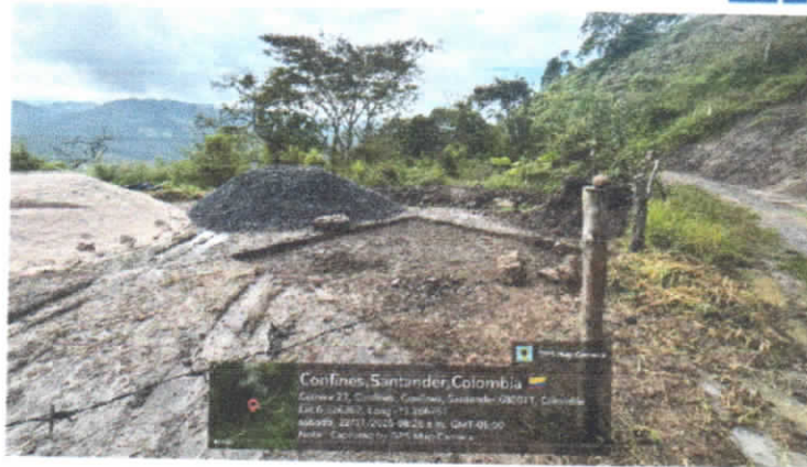
Ilustración 29. ACUEDUCTO CONFINES SEC. PALO BLANCO 5.02. (Autor)
