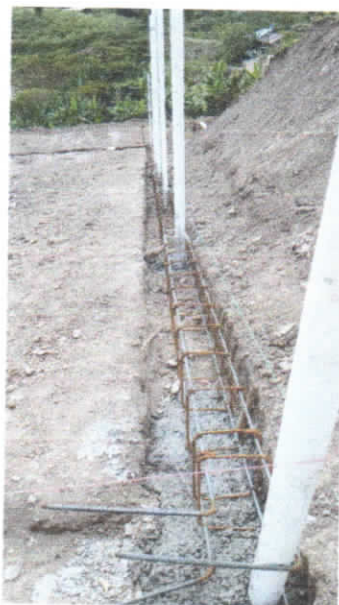
Ilustración 60. ACUEDUCTO CONFINES SEC. PALO BLANCO 7.02. (2) (Autor)
