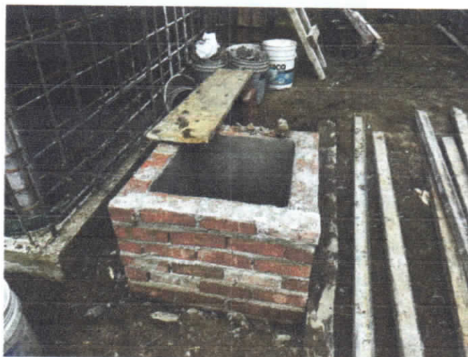
Ilustración 41. ACUEDUCTO CONFINES SEC. PALO BLANCO 5.09. (2) (Autor)
