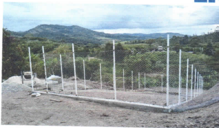
Ilustración 62. ACUEDUCTO CONFINES SEC. PALO BLANCO 7.03. (Autor)
