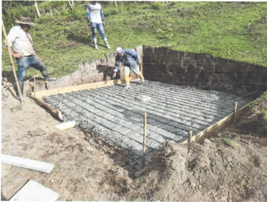
Ilustración 9. ACUEDUCTO CONFINES SEC. PALO BLANCO 2.09. (Autor)
