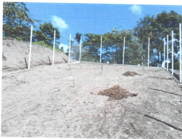
Ilustración 64. ACUEDUCTO CONFINES SEC. PALO BLANCO 7.03. (3) (Autor)
