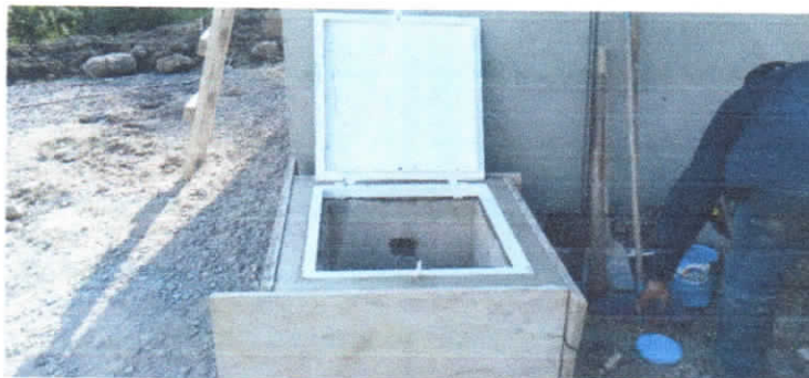
Ilustración 44. ACUEDUCTO CONFINES SEC. PALO BLANCO 5.10. (Autor)
