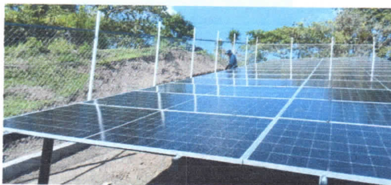
Ilustración 75. ACUEDUCTO CONFINES SEC. PALO BLANCO 7.08. (2) (Autor)
