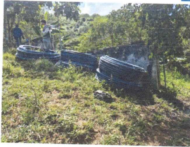
Ilustración 56. ACUEDUCTO CONFINES SEC. PALO BLANCO 6.02. (3) (Autor)
