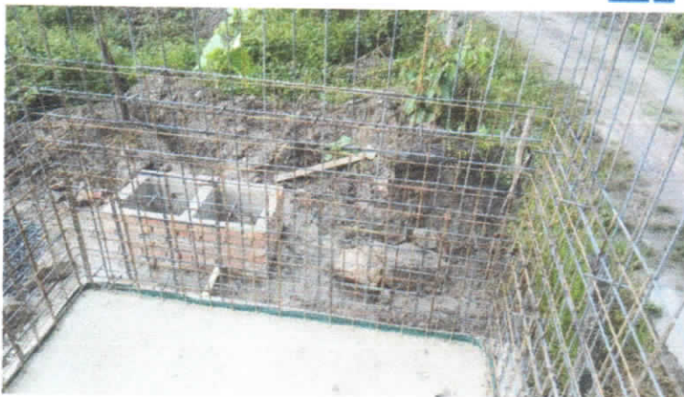
Ilustración 40. ACUEDUCTO CONFINES SEC. PALO BLANCO 5.08. (2) (Autor)
