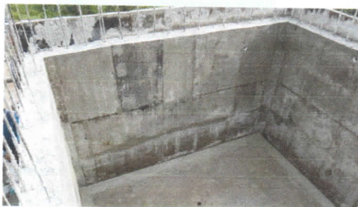
Ilustración 33. ACUEDUCTO CONFINES SEC. PALO BLANCO 5.04. (2) (Autor)
