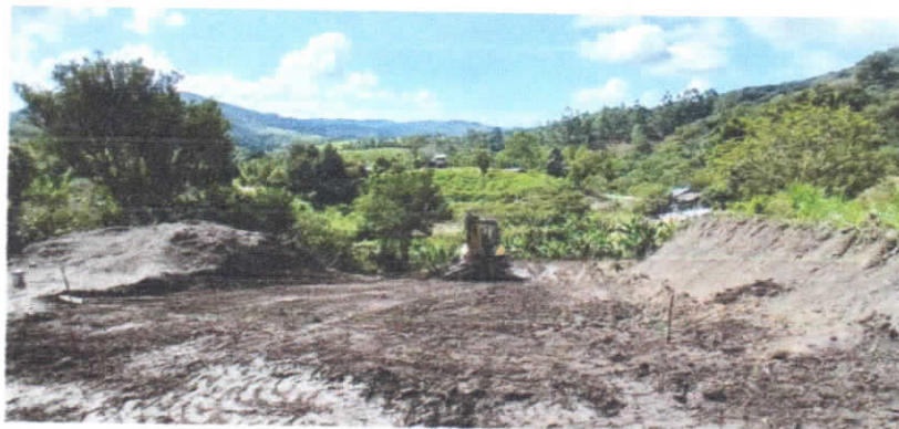
Ilustración 16. ACUEDUCTO CONFINES SEC. PALO BLANCO 3.02. (4) (Autor)
