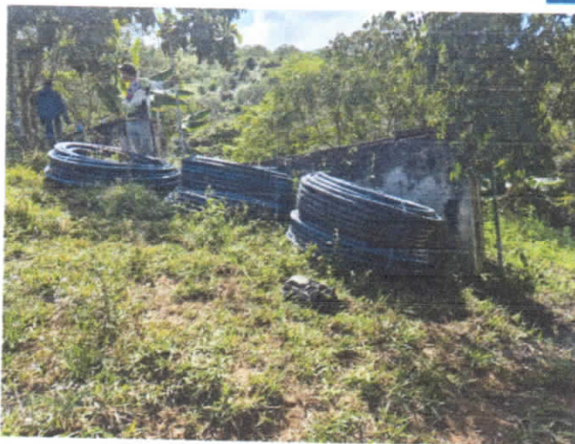
Ilustración 71. ACUEDUCTO CONFINES SEC. PALO BLANCO 7.07. (2) (Autor)
