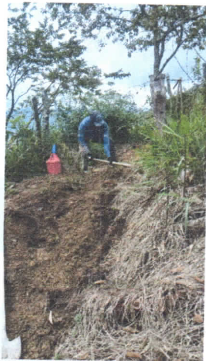
Ilustración 23. ACUEDUCTO CONFINES SEC. PALO BLANCO 4.04. (Autor)
