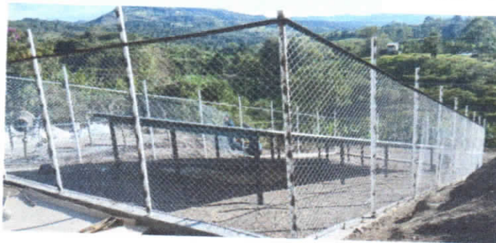
Ilustración 66. ACUEDUCTO CONFINES SEC. PALO BLANCO 7.03. (5) (Autor)
