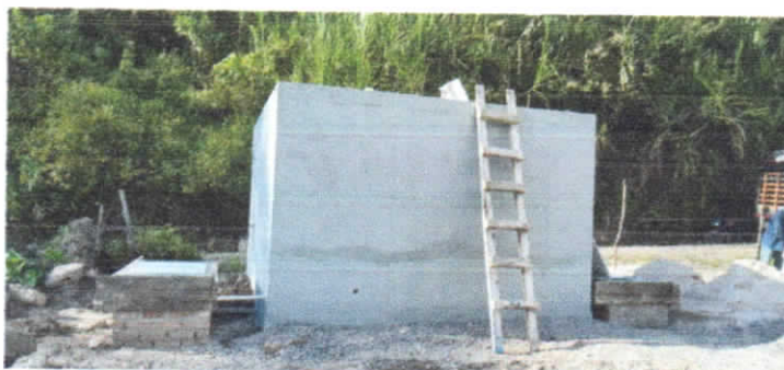
Ilustración 34. ACUEDUCTO CONFINES SEC. PALO BLANCO 5.04. (3) (Autor)
