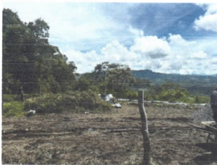
Ilustración 28. ACUEDUCTO CONFINES SEC. PALO BLANCO 5.01. (2) (Autor)
