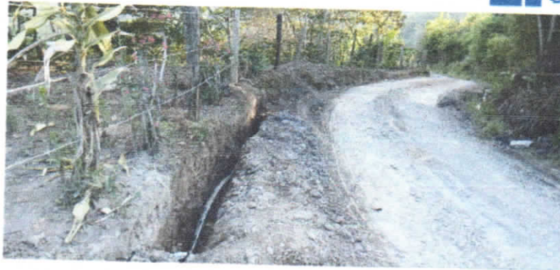
Ilustración 52. ACUEDUCTO CONFINES SEC. PALO BLANCO 6.01. (4) (Autor)
