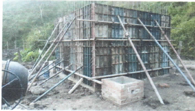
Ilustración 43. ACUEDUCTO CONFINES SEC. PALO BLANCO 5.09. (3) (Autor)
