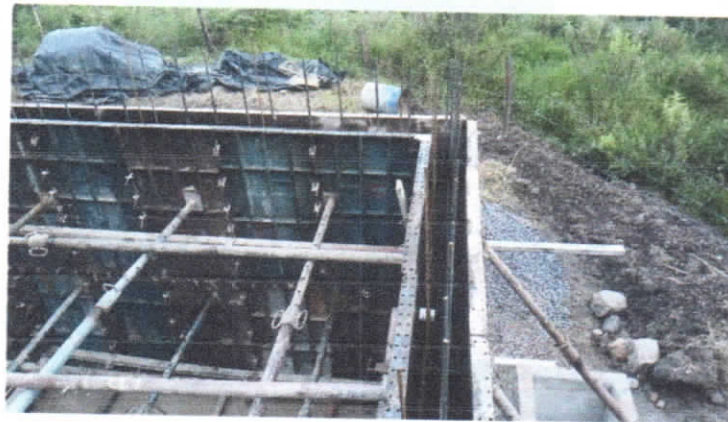
Ilustración 36. ACUEDUCTO CONFINES SEC. PALO BLANCO 5.05. (2) (Autor)
