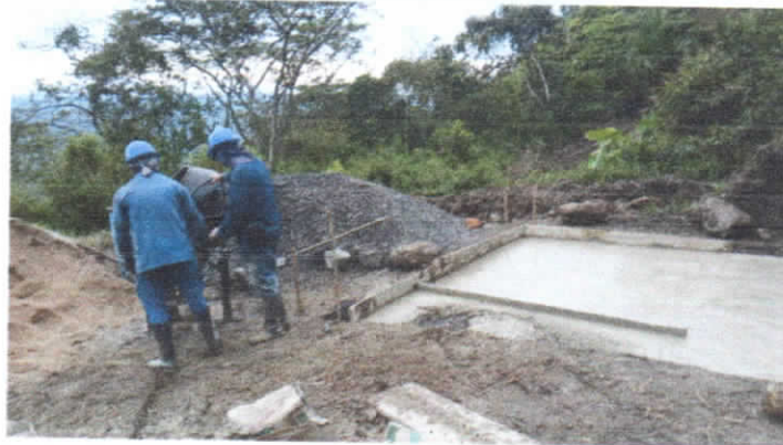
Ilustración 30. ACUEDUCTO CONFINES SEC. PALO BLANCO 5.03. (Autor)
