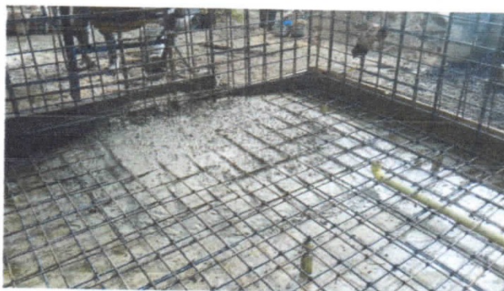
Ilustración 32. ACUEDUCTO CONFINES SEC. PALO BLANCO 5.04. (Autor)
