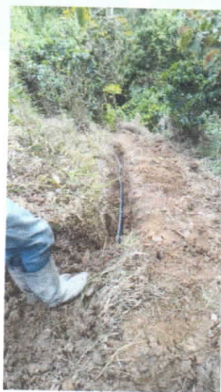
Ilustración 4. ACUEDUCTO CONFINES SEC. PALO BLANCO 2.02. (2) (Autor)
