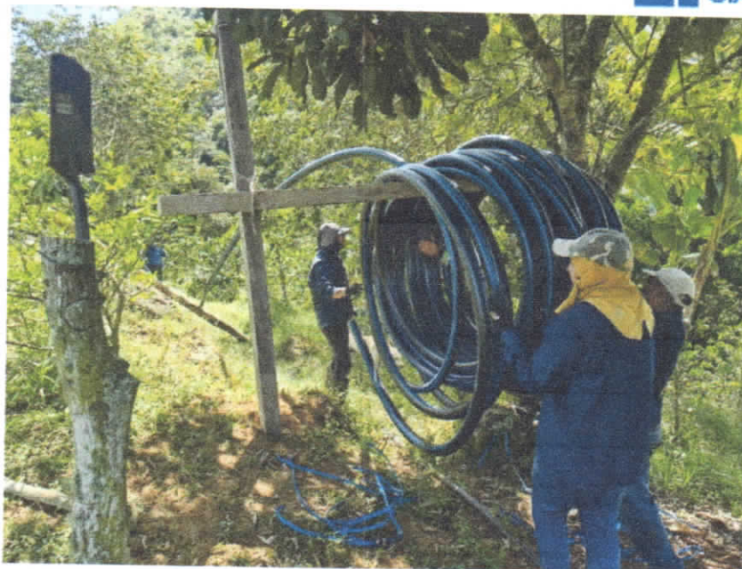
Ilustración 10. ACUEDUCTO CONFINES SEC. PALO BLANCO 4.03. (Autor)
