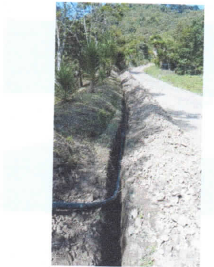
Ilustración 14. ACUEDUCTO CONFINES SEC. PALO BLANCO 6.01. (2) (Autor)
