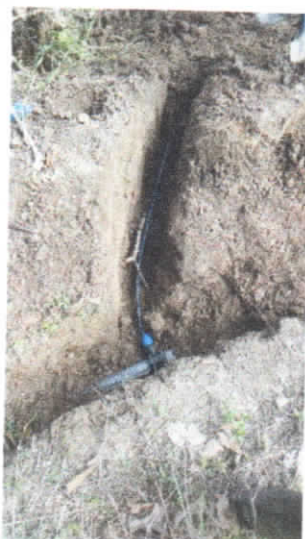
Ilustración 15. ACUEDUCTO CONFINES SEC. PALO BLANCO 6.01. (3) (Autor)
