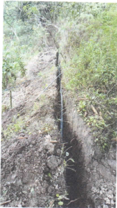
Ilustración 9. ACUEDUCTO CONFINES SEC. PALO BLANCO 4.02. (2) (Autor)
