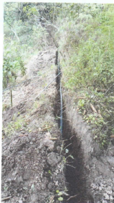
Ilustración 11. ACUEDUCTO CONFINES SEC. PALO BLANCO 4.03. (2) (Autor)
