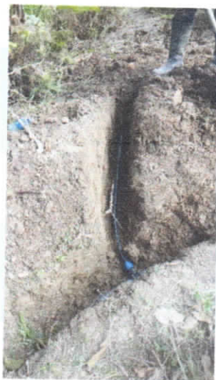
Ilustración 16. ACUEDUCTO CONFINES SEC. PALO BLANCO 6.01. (4) (Autor)
