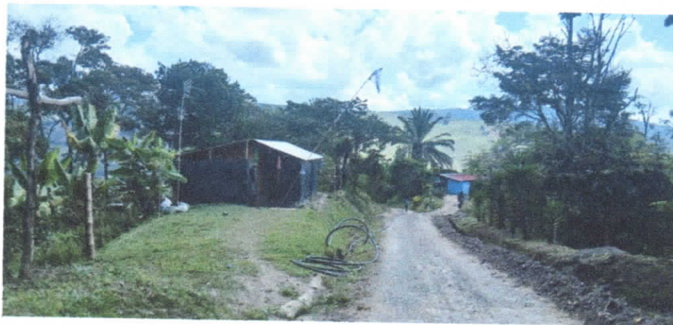
Ilustración 18. ACUEDUCTO CONFINES SEC. PALO BLANCO 6.02. (2) (Autor)
