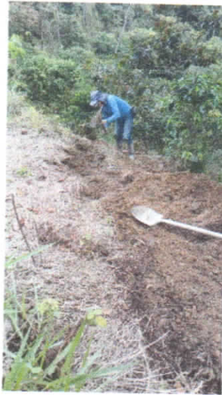
Ilustración 7. ACUEDUCTO CONFINES SEC. PALO BLANCO 2.08. (2) (Autor)
