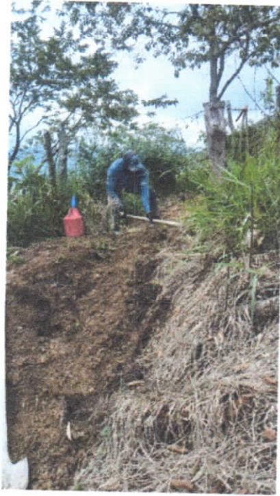
Ilustración 12. ACUEDUCTO CONFINES SEC. PALO BLANCO 4.04. (Autor)
