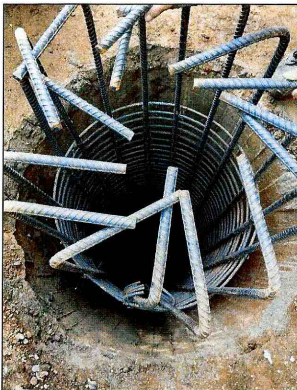
Imagen 9: Emplazamiento de refuerzo de cimentación.
