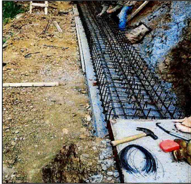
Imagen 2: Armado de acero de refuerzo.
