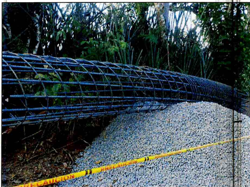
Imagen 7: Armado de acero de refuerzo para cimentación.
