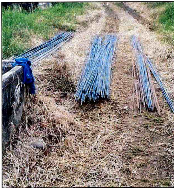
Imagen 4: Acero en obra.
