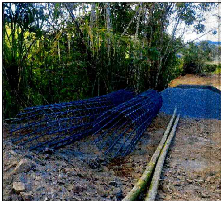
Imagen 6: Armado de acero de refuerzo para cimentación.
