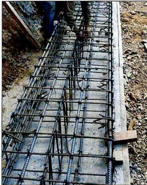
Imagen 3: Armado de acero de refuerzo.
