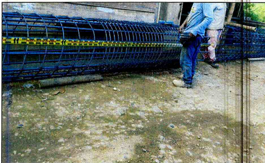
Imagen 8: Armado de acero de refuerzo para cimentación.
