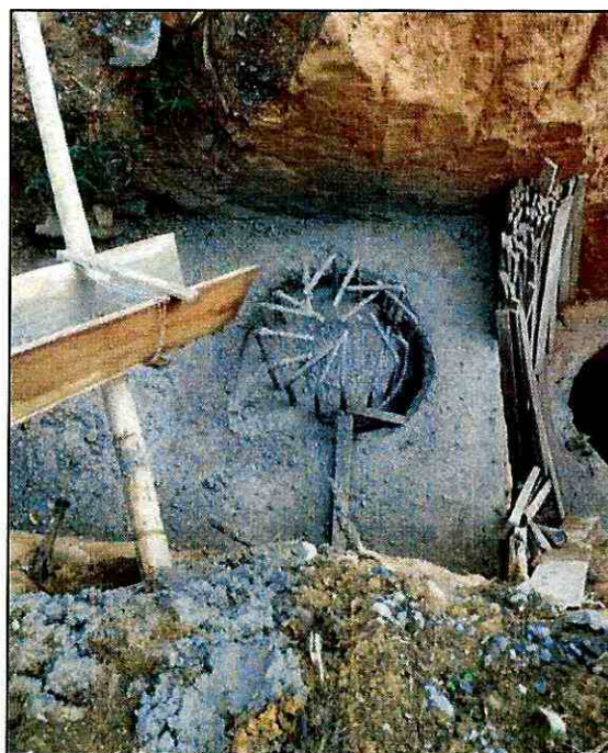
Imagen 11: Fundición de cimentación.
