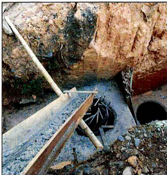
Imagen 12: Fundición de cimentación.
