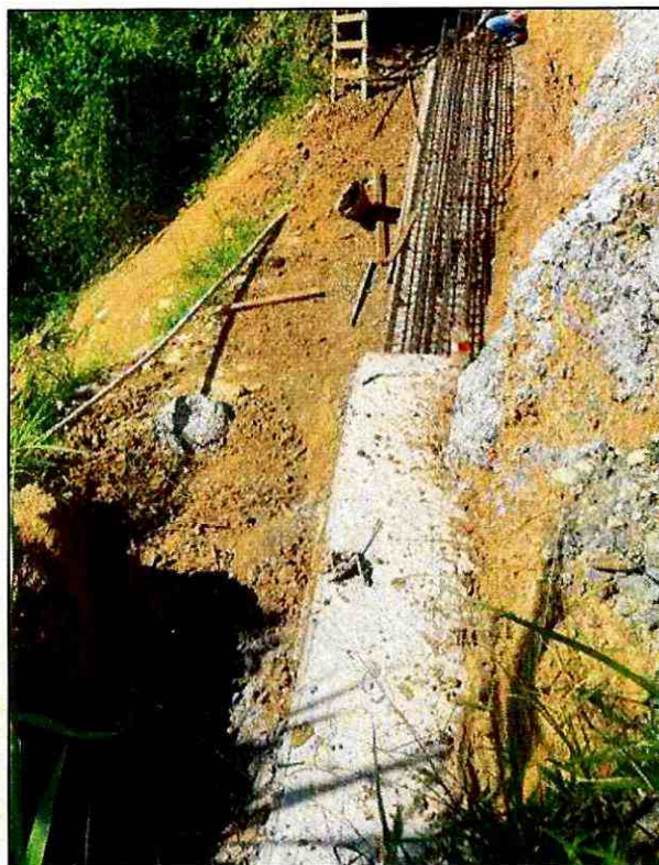
Imagen 5: Armado de acero de refuerzo.
