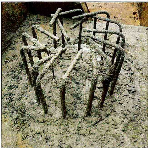
Imagen 10: Fundición de cimentación.
