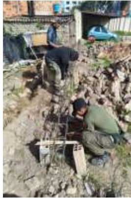
Pie de Foto: Adecuación y amarre de varillas para vigas y columnas
