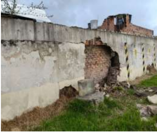
Pie de Foto: Muro conjunto de las nieves deteriorado fisurado presenta caída y riesgo al personal del conjunto.
