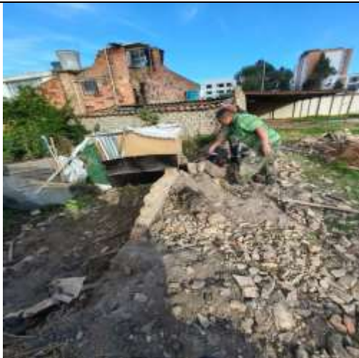
Pie de Foto: Demolición de muro deteriorado
