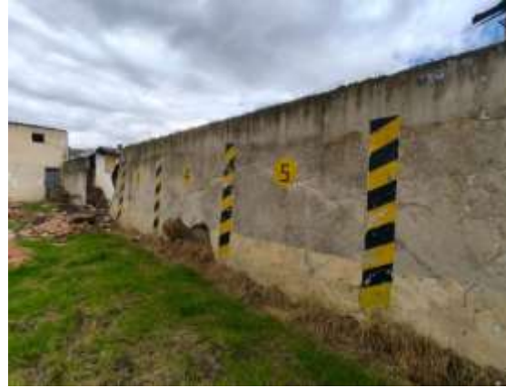
Pie de Foto: Muro conjunto de las nieves deteriorado fisurado presenta caída y riesgo al personal del conjunto.
