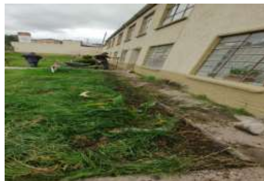
Pie de Foto: Demolición de anden pasillo deteriorado
