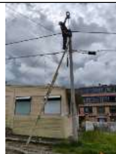
Pie de Foto: Instalación de paneles reflectores y bombillas solares
