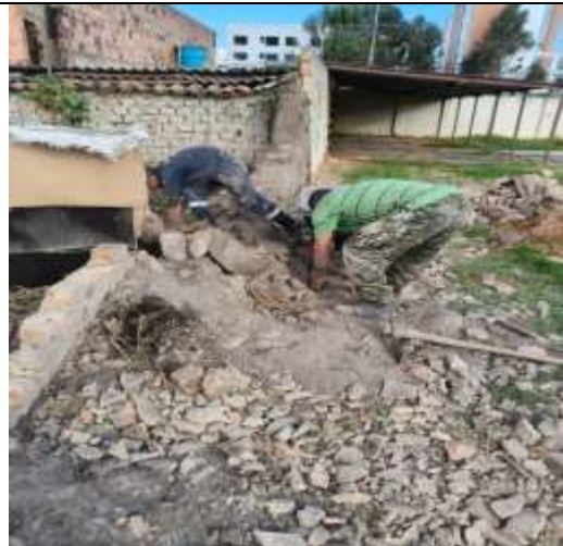
Pie de Foto: Demolición de muro deteriorado
