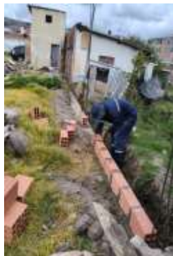
Pie de Foto: Construcción de muro en bloque N05
