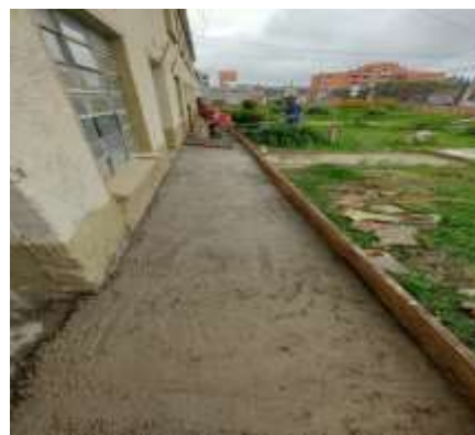
Pie de Foto: Demolición de anden pasillo deteriorado
