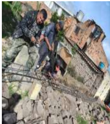
Pie de Foto: Adecuación y amarre de varillas para vigas y columnas
