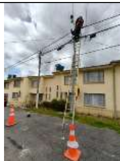
Pie de Foto: Instalación de paneles reflectores y bombillas solares
