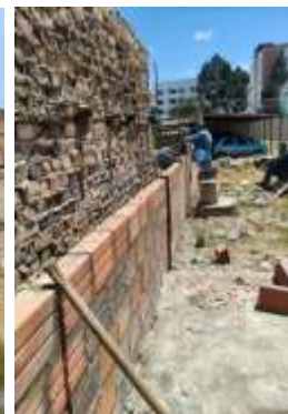
Pie de Foto: Construcción de muro en bloque N05
