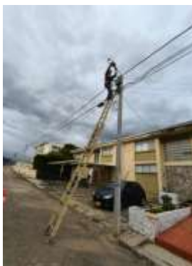
Pie de Foto: Instalación de paneles reflectores y bombillas solares.
