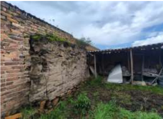
Pie de Foto: Muro conjunto de las nieves deteriorado fisurado presenta caída y riesgo al personal del conjunto y danos a los vecinos colindantes.
