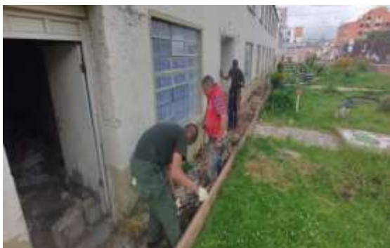
Pie de Foto: Demolición de anden pasillo deteriorado.
