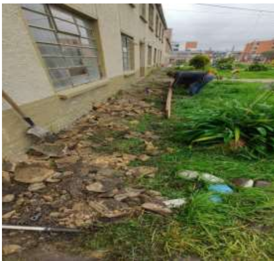
Pie de Foto: Demolición de anden pasillo deteriorado.
