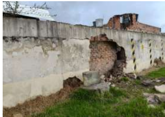
Pie de Foto: Muro conjunto de las nieves deteriorado fisurado presenta caída y riesgo al personal del conjunto y danos a los vecinos colindantes.
