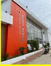
4 DE NOVIEMBRE DE 2025 PINTURA DE FACHADA_ FACHADA
