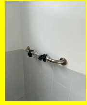
1 DE DICIEMBRE DE 2025 INSTALACIÓN DE PASAMANOS_ BAÑO H URGENCIAS
