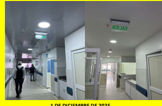
1 DE DICIEMBRE DE 2025 INSTALACIÓN DE PANELES LED_ PASILLO URGENCIAS_ PASILLO SALA DE PARTOTABLERO
