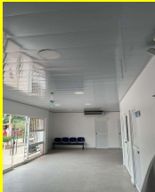
4 DE NOVIEMBRE DE 2025 INSTALACION DE CIELO RASO_ ÁREA DE URGENCIAS
