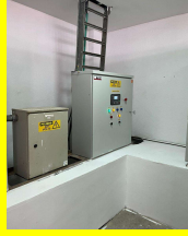
4 DE NOVIEMBRE DE 2025 INSTALACIÓN DE TRANSFERENCIA AUTOMÁTICA_ TABLERO
